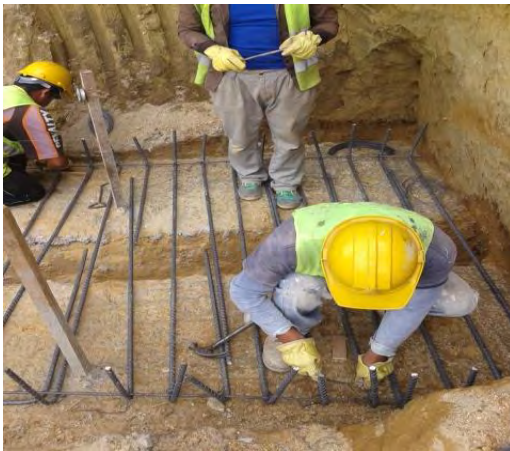
Ilustración 23. Colocación de acero
