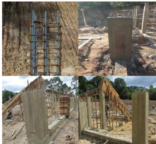
Figura 5. Columnas (50X55cm) de concreto 3000 PSI
