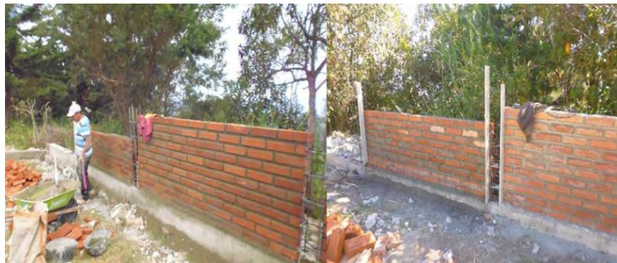
Figura 23. Muro en ladrillo
