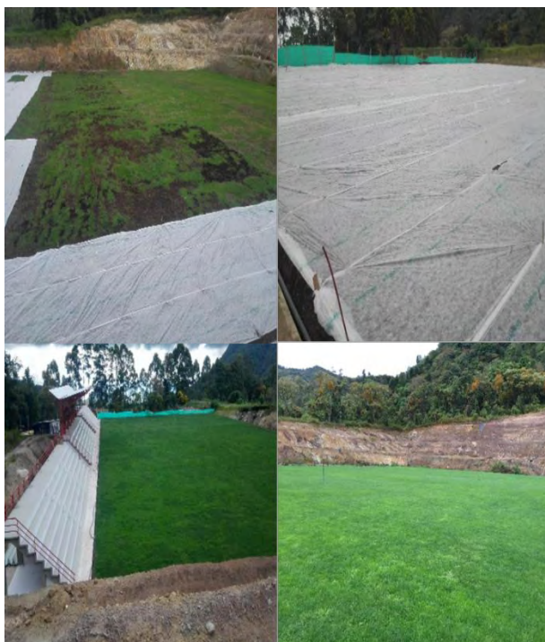
Figura 34. Instalaciones de césped
