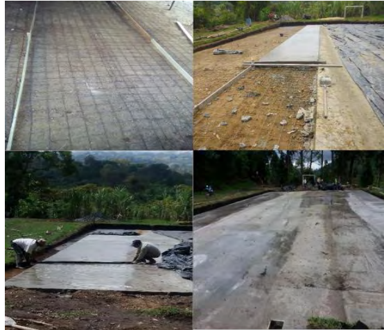
Figura 28. Placa de piso en concreto 3000 PSI
