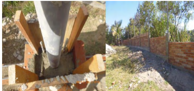
Figura 24. Suministro e Instalación de tubo galvanizado
