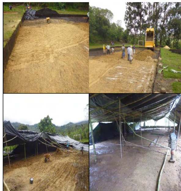
Figura 27. Base en recebo compactado
