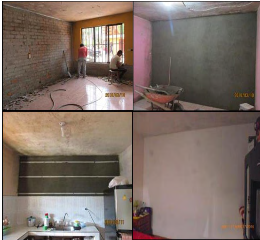
Figura 47. Casa de habitación de la señora Stella Urbano (después)
