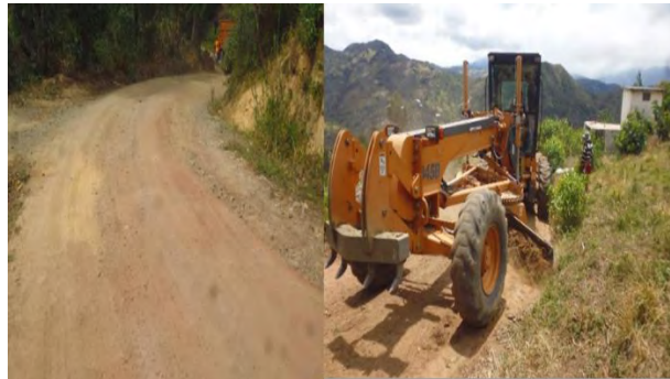
Figura 37. Desmonte, limpieza de cunetas y alcantarillas y suministro de material recebo en vías terciarias
