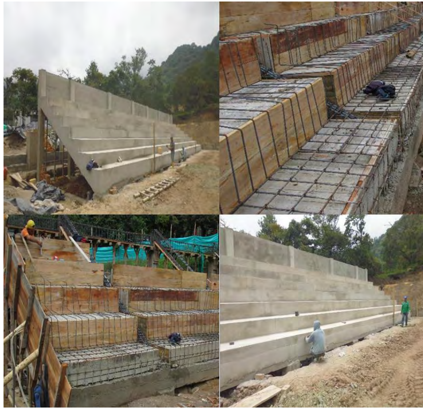
Figura 9. Losas de gradería en concreto 3000 PSI
