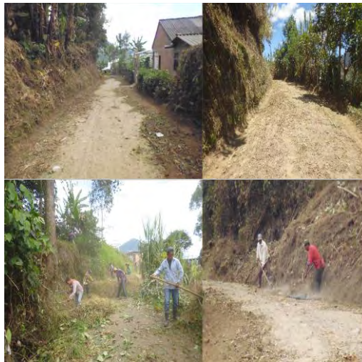
Figura 35. Desmonte, limpieza de cunetas y alcantarillas en vías terciarias
