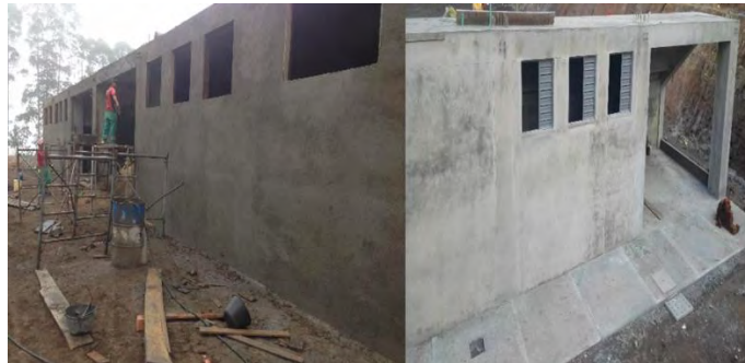
Figura 30. Repello para muros y estructura
