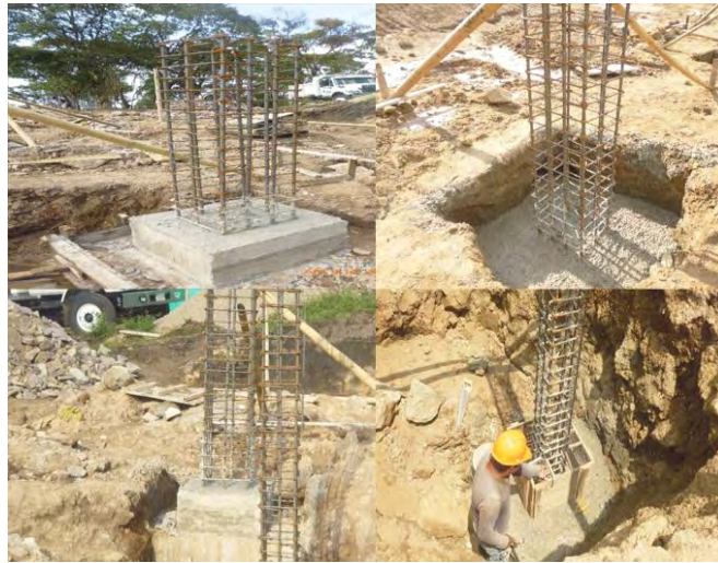
Figura 3. Fundiciones de zapatas y pedestales
