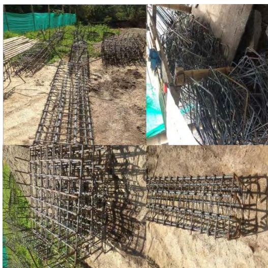
Figura 13. Acero de refuerzo PDR 60
