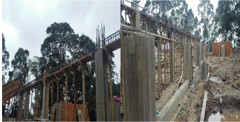
Figura 7. Vigas aéreas (25X30cm) en concreto 3000 PSI
