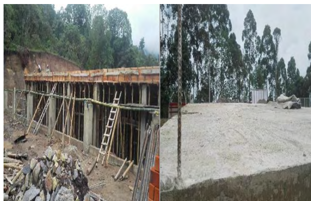
Figura 12. Concreto 3000 PSI tarima
