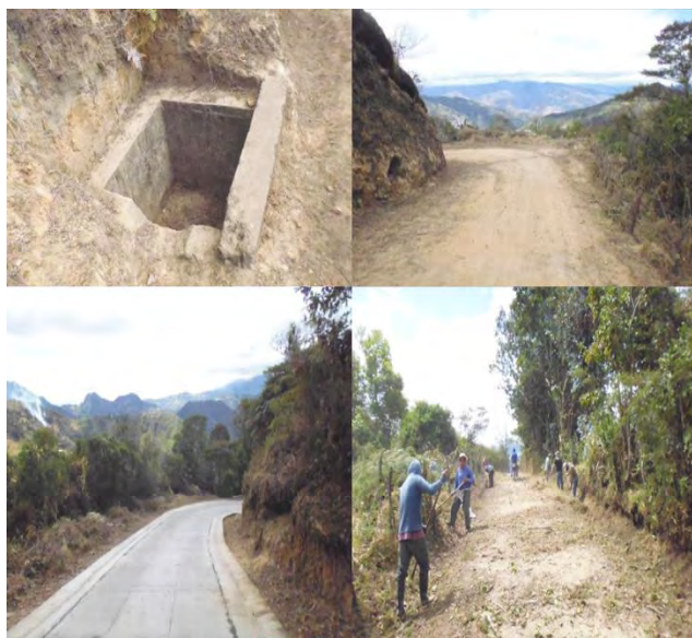
Figura 36. Desmonte, limpieza de cunetas y alcantarillas en vías terciarias
