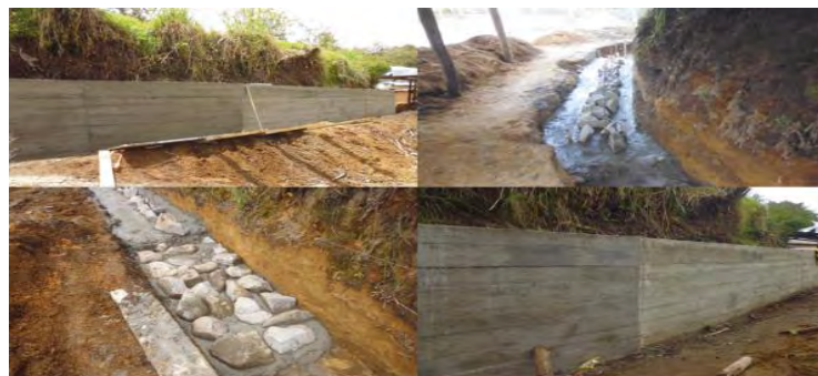
Figura 25. Muro en concreto ciclópeo
