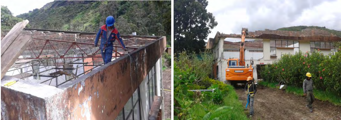
Figuras 19-20. Demolición de construcciones de edificaciones entre 2 y 3 pisos
