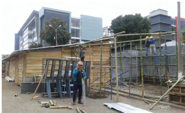
Figura 31. Descapote y conformación de terreno para losa de contrapiso
