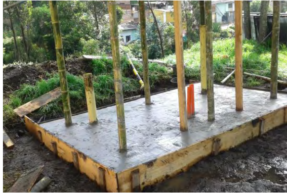
Figura 7. Punto hidráulico de ½”, puntos sanitarios 2”, red sanitaria 4” y placa contrapiso.
