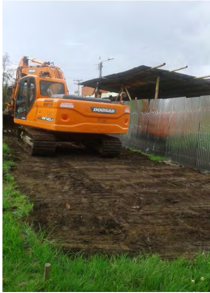
Figura 2. Perfilado y adecuación de lote para campamentos (incluye desalojo)
