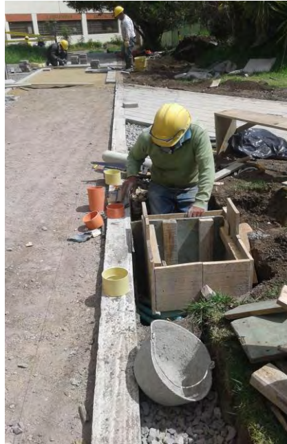
Figura 14. Sendero peatonal en adoquín y sumidero en concreto 3000 psi 60x 60 x 80 cm codo pvc 4" (incluye excavación)
