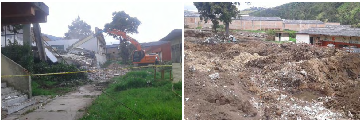
Figuras 21-22. Demolición de construcciones de edificaciones entre 2 y 3 pisos
