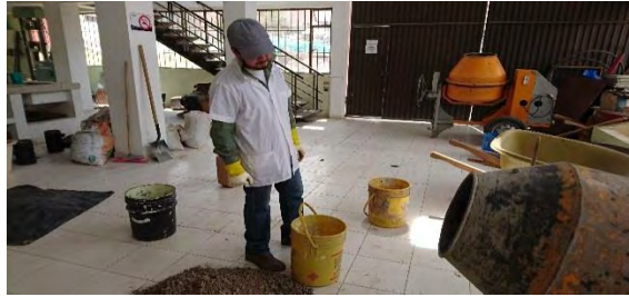
Figura 44. Mezcla de concreto
