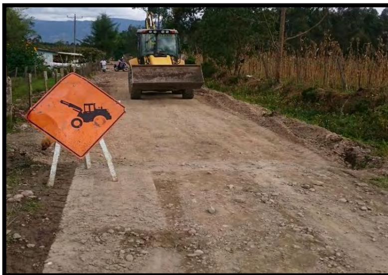
Ilustración 11. Inicio de obra del tramo 1
