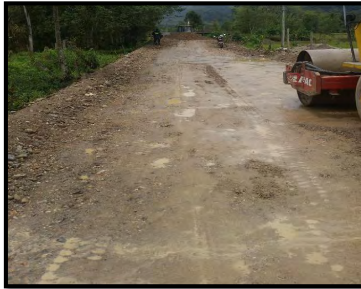
Ilustración 19. Compactación de la sub base
