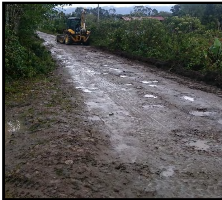
Ilustración 36. Inicio de excavación tramo 2
