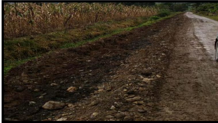
Ilustración 15. Cajeo lateral tramo 1
