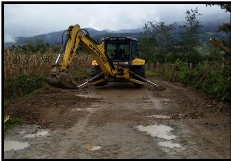
Ilustración 16. Relleno con material seleccionado
