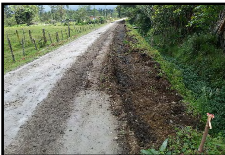
Ilustración 12. Inicio de excavación tramo 1
