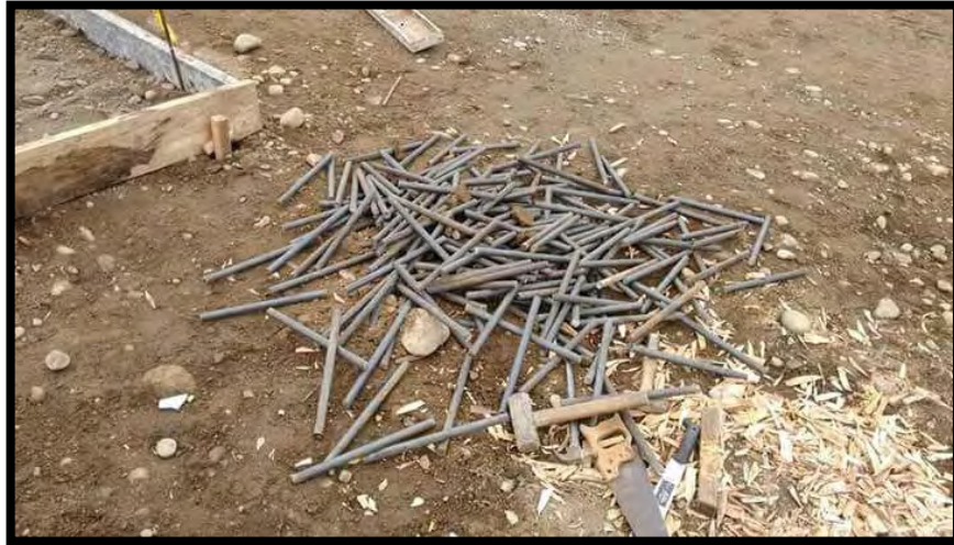
Ilustración 21. Corte acero de refuerzo (dovelas)
