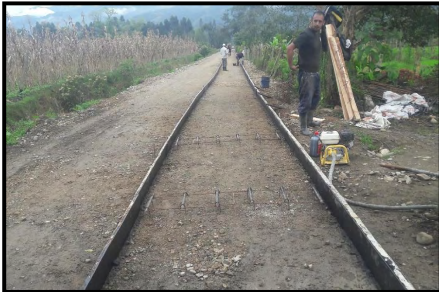
Ilustración 22. Instalación de dovelas
