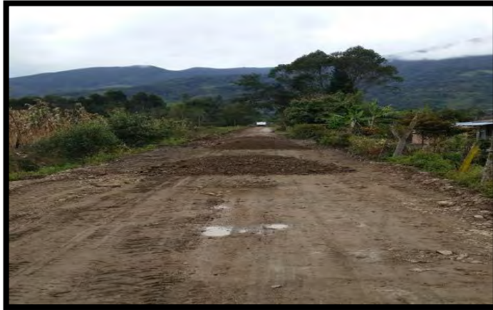
Ilustración 17. Mejoramiento de subrasante con material de préstamo
