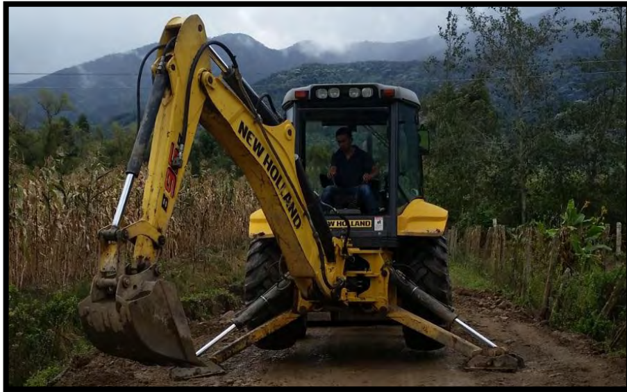
Ilustración 5. Retroexcavadora New Holland B95B
