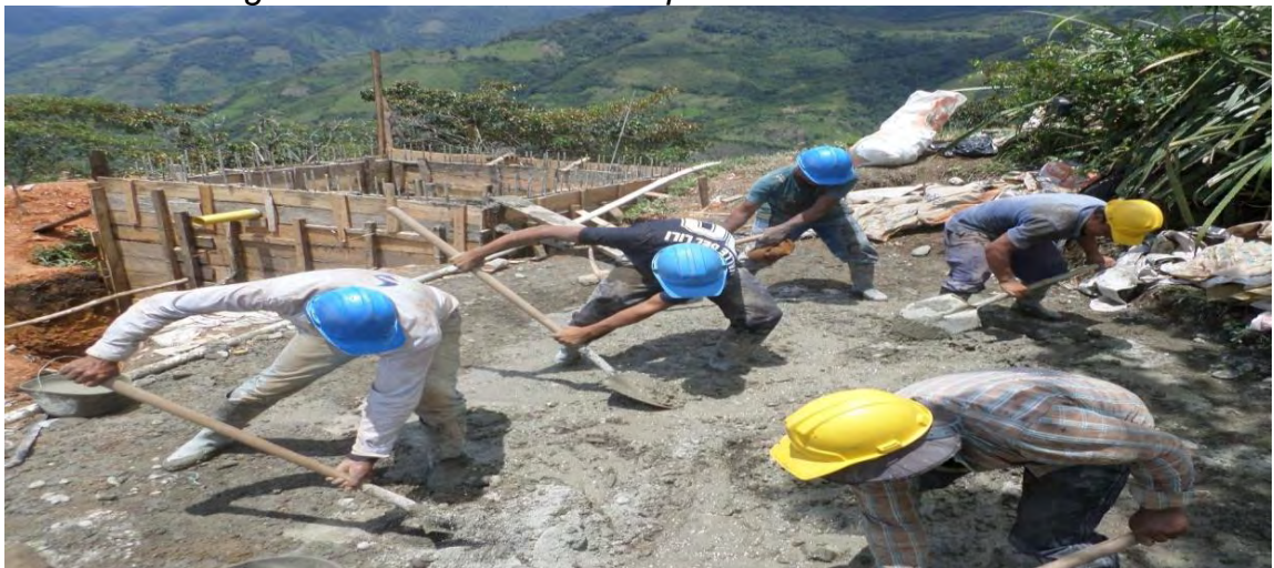
Figura 13. Fundición del tanque de almacenamiento
