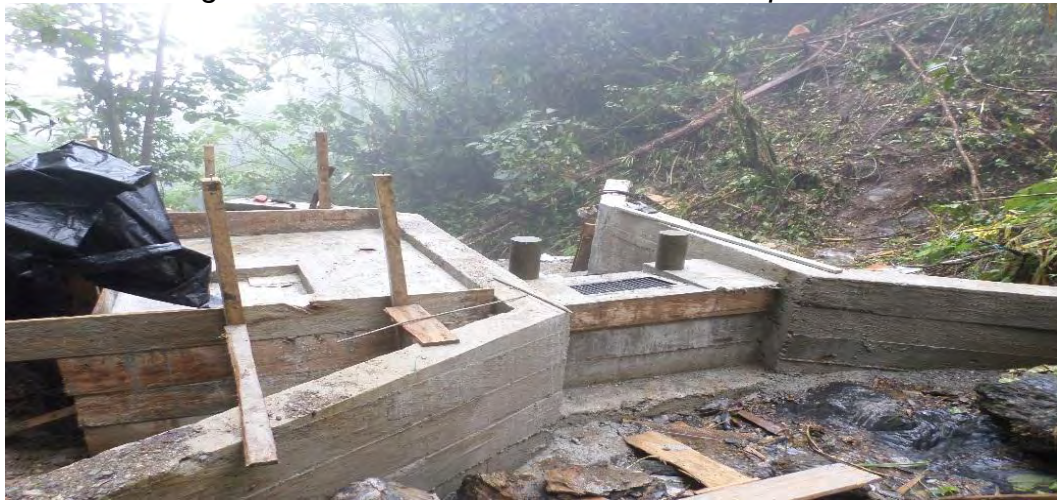
Figura 15. Bocatoma desencofrada -vista posterior
