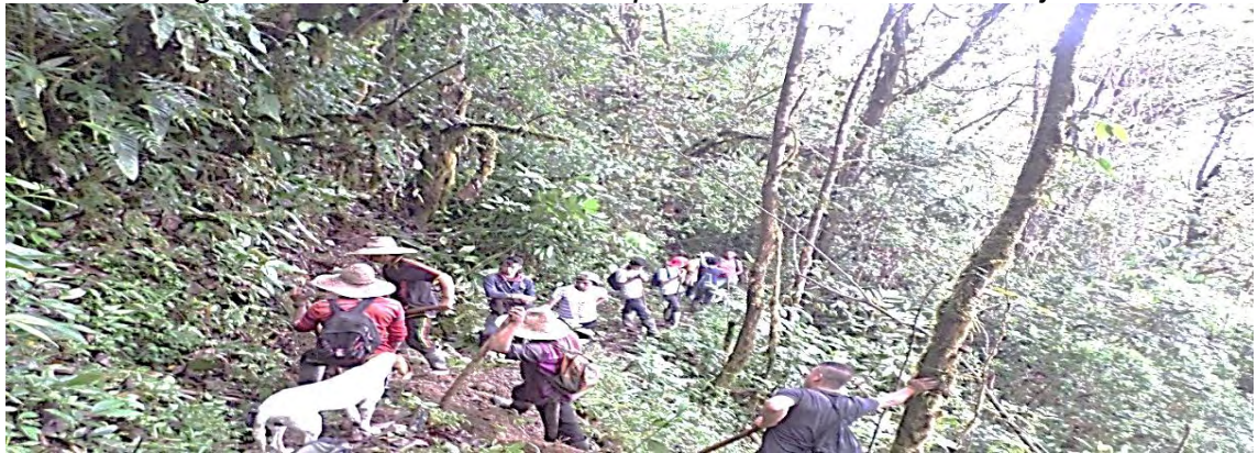
Figura 6. Trabajo comunitario para la excavación de zanjas.
