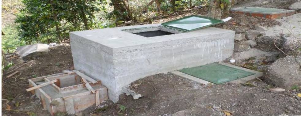
Figura 22. Construcción cámara de quiebre Santa Rosa
