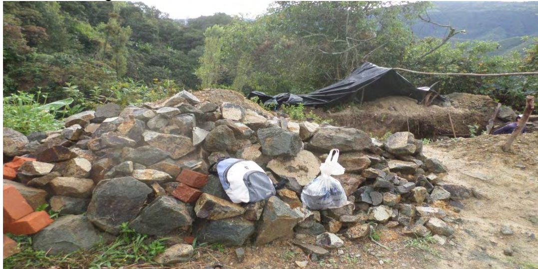
Figura 11. Cortes de la excavación en roca
