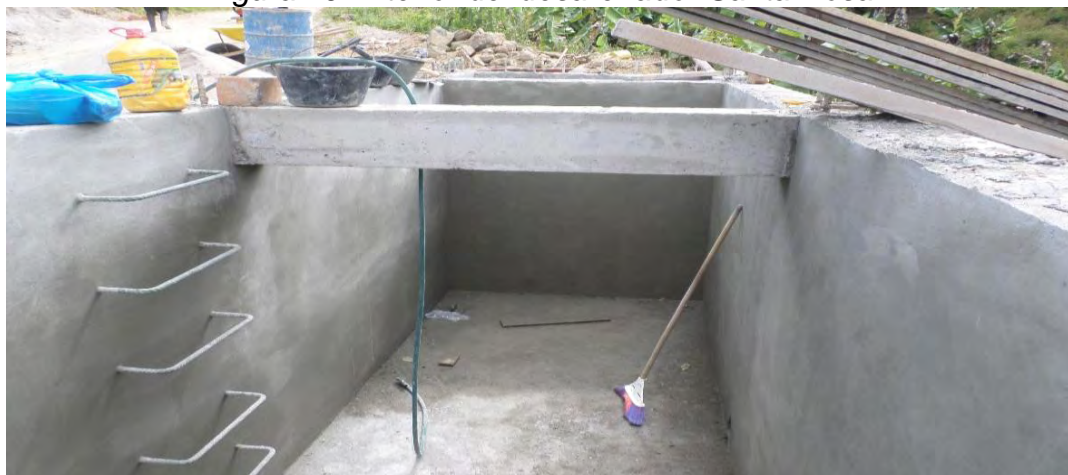
Figura 19. Interior del desarenador Santa Rosa
