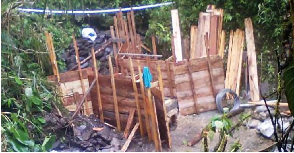
Figura 14. Encofrado de la bocatoma, presa y aletas
