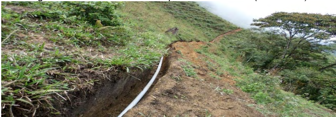
Figura 9. Tubería instalada lista para ser enterrada. (K1+534.81)
