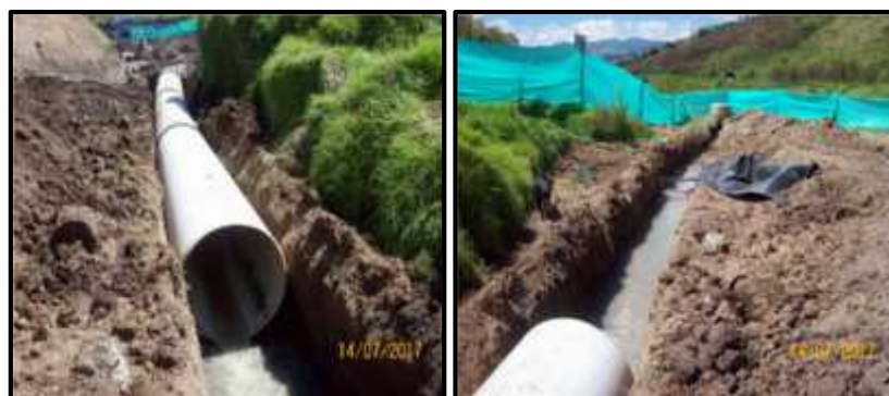
Figura 24. Desvío de aguas negras con tubería provisional y canal abierto
