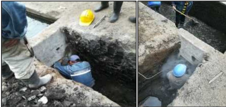
Figura 18. Perforación del muro para hacer el empate de la tubería de aducción No 4
