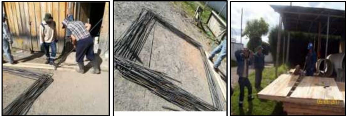
Figura 36. Figurado de acero de refuerzo y tablero de encofrado
