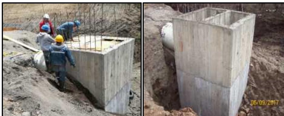
Figura 38. Estado final de fundición en concreto cámara de caída F'
