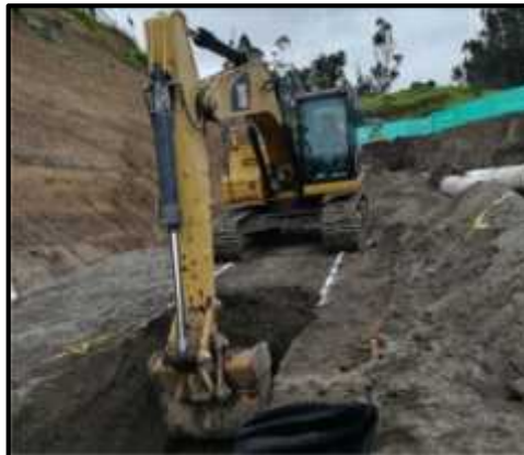
Figura 28. Excavación de zanja con retroexcavadora de orugas
