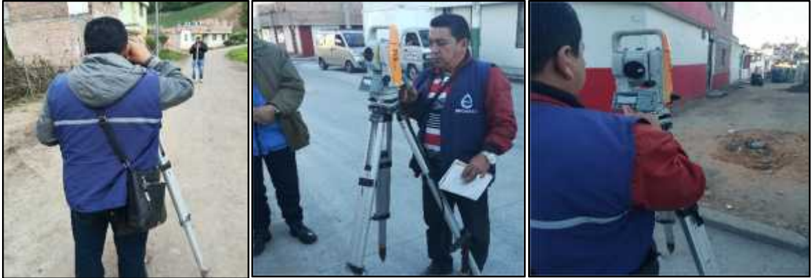
Figura 4. Actividades de topografía
