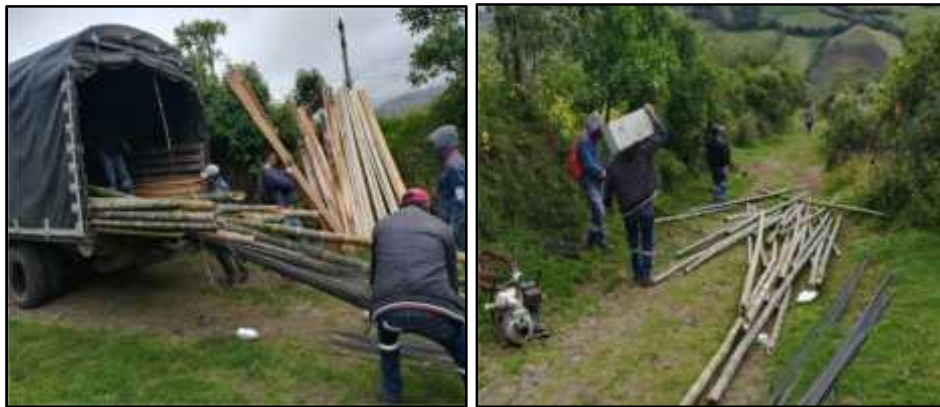
Figura 12. Descargue y transporte de material hasta la Bocatoma
