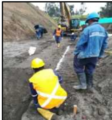
Figura 27. Alineamiento para excavación para tubería NOVALOC 45”
