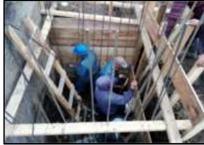
Figura 15. Encofrado de la caja de regulación
