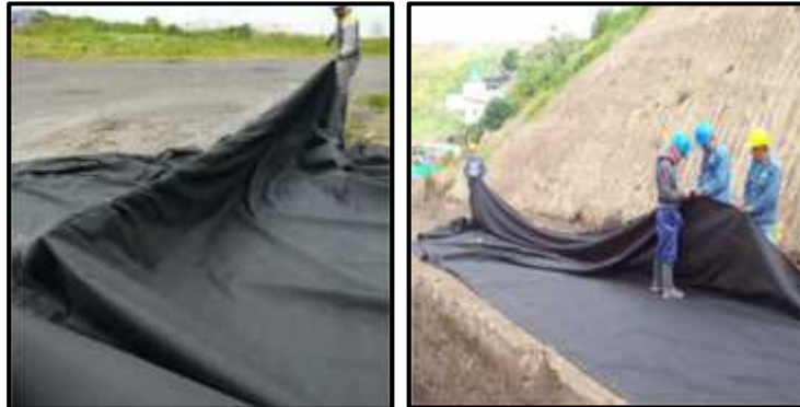
Figura 29. Preparación de geotextil no tejido NT-2500
