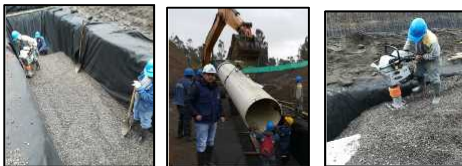
Figura 30. Encamado y relleno con triturado \frac{3}{4} "
