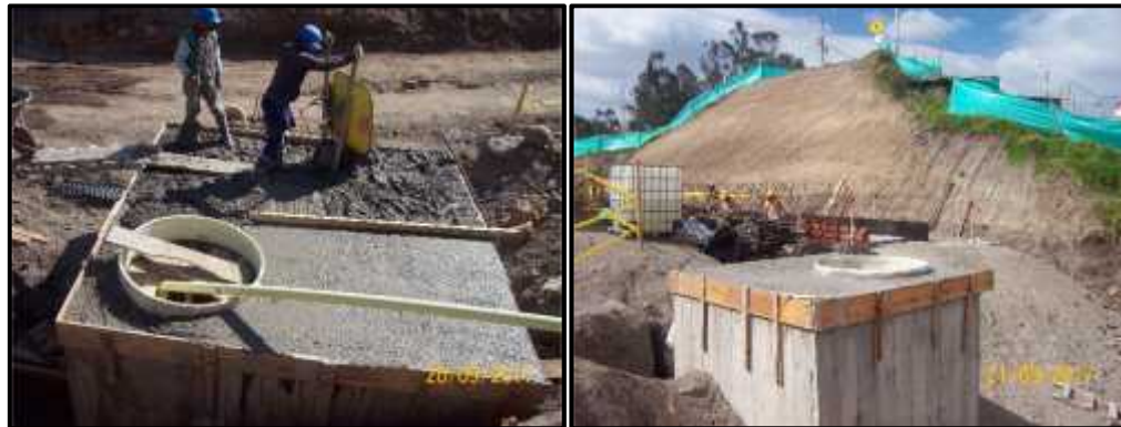
Figura 41. Fundición de losetas de las cámaras
