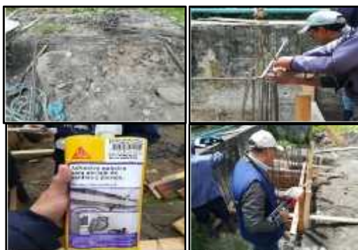
Figura 14. Instalación de acero horizontal para la caja de regulación
