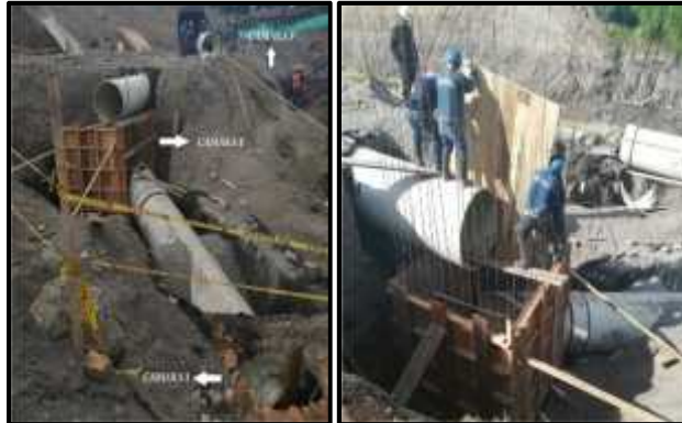
Figura 37. Instalación de tablero de encofrado
