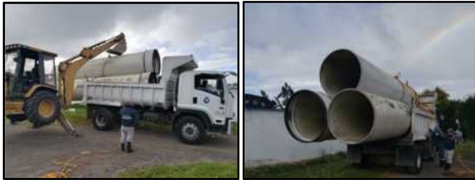
Figura 26. Transporte de tubería Novaloc 45” trayecto: Empoobando-obra
