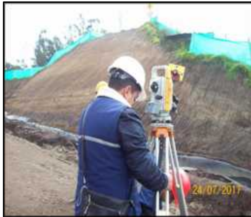
Figura 25. Localización y replanteo del eje para instalación de tubería
