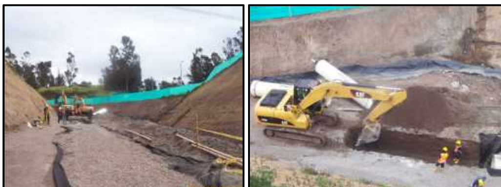
Figura 33. Actividades finales de instalación de tubería
