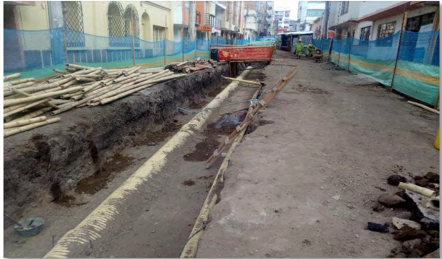
Figura 41. Instalación de tubería sanitaria
