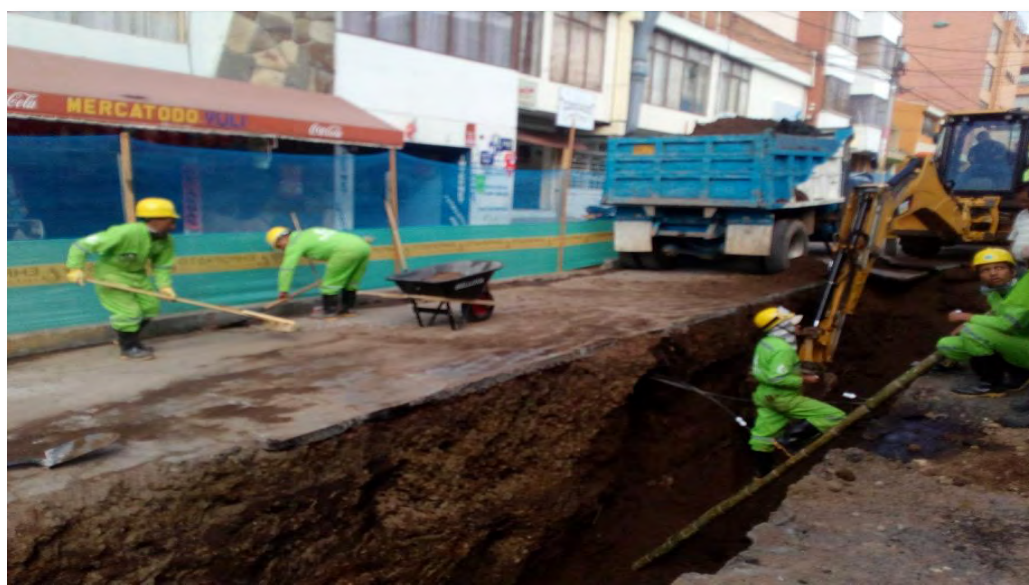
Figura 22. Excavación colector (P5, S6) – (P4, S5)
