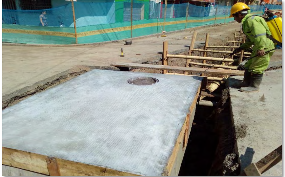
Figura 35. Finalización de cámara rectangular.
