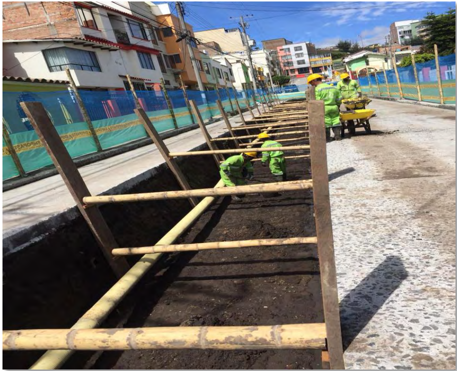
Figura 78. Material granular para cama de cimentación (50% triturado, 50% recebo).
