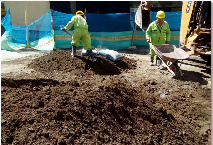
Figura 36. Material seleccionado de excavación para rellenos laterales.
