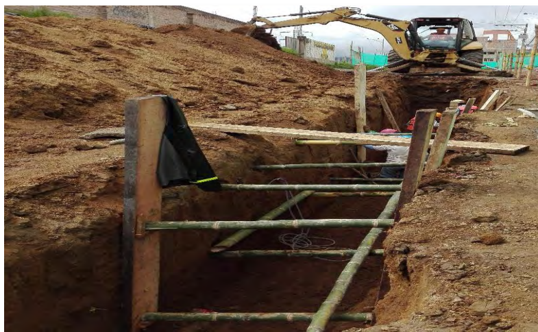
Figura 28. Apilamiento de material de excavación seleccionado.
