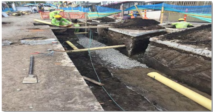
Figura 80. Instalación de tubería pluvial
