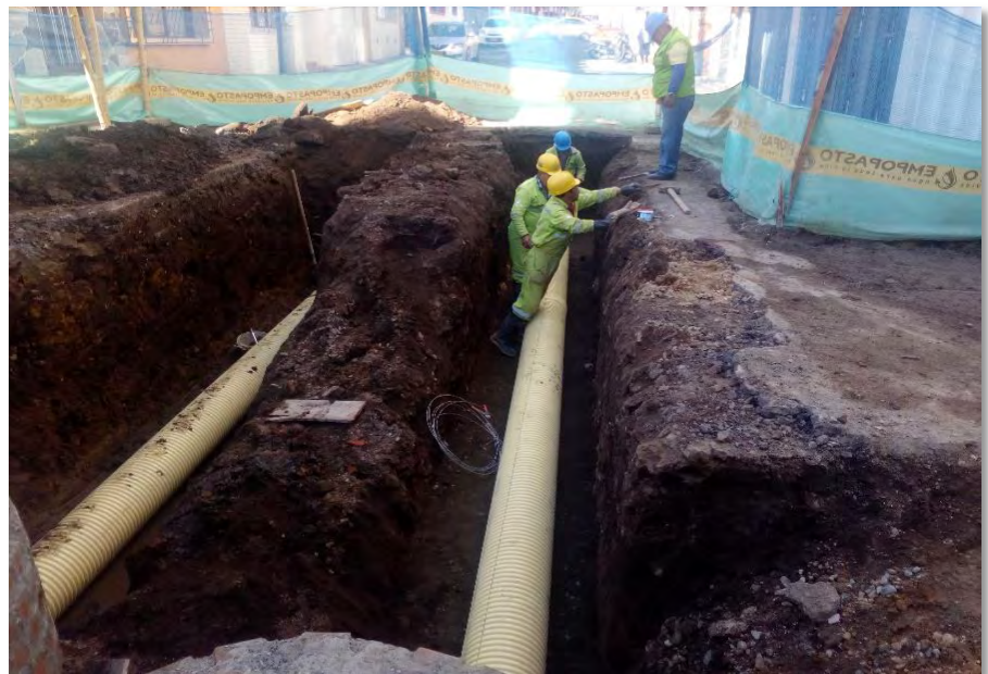
Figura 42. Instalación de tubería pluvial y sanitaria
