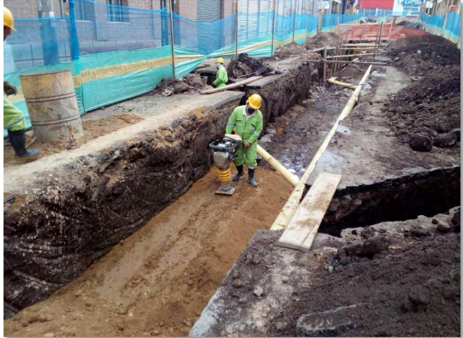
Figura 48. Instalación de material granular para relleno final.
