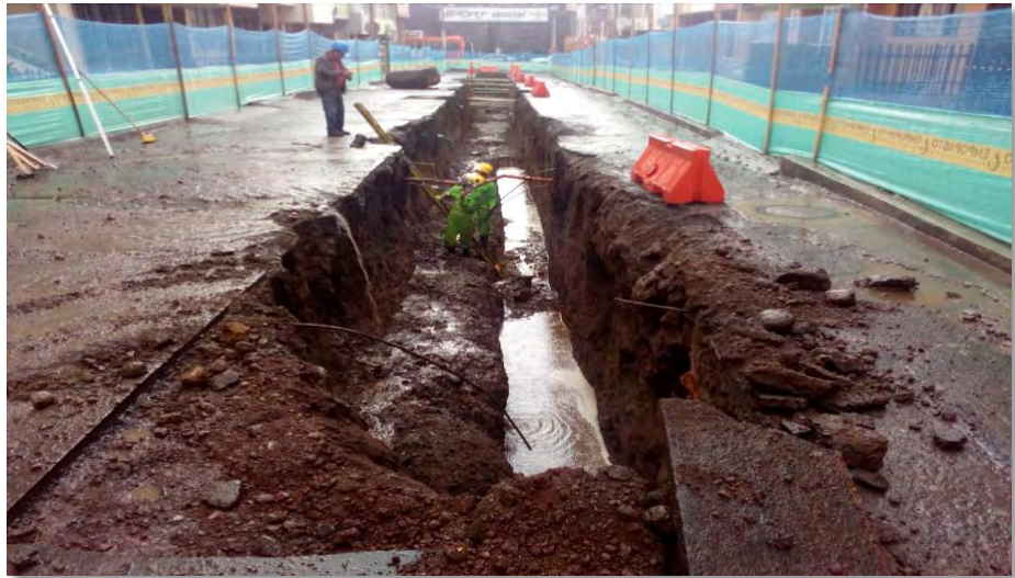
Figura 23. Excavación colector. (P5, S6) – (P4, S5)
