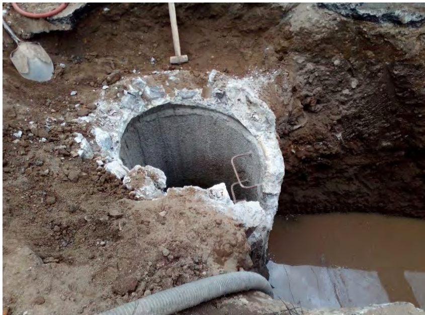
Figura 65. Demolición de cámaras de inspección
