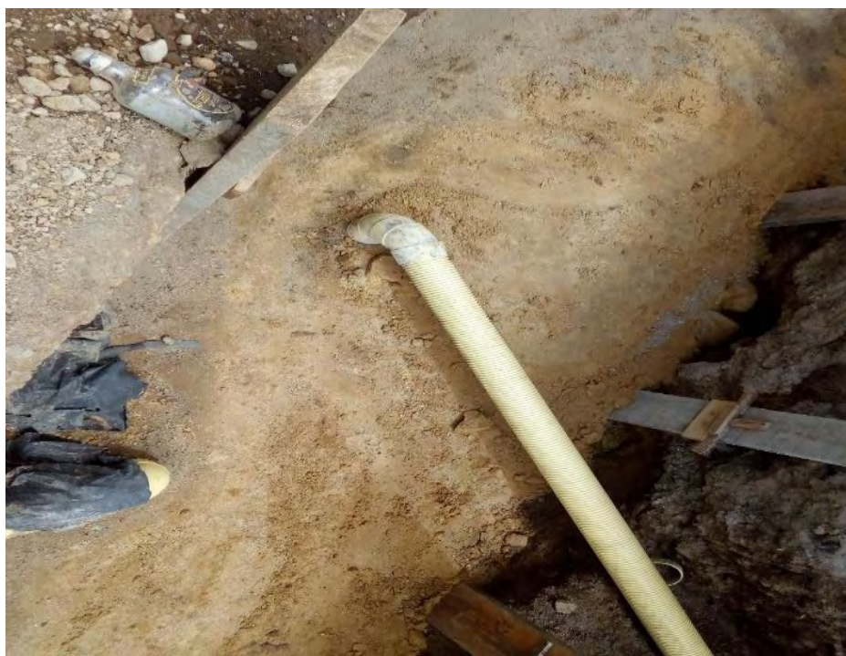
Figura 88. Relleno y atraque inicial
