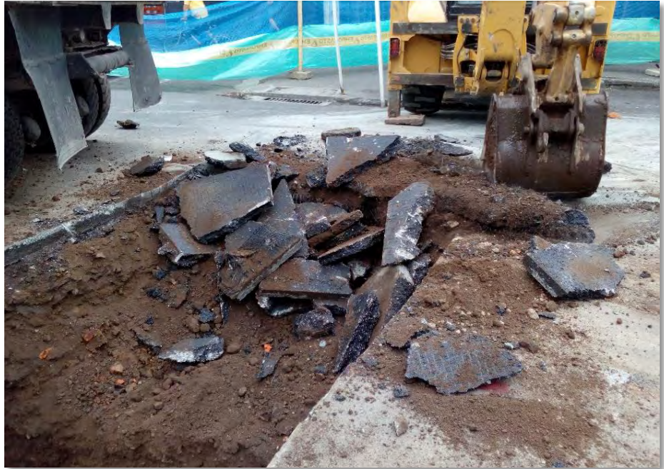
Figura 17. Visualización de demoliciones.
