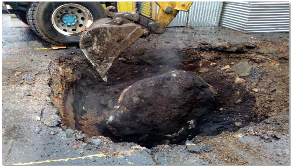
Figura 24. Excavación mecánica en roca.
