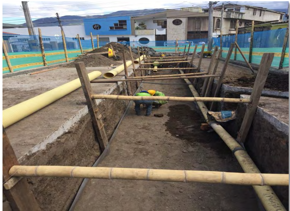
Figura 77. Material granular para cama de cimentación (50% triturado, 50% recebo).
