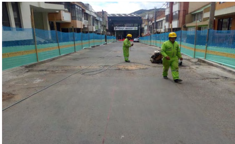
Figura 11. Cerramiento provisional con polisombra.
