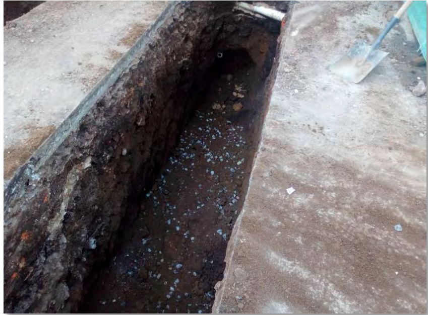
Figura 38. Material granular para cama de cimentación (50% triturado, 50% recebo).
