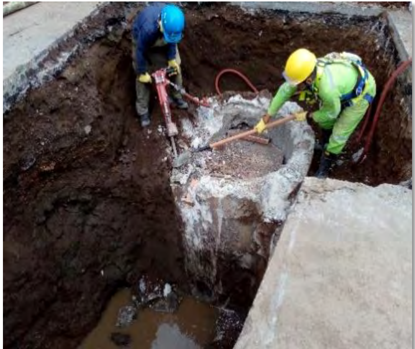
Figura 19. Demolición de pozos de inspección existentes.
