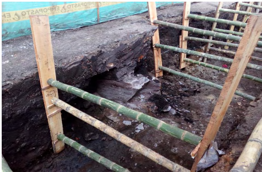
Figura 26. Visualización de entibado realizado en colectores.
