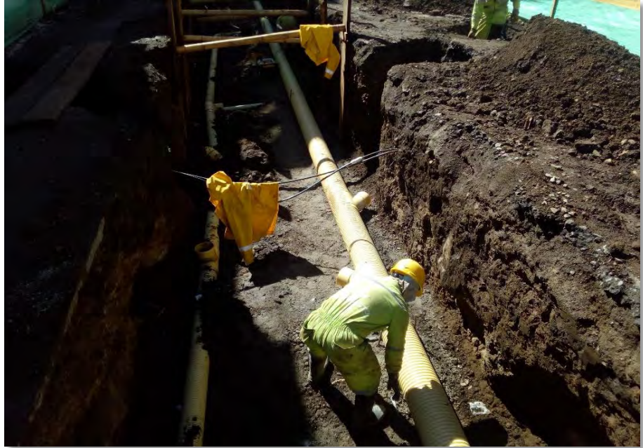
Figura 43. Instalación de tubería pluvial y sanitaria
