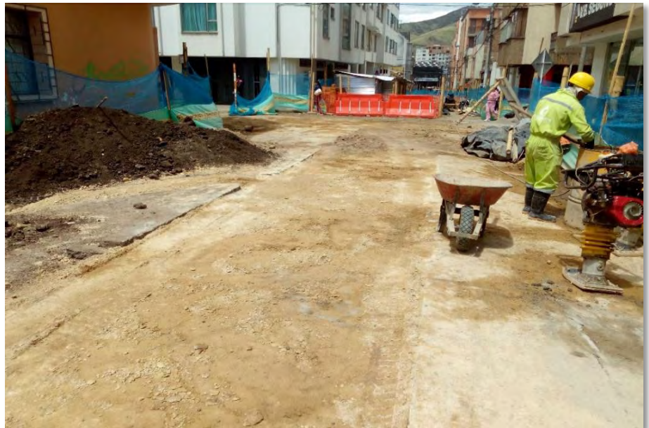
Figura 49. Relleno final compactado.
