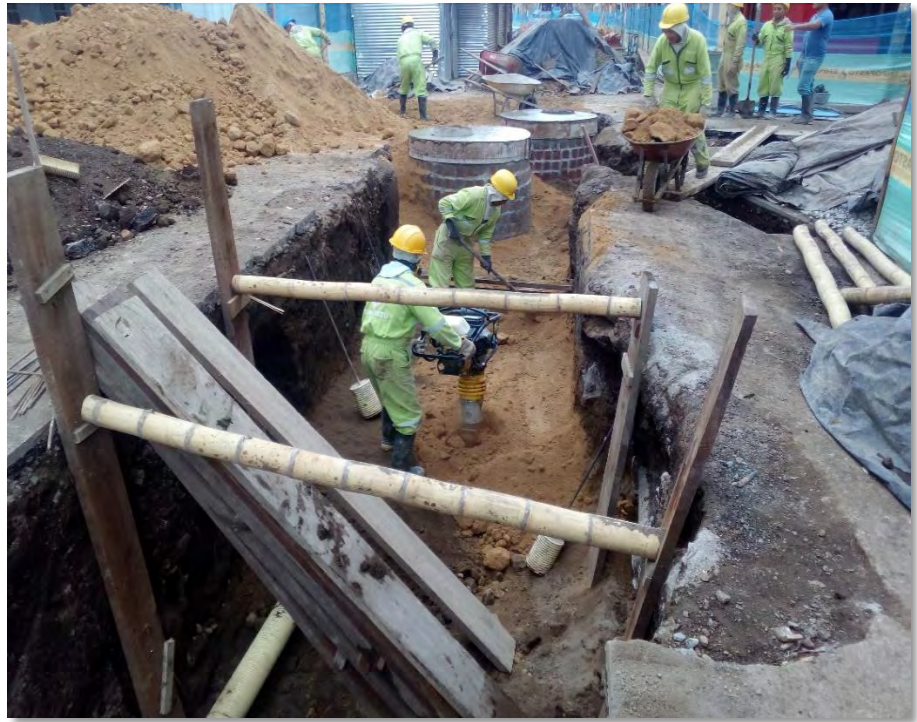
Figura 90. Rellenos finales hasta cota terreno.
