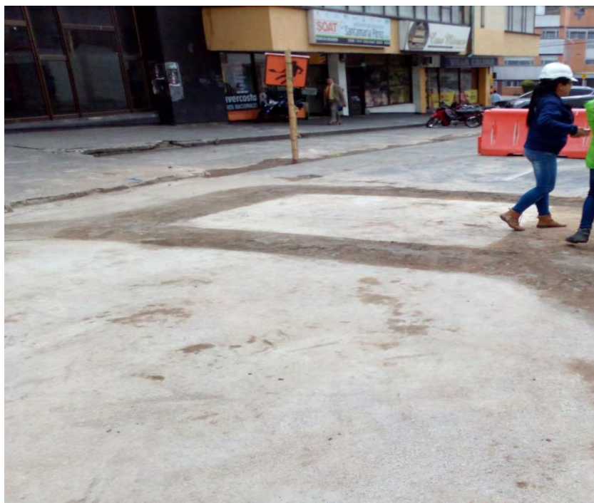
Figura 37. Relleno y compactación final.
