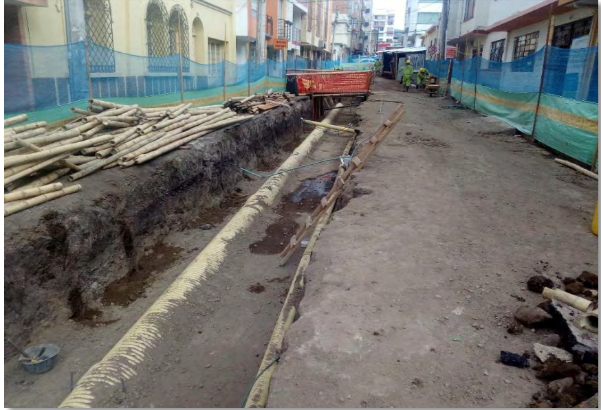
Figura 45. Instalación de material de préstamo tipo recebo.
