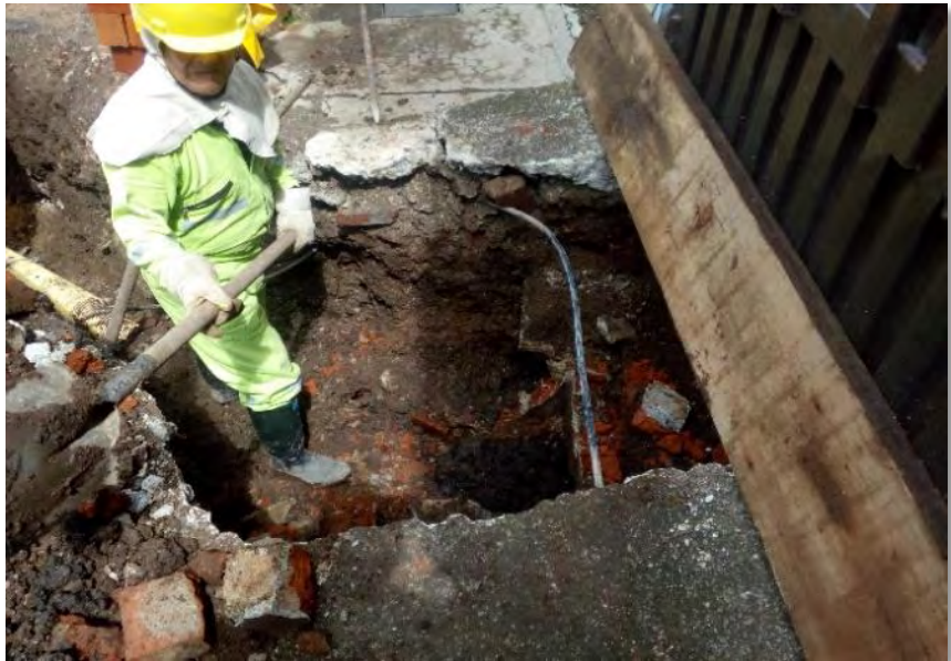
Figura 18. Demolición de cajas domiciliarias existente.
