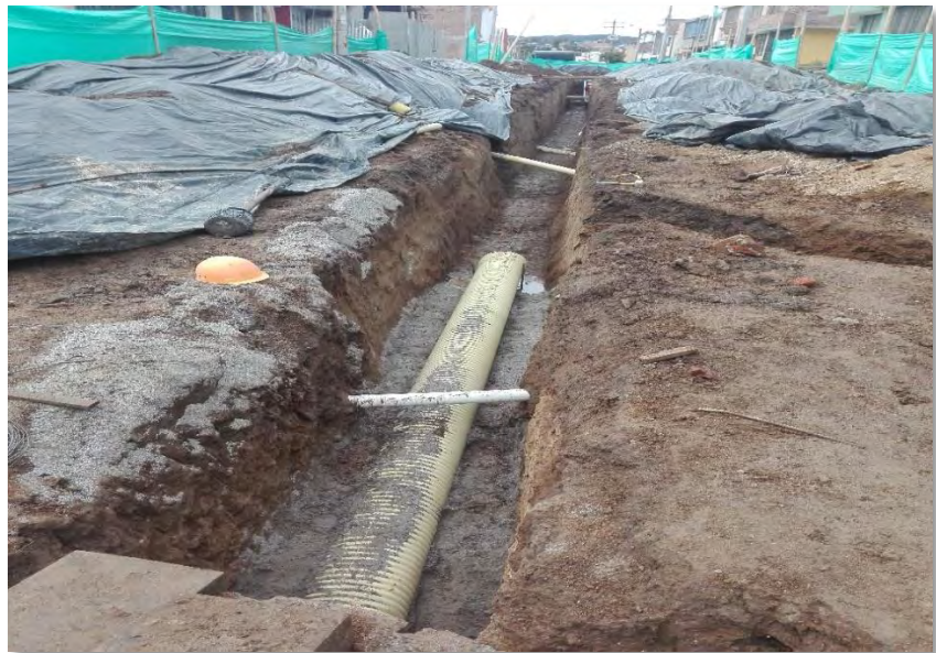
Figura 81. Instalación de tubería sanitaria
