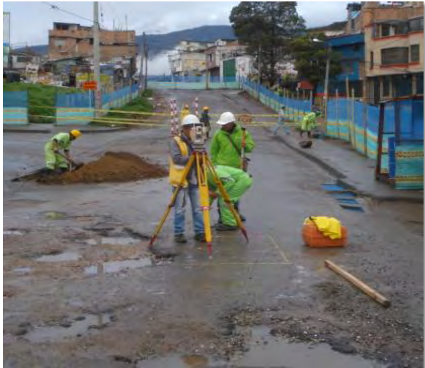
Figura 63. Localización y replanteo
