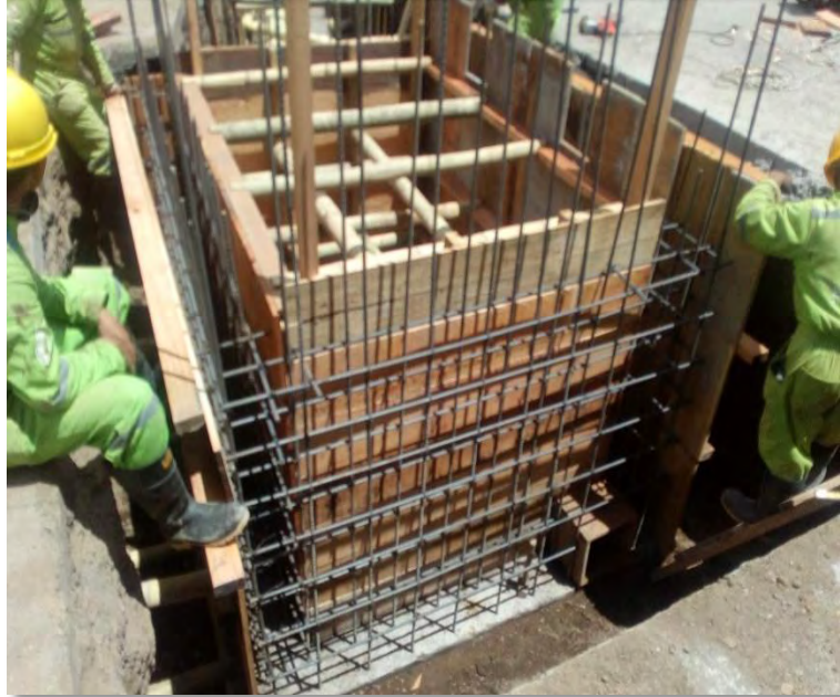
Figura 33. Visualización de acero de refuerzo y formaleteo de cámara de inspección rectangular.
