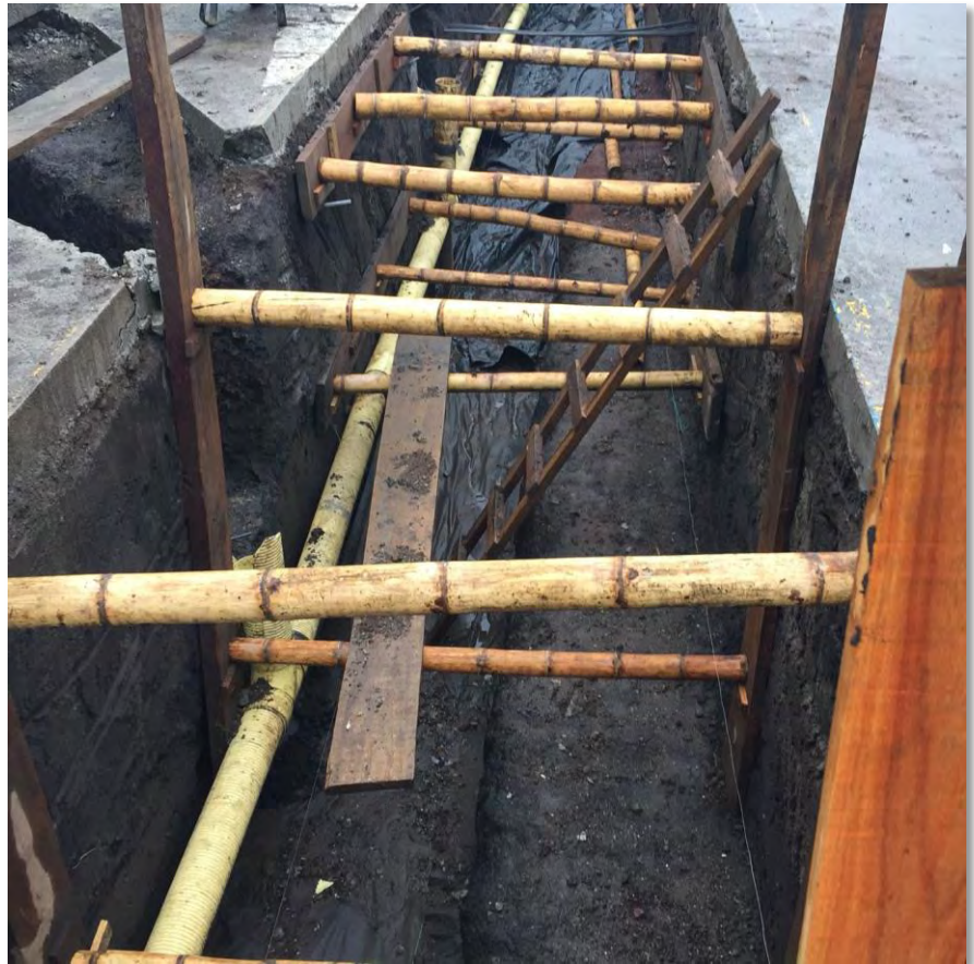
Figura 72. Visualización de entibado realizado en colectores
