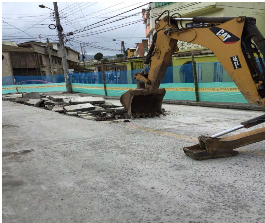
Figura 64. Demolición de carpeta asfáltica
