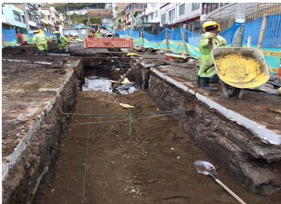
Figura 87. Relleno y atraque inicial
