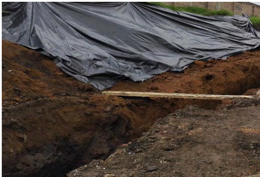
Figura 29. Cubrimiento de material seleccionado con polisecc.
