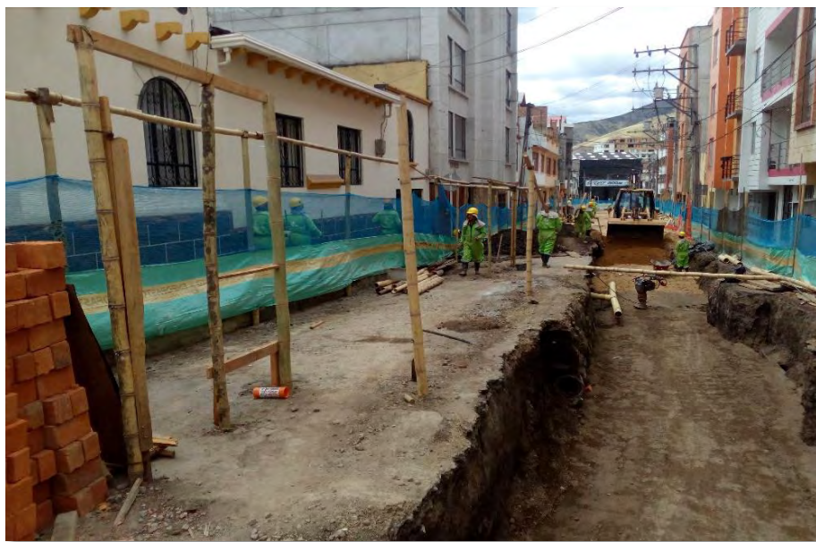
Figura 47. Instalación de material granular tipo recebo.
