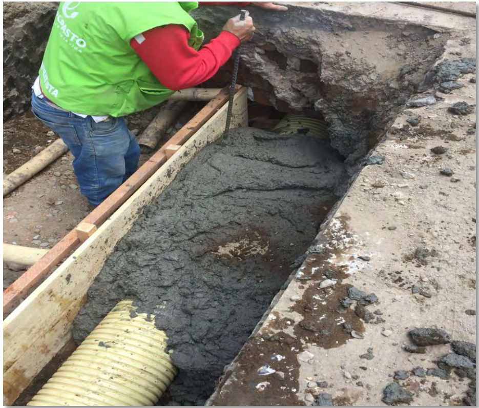
Figura 83. Encamisado de tubería.
