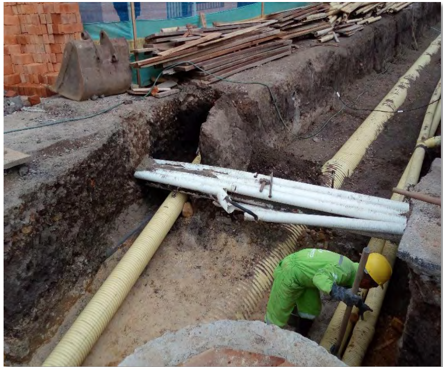
Figura 46. Instalación de material de préstamo tipo recebo.
