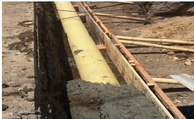
Figura 82. Encamisado de tubería.
