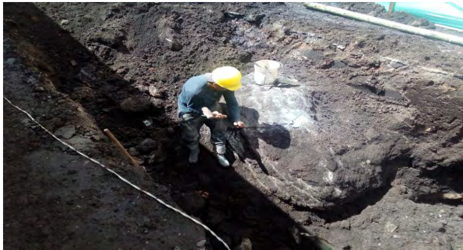
Figura 25. Excavación en roca incluye corte manual.
