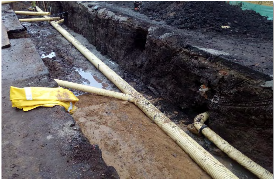
Figura 44. Instalación de acometida sanitaria.
