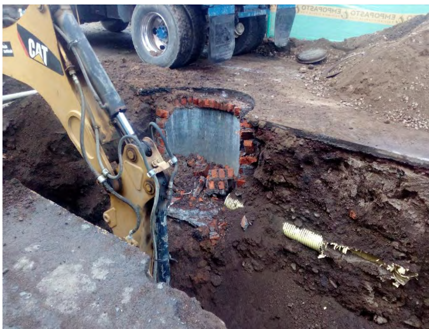
Figura 66. Demolición de cámaras de inspección
