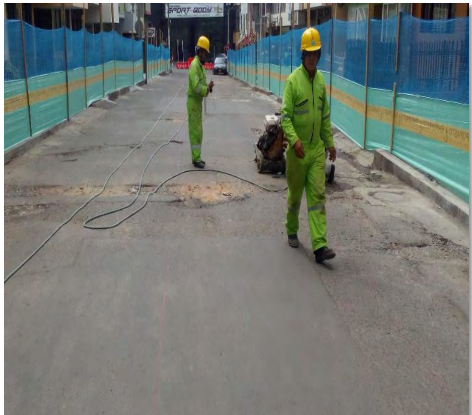
Figura 60. Cerramiento provisional con polisombra
