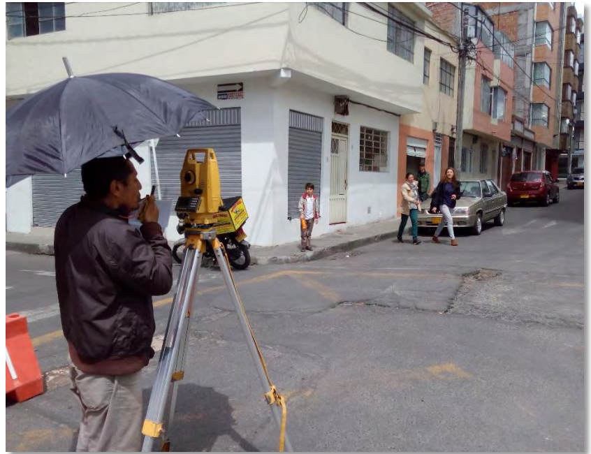
Figura 15. Localización y replanteo
