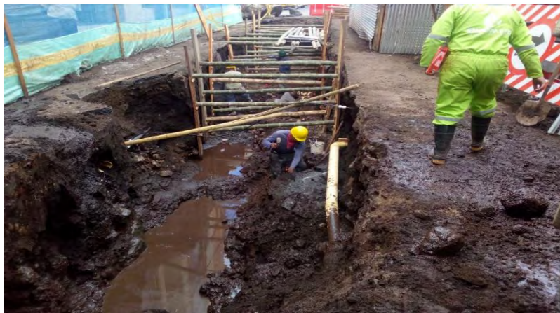
Figura 27. Visualización de entibado realizado en colectores.
