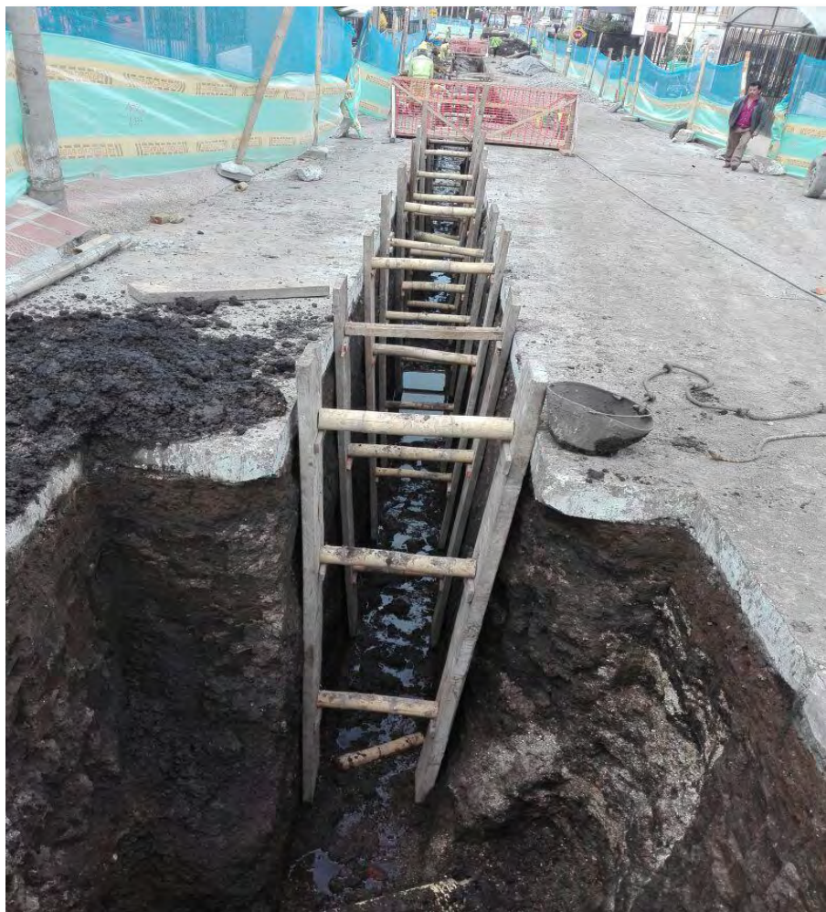
Figura 71. Visualización de entibado realizado en colectores
