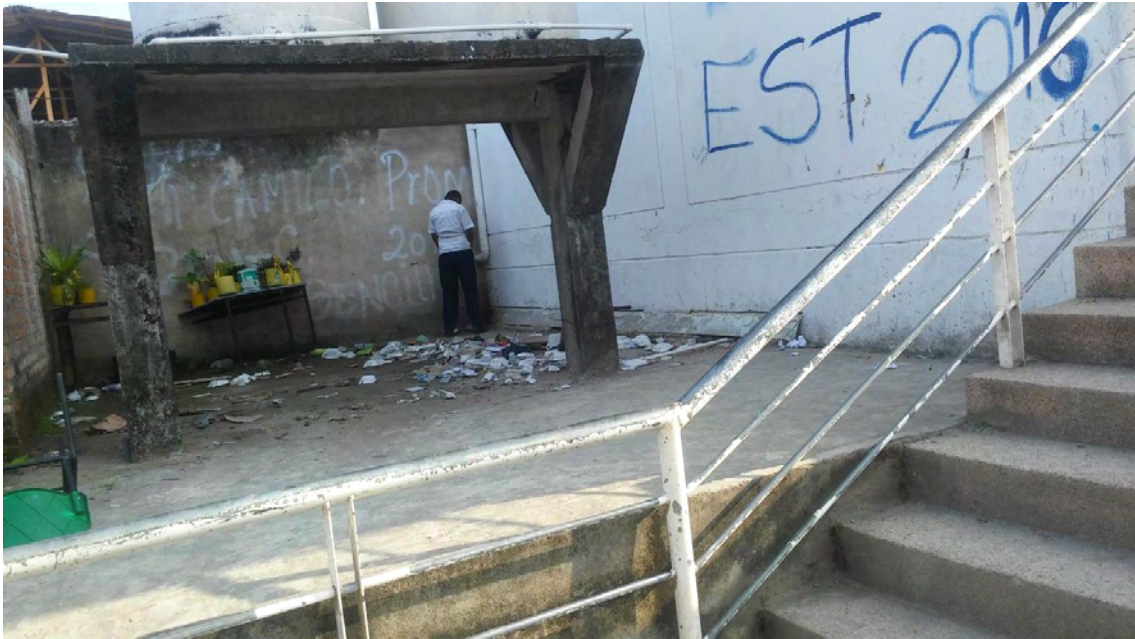
Falta de aseo al interior de la I.E.
