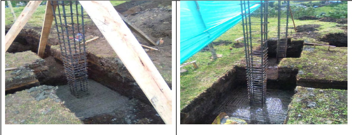
Imagen 19. Concreto para zapatas obra casa cabildo Iles
