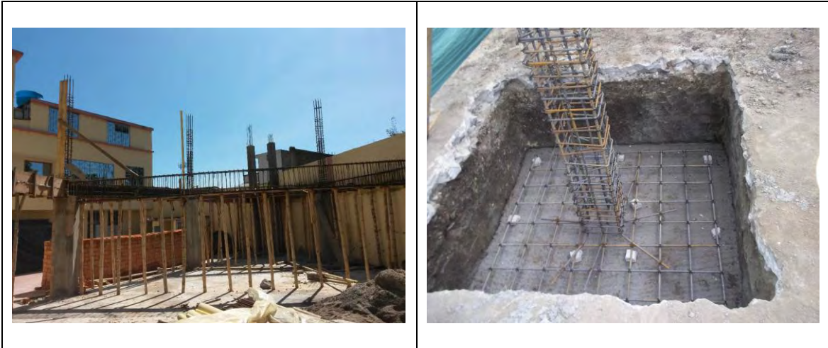
Imagen 5. Acero de refuerzo para estructurales obra cabildo de Carlosama
