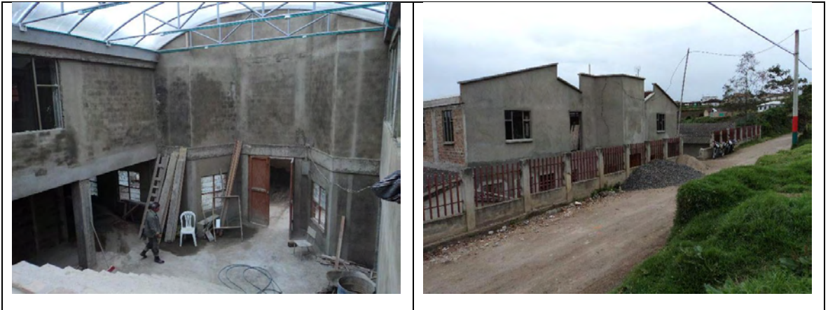
Imagen 27. Repellos de muros y estructura casa cabildo San Juan
