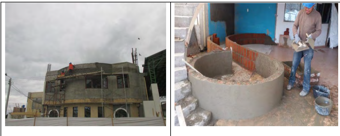
Imagen 15. Repellos para muro y estructura obra cabildo Gran Cumbal
