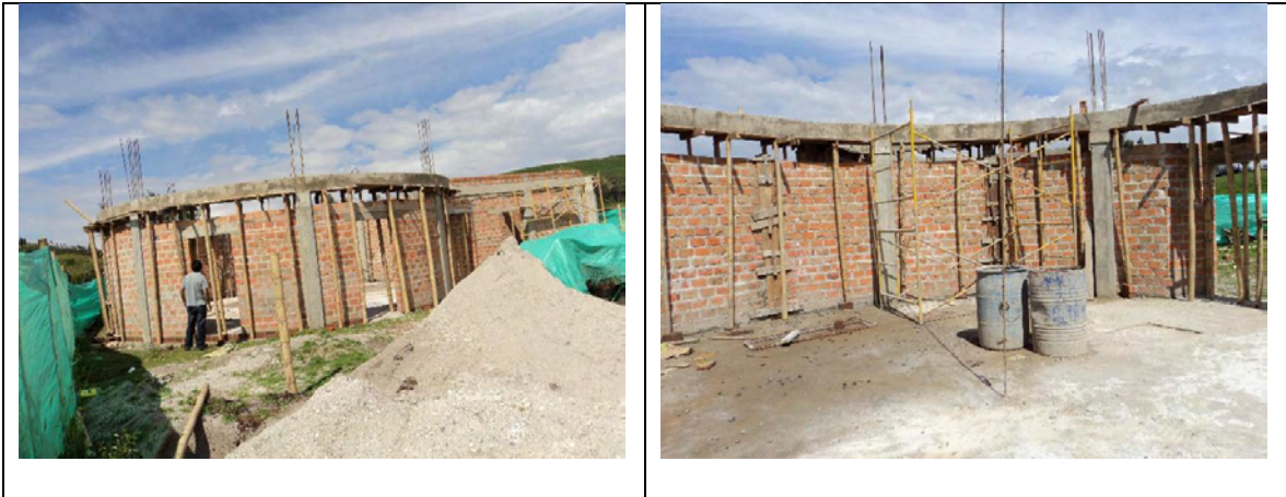
Imagen 20. Concreto para columnas y vigas aéreas obra casa cabildo Iles
