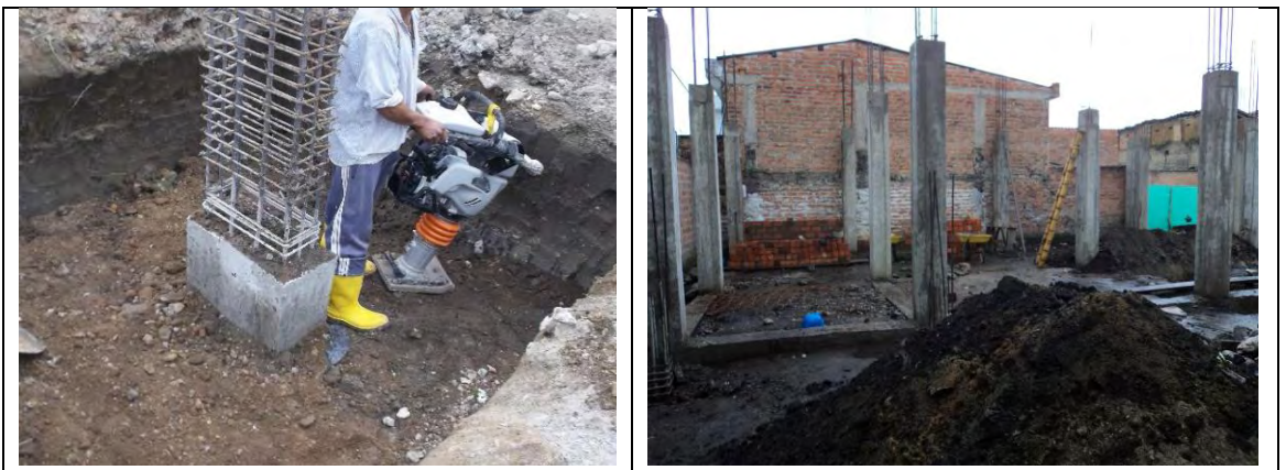
Imagen 3. Concreto para pedestales, vigas de cimentación y columnas obra cabildo de Aldana
