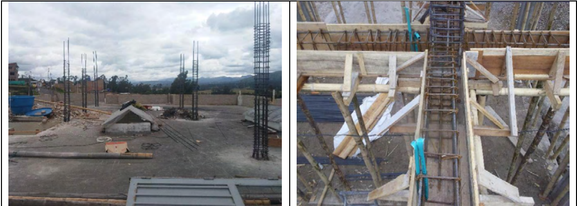
Imagen 17. Acero de refuerzo para estructura obra casa cabildo Guachucal
