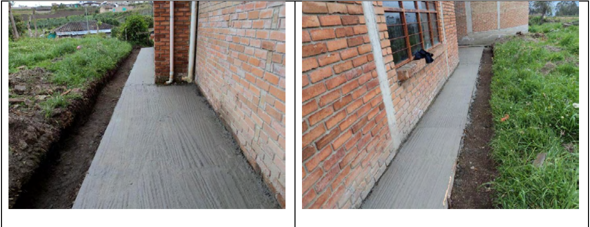
Imagen 26. Concreto para andenes casa cabildo San Juan
