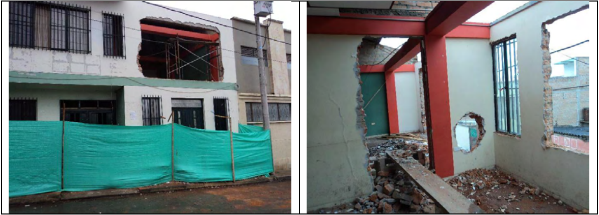
Imagen 10. Cerramiento provisional en polisombra obra cabildo Males Córdoba
