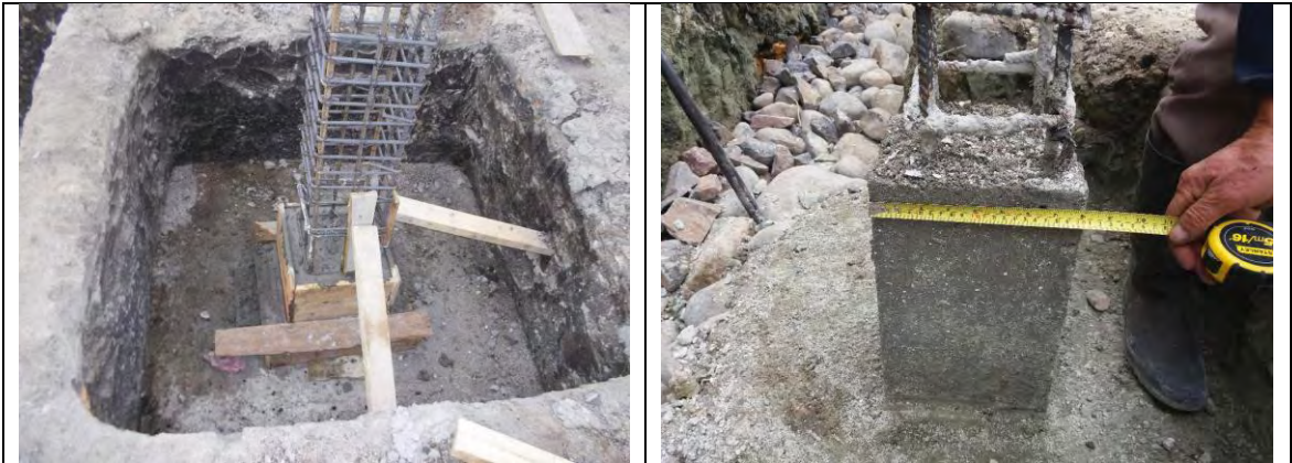
Imagen 8. Zapatas y pedestales obra centro cultural Juan Chiles
