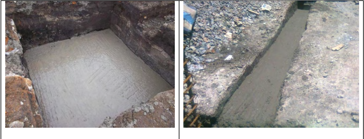
Imagen 30. Concreto para solado de limpieza en muro de cerramiento cabildo Yaramal
