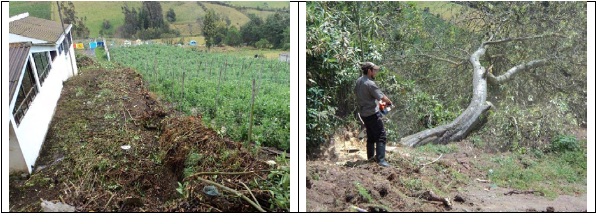
Imagen 29. Descapote y limpieza muro de cerramiento cabildo Yaramal
