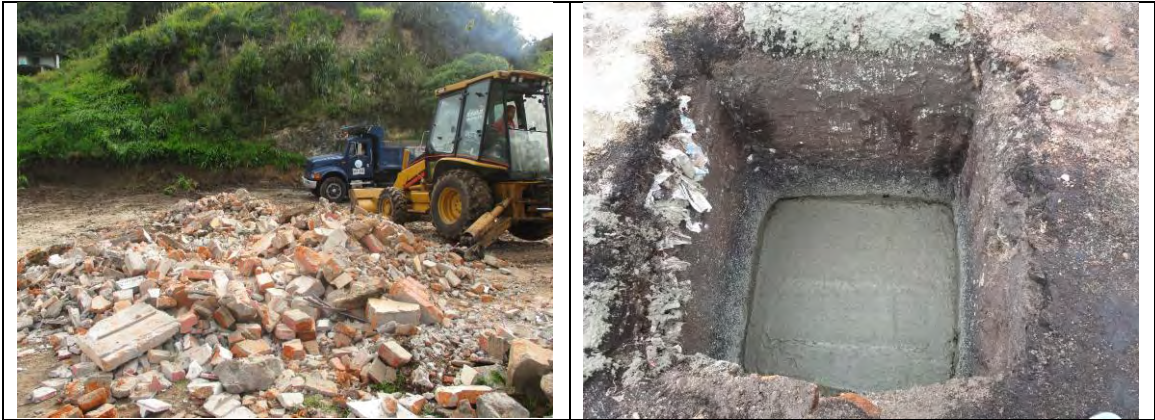
Imagen 7. Desalojo de escombros y concreto para solado de limpieza obra centro cultural Juan Chiles
