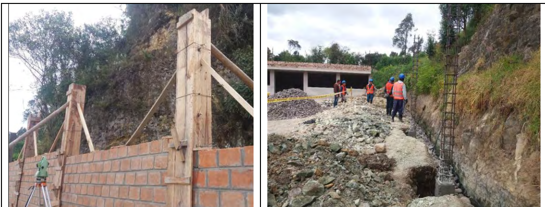
Imagen 9. Acero de refuerzo y columnas obra centro cultural Juan Chiles
