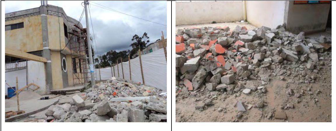
Imagen 13. Demolición de estructuras obra cabildo Gran Cumbal
