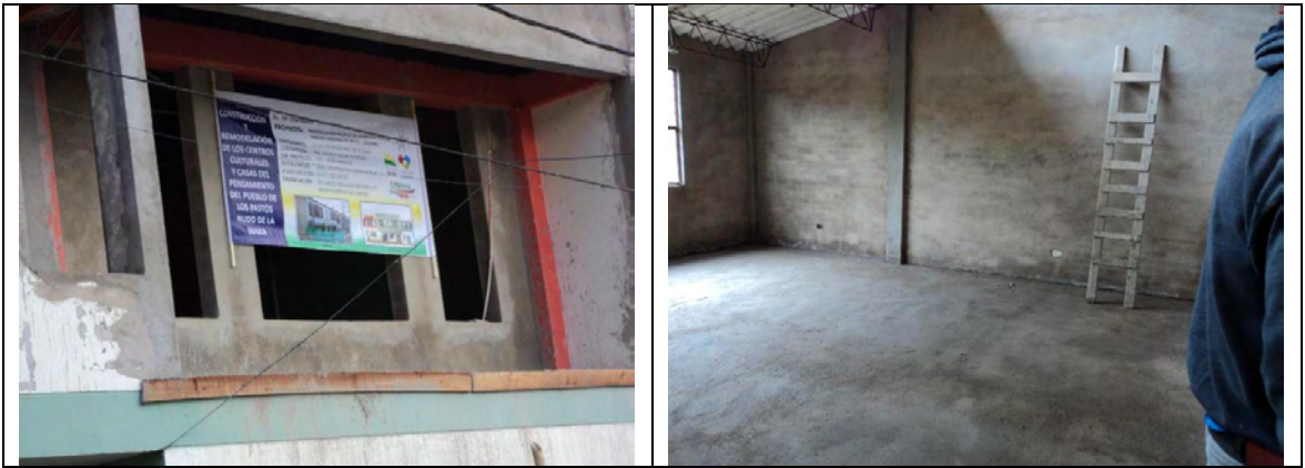
Imagen 11. Repello para muros y pisos obra cabildo Males Córdoba
