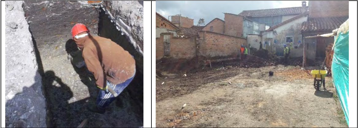
Imagen 1. Excavación a mano en material común obra cabildo de Aldana
