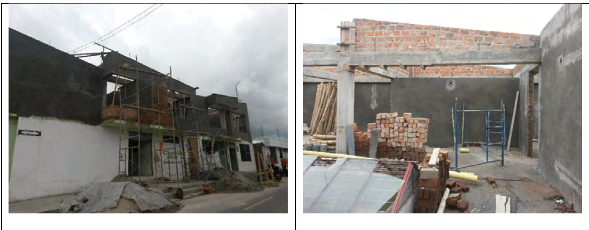
Imagen 18. Repello para muros y estructura obra casa cabildo Guachucal
