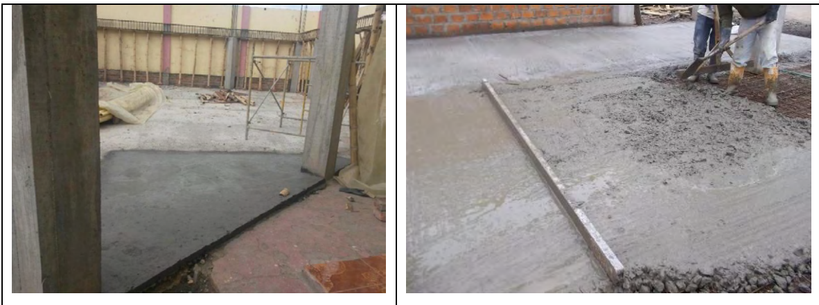
Imagen 6. Concreto para pisos obra cabildo de Carlosama
