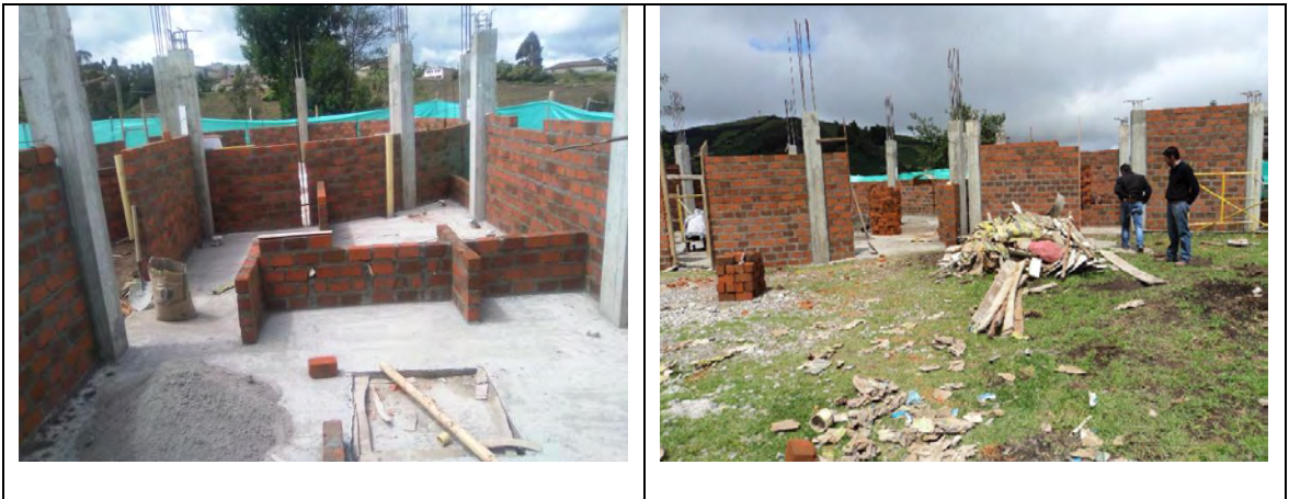
Imagen 21. Muro en saga ladrillo común obra casa cabildo Iles
