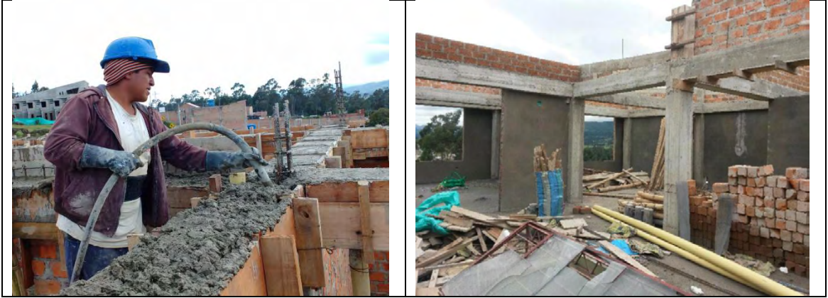
Imagen 16. Columnas y vigas aéreas obra casa cabildo Guachucal
