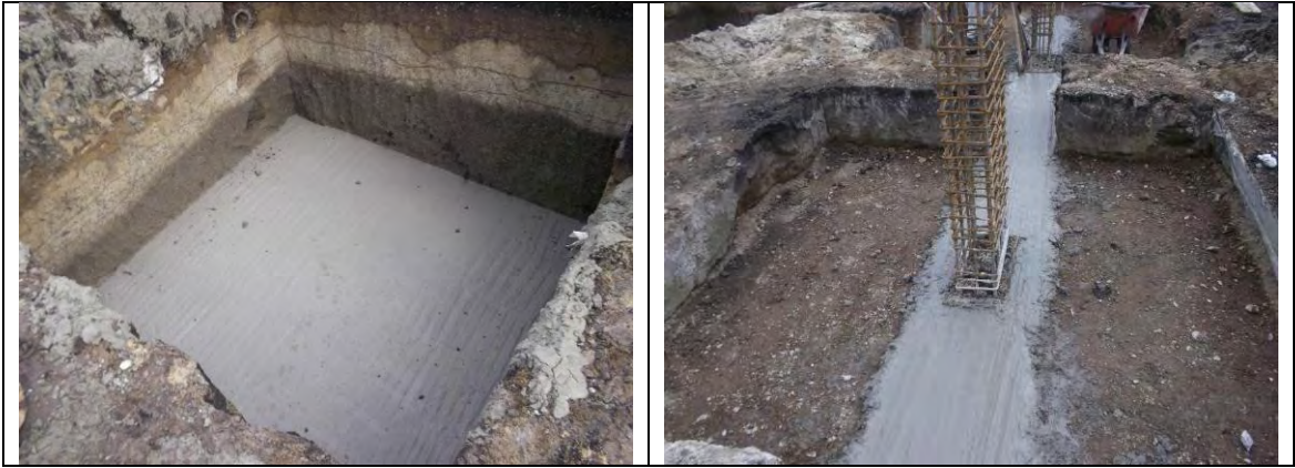
Imagen 4. Solados de limpieza obra cabildo de Carlosama
