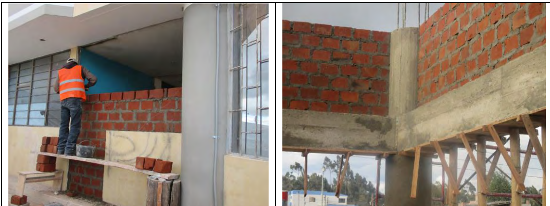
Imagen 14. Muros en saga ladrillo común y estructura en concreto 3000 psi obra Cabildo Gran Cumbal
