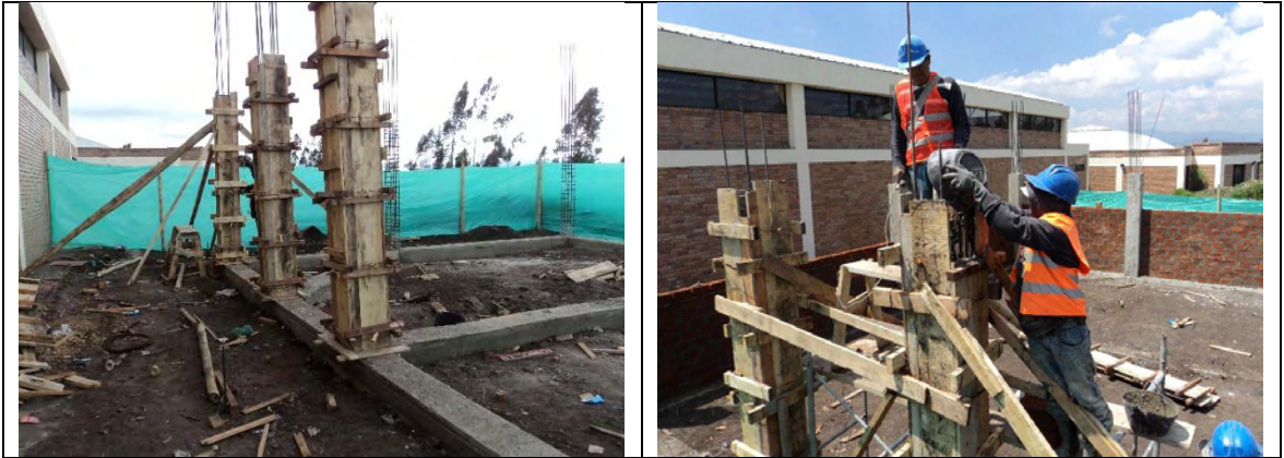
Imagen 23. Vigas de cimentación y columnas obra casa cabildo de Ipiales
