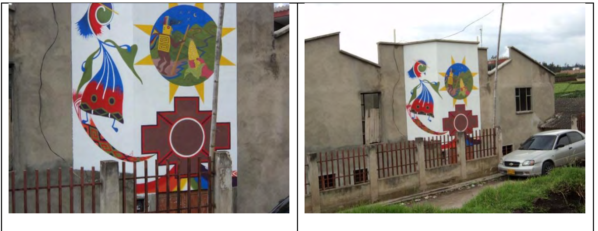
Imagen 28. Estuco y pintura para fachada de casa de cabildo San Juan
