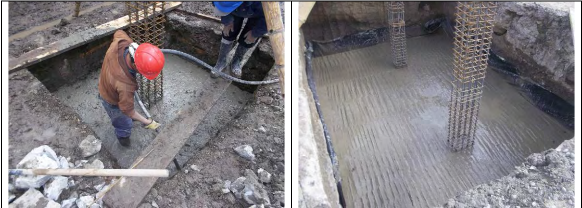
Imagen 2. Concreto para zapatas obra cabildo de Aldana.
