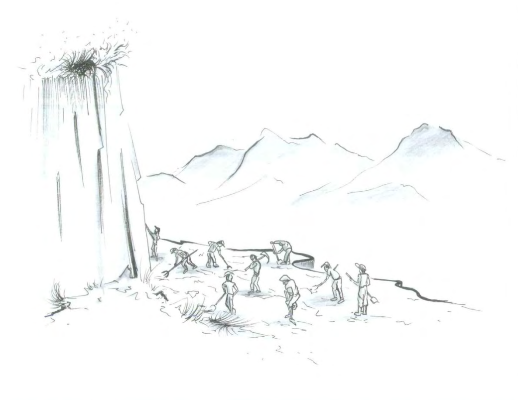
Figura 11. Construcción de la primera carretera, por El Pailón.
