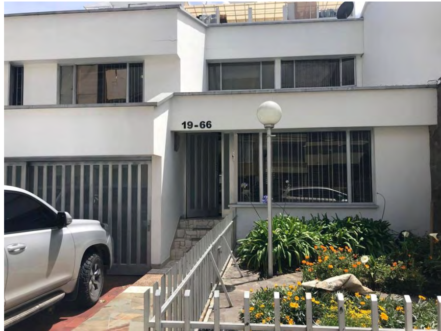
Figura 2. Fachada OM ingeniería
