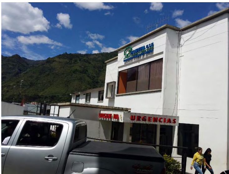
Figura 13. Área de urgencias del Hospital Lorencita Villegas de Santos de Samaniego.
