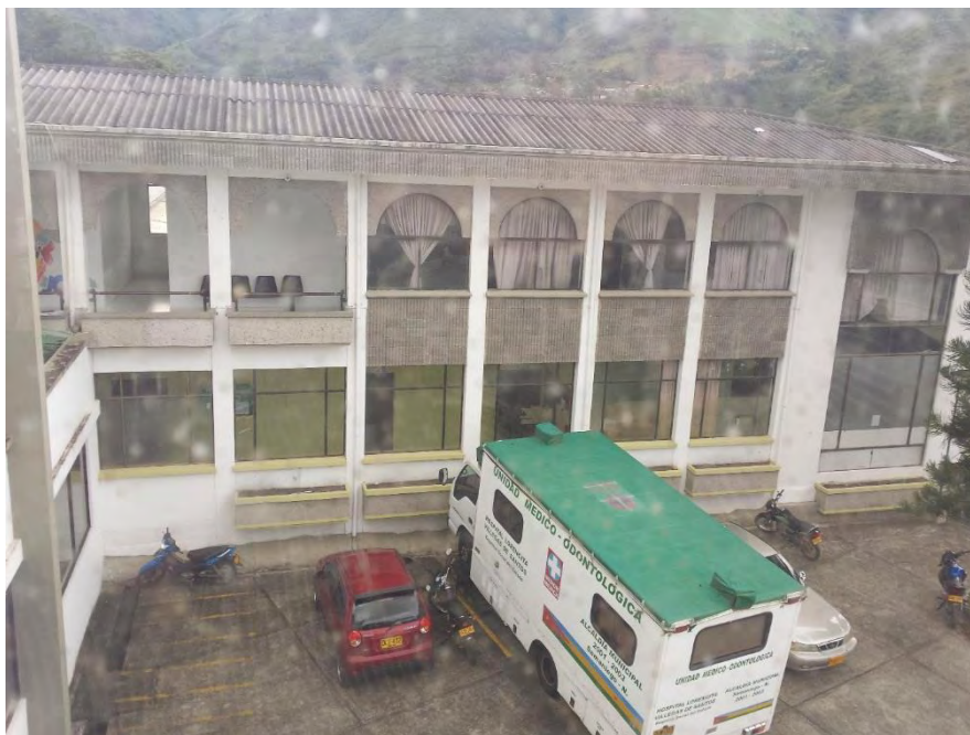
Figura 14. Área de hospitalización del Hospital Lorencita Villegas de Santos de Samaniego.
