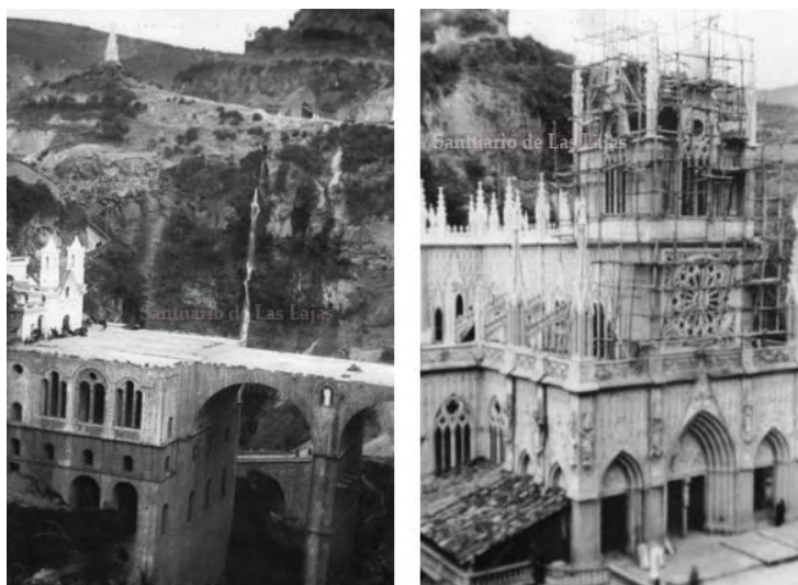
Figura 19 Construcción del cuarto templo [Fotografía]
