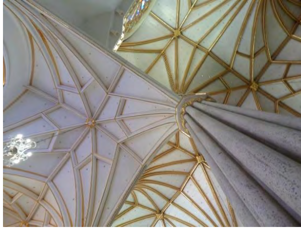
Figura 45 Pilar baquetonado [Fotografía]
