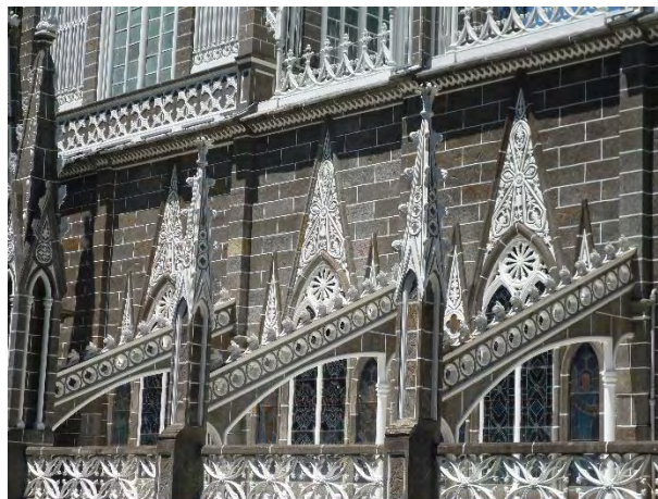
Figura 40 Arbotante decorados con frondas [Fotografía]
