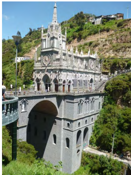
Figura 46 Vista diagonal de Fachada lateral izquierda [Fotografía]
