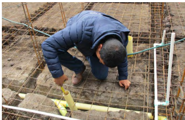
Imagen 38 - Pruebas de estanqueidad. Vivienda de María Ituyan (San Juan)
