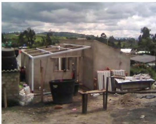
Imagen 20 - Estructura metálica vivienda de Claudia Juaspuezan (Panán)
