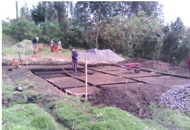
Imagen 5 - Excavación de cimentación vivienda de Jhon España (Panán)
