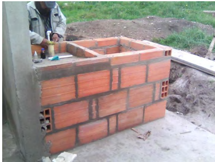
Imagen 33 - Construcción de lavadero vivienda de Lidia Piarpuezan (Panán)
