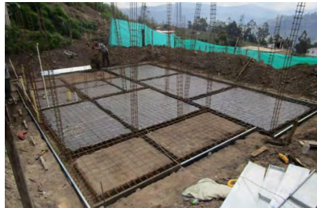
Imagen 13 - Colocación de malla electrosoldada vivienda de María Mejía (San Juan)
