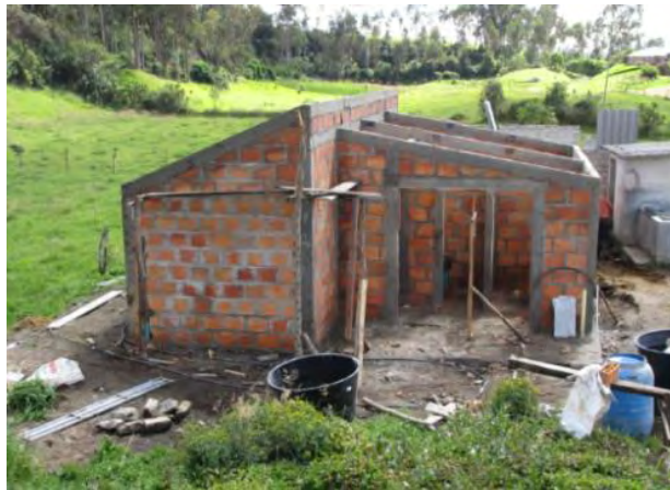
Imagen 19 - Vigas aéreas. Vivienda de Rosa Fanny Juaspuezan (Panán)
