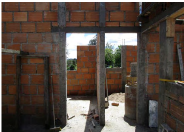
Imagen 17 - Columnas. Vivienda de Claudia Juaspuezan (Panan)
