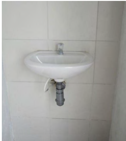
Imagen 40 - Lavamanos. Vivienda de Diego Castro (Panan)
