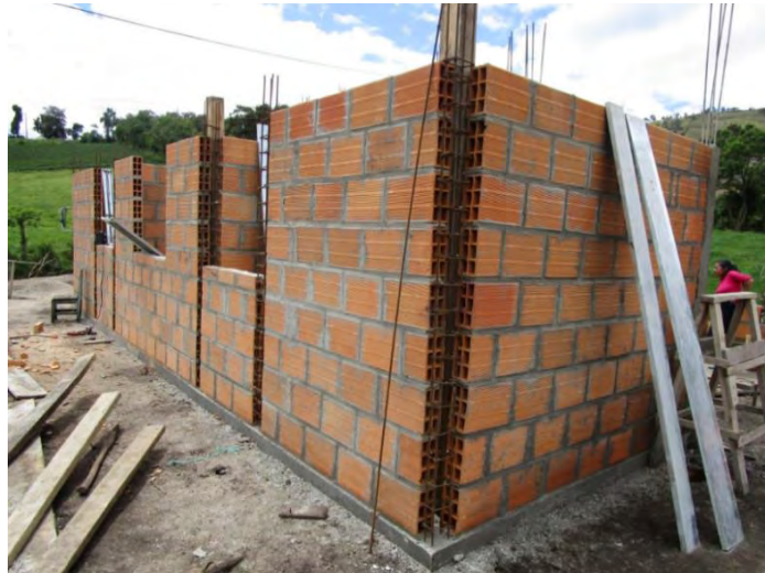
Imagen 14 - Mampostería. Vivienda de Olga Milena Toro (Panan)
