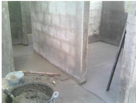
Imagen 27 - Afinado de pisos. Vivienda de Rosa Fanny Juaspuezan (Panamá)
