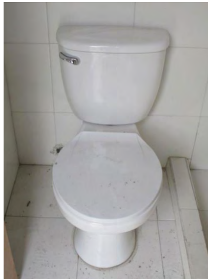
Imagen 39 - Sanitario. Vivienda de Rosa Juaspuezan (Panan)
