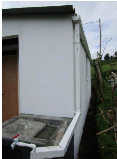
Imagen 22 - Canal y bajante vivienda de Olga Toro (Panan)
