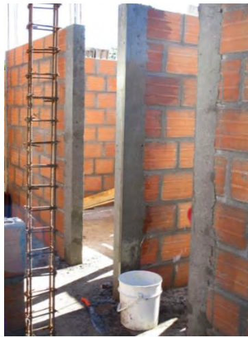
Imagen 16 - Columnas. Vivienda de Olga Milena Toro (Panan)
