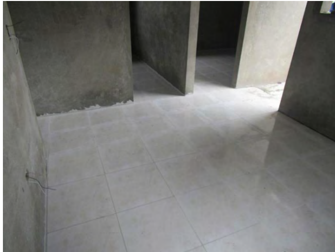
Imagen 28 - Enchape de pisos. Vivienda de Claudia Juaspuezan (Panan)
