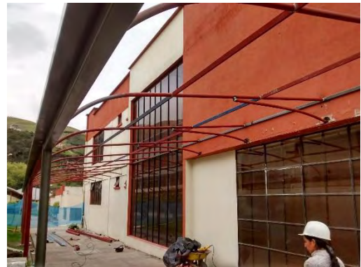
Imagen 19. Estructura cubierta sector bloque facultad de Derecho.
