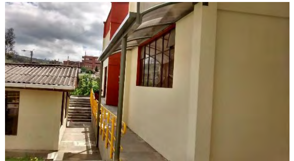
Imagen 17. Cubierta sector dos, Facultad de Derecho
