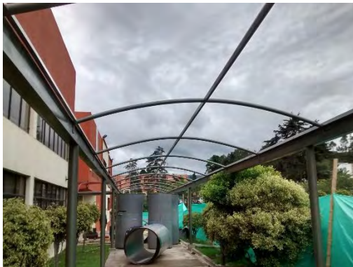
Imagen 18. Estructura cubierta sector bloque administrativo.
