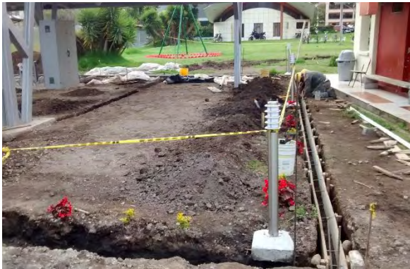
Imagen 23. Excavación y formaleta para bordillos
