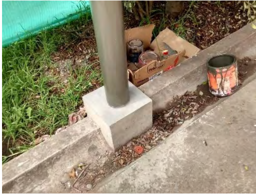
Imagen 20. Pedestal en concreto.
