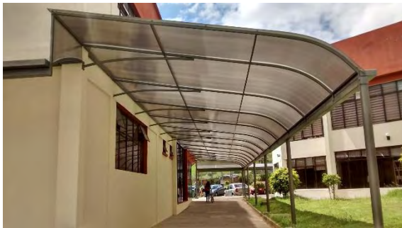
Imagen 16. Cubierta sector uno, Facultad de Derecho
