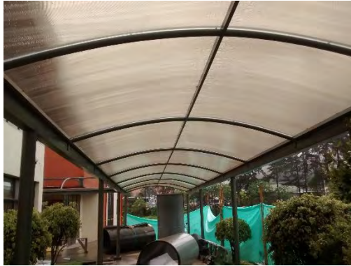
Imagen 15. Cubierta sector Bloque Administrativo
