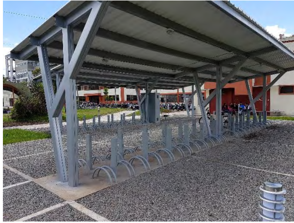
Imagen 25. Base en gravilla terminada.
