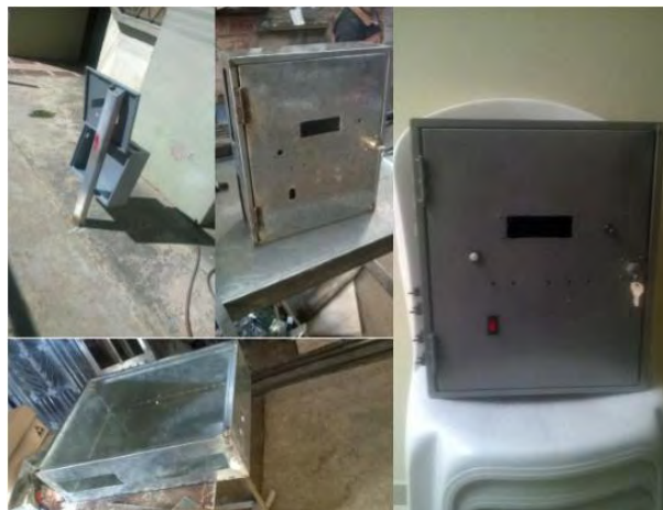
Figura 68. Construcción de carcasa.
