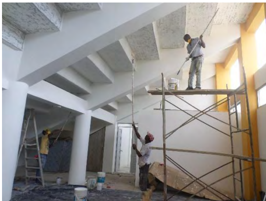
Foto 71: Pintura base gradería por abajo.
