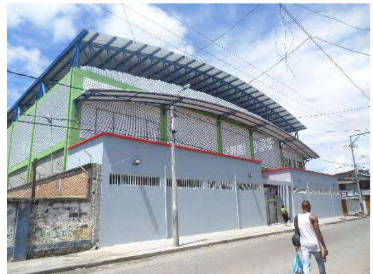
Foto 70: Acceso lateral coliseo cubierto panamá
