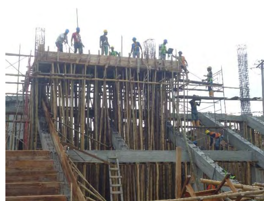
Foto 36: Fundición losa maciza nivel N+7,70 m.
