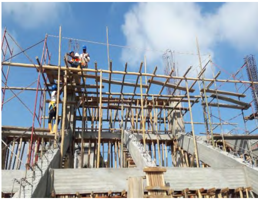
Foto 33: Apuntalamiento de vigas y losa nivel N+7,70 m.
