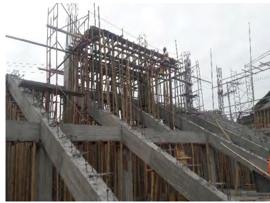
Foto 34: Panorámica viga de amarre nivel N+7,70 m
