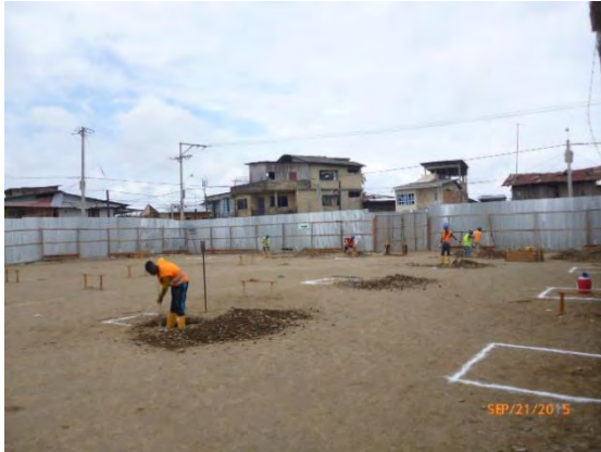
Foto 8: Inicio excavación para cimentación zapatas aisladas.
