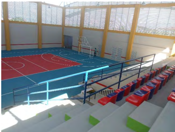
Foto 91: Panorámica gradería y cancha polideportiva.
