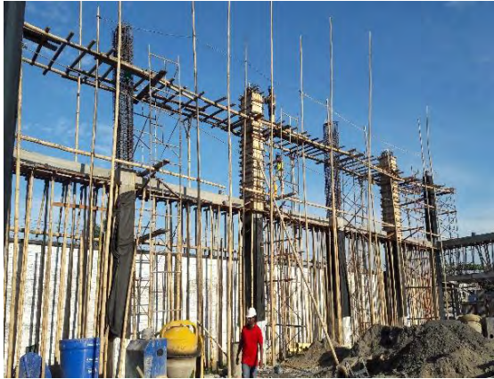
Foto 28: Armado hierro columnas hasta el nivel N+9,55 m
