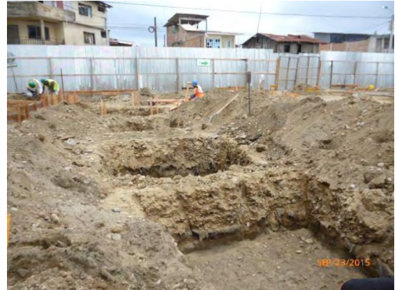
Foto 9: Excavación de cimentación zapatas.
