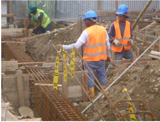
Foto 24: Armado de Hierro de vigas de cimentación.
