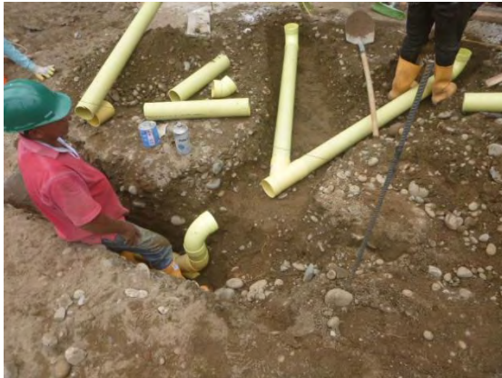
Foto 10: Excavación para instalación de tubería sanitaria.
