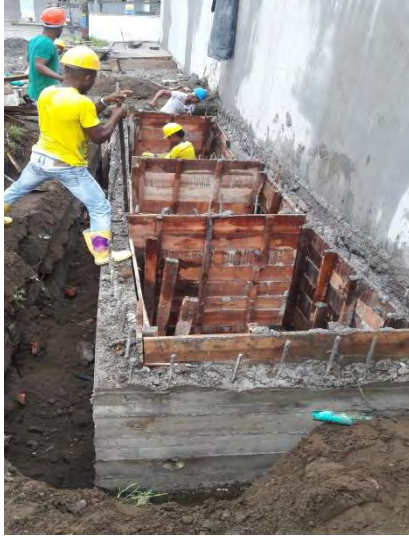
Foto 75: Fundición tanque séptico.
