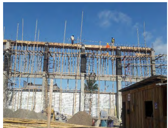
Foto 31: Encofrado viga de amarre nivel N+9,55 m.
