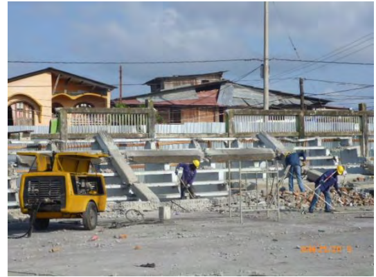
Foto 4: Obras de demolición de gradería.
