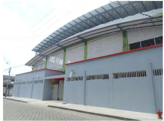
Foto 74: Zona de andenes perimetral.
