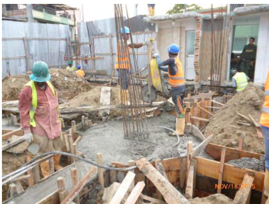
Foto 22: Fundición de concreto para zapatas
