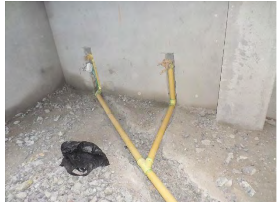
Foto 56: instalación sanitaria lavamanos.
