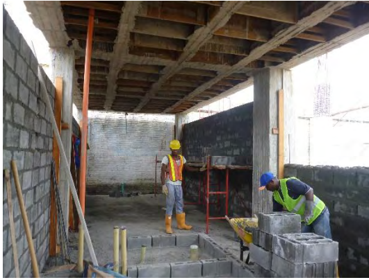
Foto 43: Construcción de muros en mampostería.
