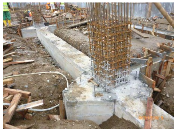
Foto 23: Concreto zapatas y vigas de cimentación.
