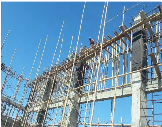
Foto 30: Apuntalamiento para viga de coronamiento nivel N+9,55 m.
