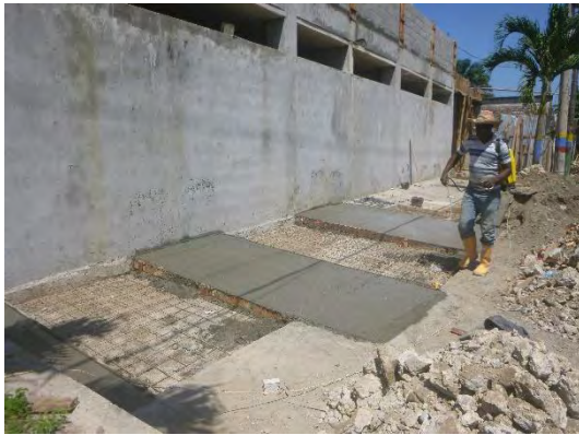
Foto 73: Fundición andenes perimetral.
