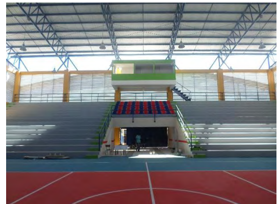
Foto 72: Pintura de acabado para gradería.
