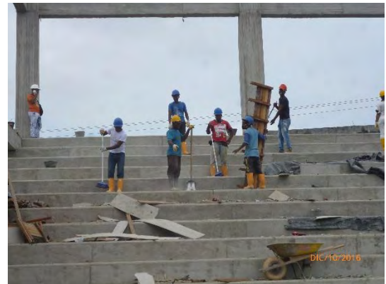
Foto 40: Encofrado de gradería y figurado de hierro
