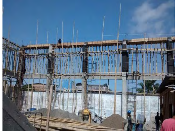
Foto 29: Columnas fundidas y curado del concreto.
