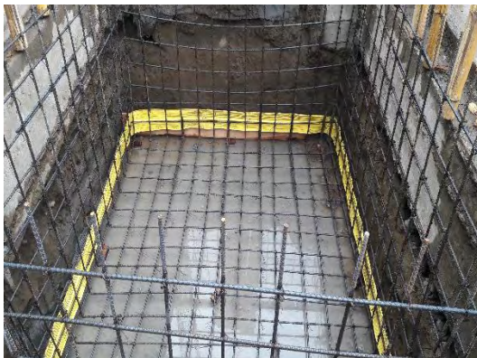
Foto 77: Armado hierro y fundición pozo agua potable.
