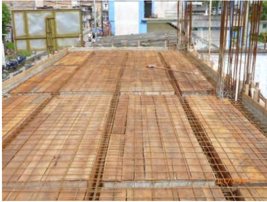
Foto 37: Fundición concreto losa aligerada
