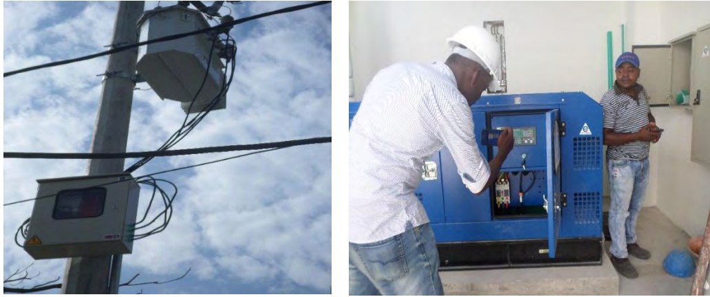
Figura 12. Instalación de un transformador
