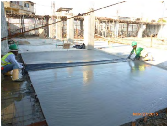
Foto 41: Afinado de concreto para placa de piso
