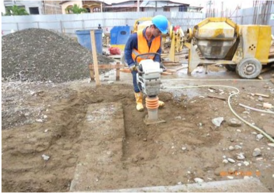
Foto 12: Relleno con material de sitio en cimentación.
