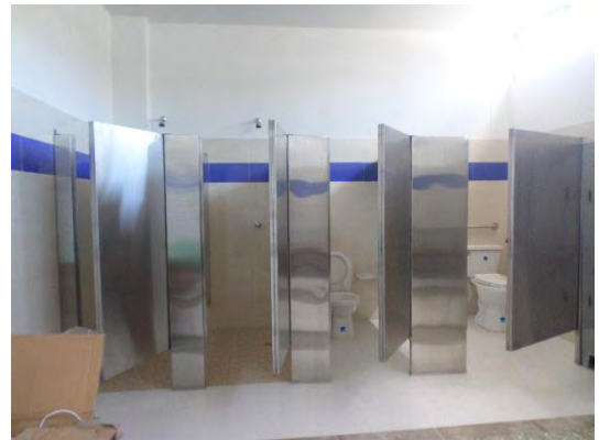
Foto 62: Sanitarios y duchas camerinos.
