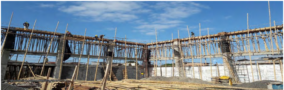
Foto 32: Panorámica viga de amarre nivel N+9,55 m.
