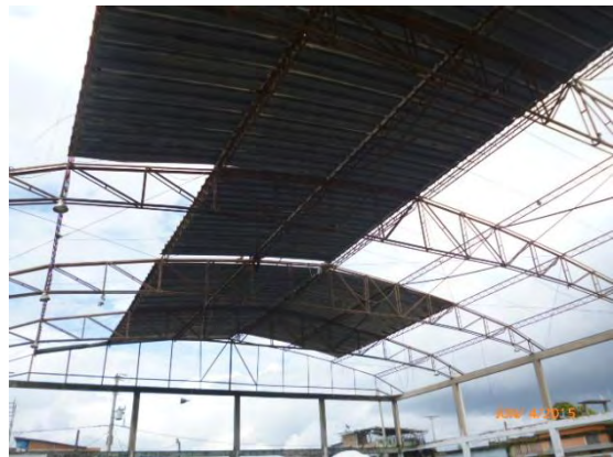
Foto 2: Desmonte de cubierta coliseo Panamá
