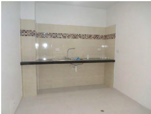
Foto 61: Enchape cocina cafetería
