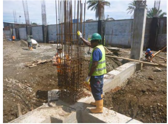
Foto 25: Concreto vigas de cimentación.
