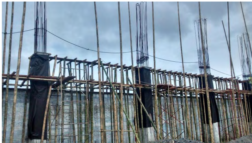
Figura 11. Curado del concreto
