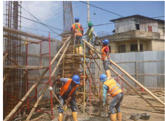
Foto 27: Encofrado apuntalamiento y fundición de columnas.
