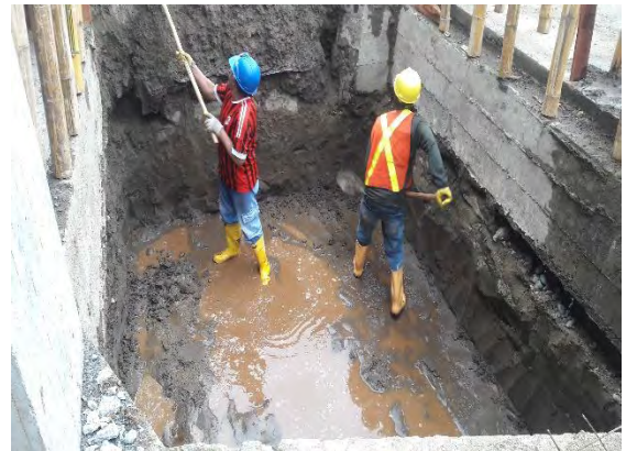
Foto 11: Excavación para fabricación pozo agua potable.
