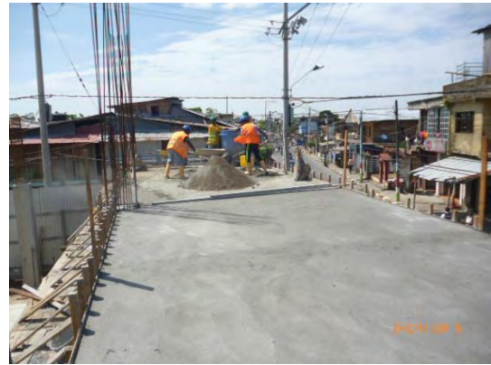
Foto 38: Losa aligerada nivel N+3,70 m
