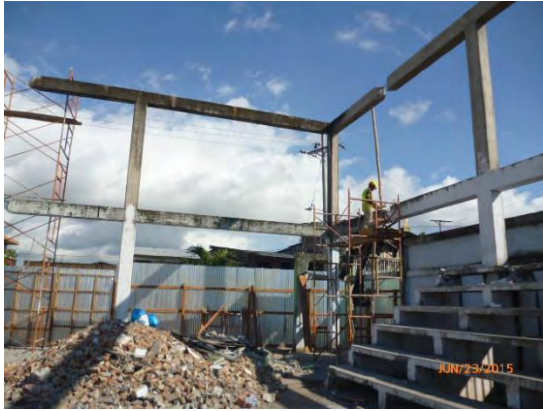
Foto 3: Demolición de pórticos
