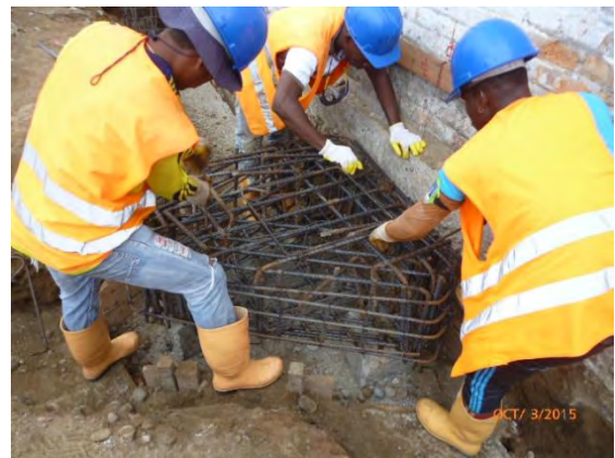
Foto 21: Armado hierro zapatas.
