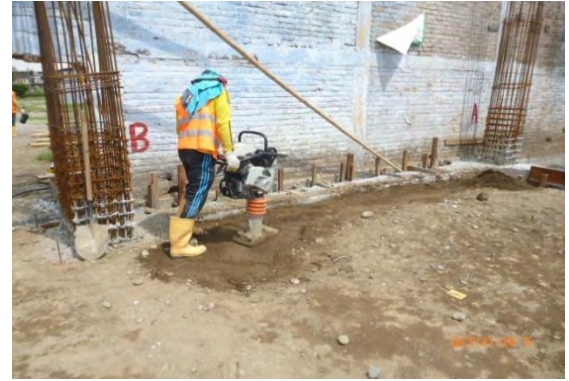
Foto 13: Relleno con material de sitio en cimentación.
