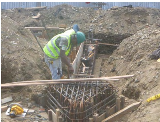
Foto 20: Armado hierro para zapatas aisladas.
