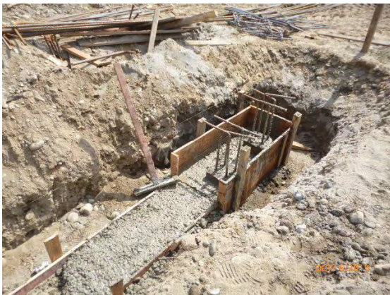
Foto 18: Fundición de concreto de limpieza vigas y zapatas
