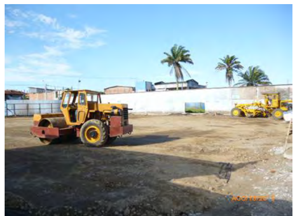
Foto 6: Compactación de material granular base sobre terreno.
