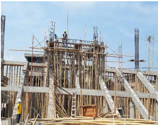
Foto 35: Armado hierro vigas y losa maciza N+7,70 m.
