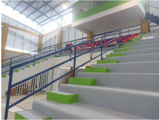
Foto 49: Pintura de gradería, cancha y cabina de transmisión
