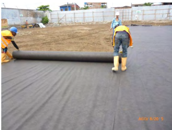
Foto 5: instalación de geotextil para mejoramiento de terreno
