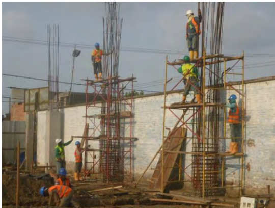
Foto 26: Armado hierro columnas hasta el nivel N+5,15 m
