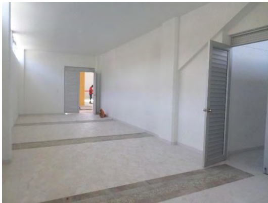
Foto 51: Piso trafico 5 zona de calentamiento
