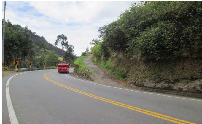
Figura 10. Propiedad privada con acceso a directo a la ruta localizado en una curva horizontal donde la distancia de visibilidad es reducida PR 24+510
