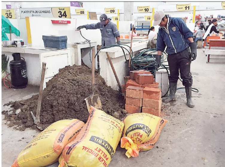
Imagen 5. Demolición de muros sin terminar
