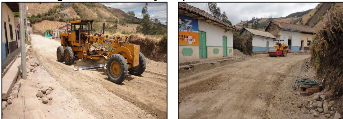
Fotografía 27. Extensión y compactación de base K0+040.
