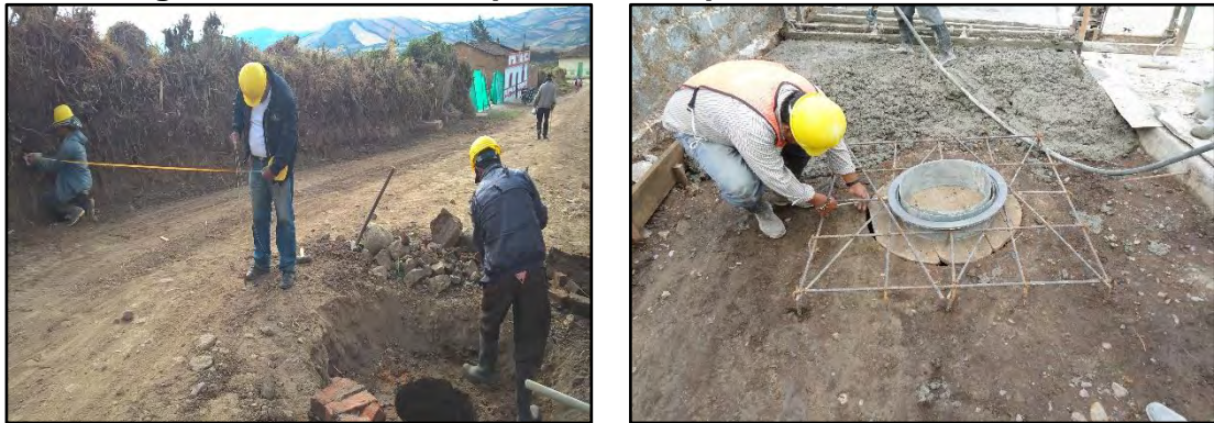
Fotografía 29. Realce de pozos de inspección K0+000 – K0+200.
