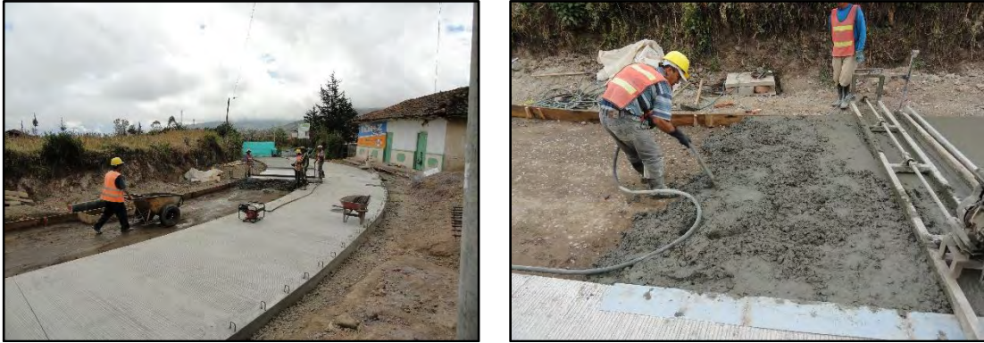
Fotografía 32. Transporte y vibrado del concreto K0+000 – K0+200.
