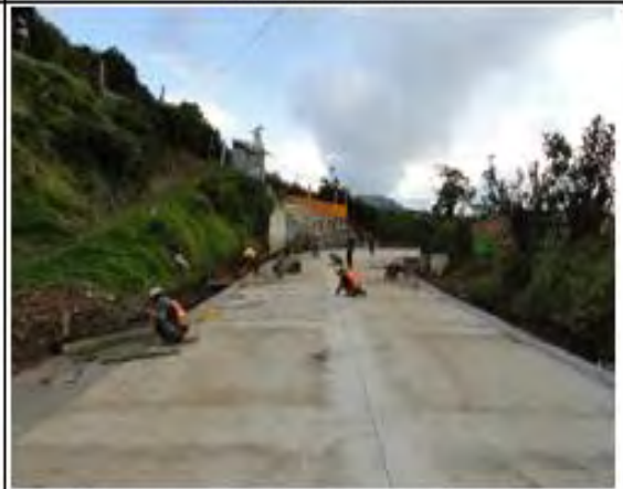
FOTOGRAFIA 10. Sector pavimentado en concreto rígido K0+200
