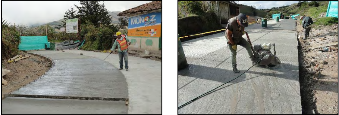
Fotografía 36. Curado del concreto y aserrado de juntas K0+000 – K0+200.
