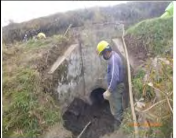
FOTOGRAFIA 14. Limpieza manual de alcantarilla K5+344
