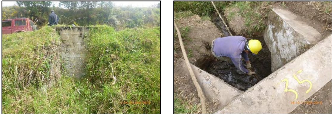
Fotografía 15. Limpieza de estructura de salida alcantarilla K5+344.
