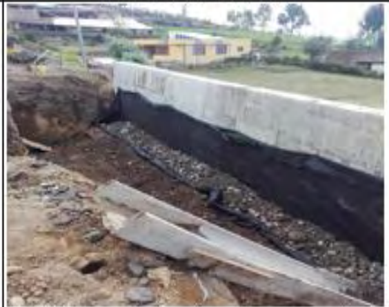
FOTOGRAFIA 8. Construcción de muro de contención en concreto reforzado, margen izquierda K7+648
