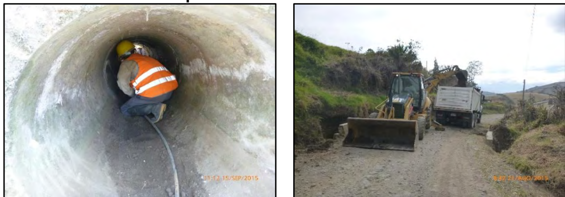
Fotografía 16. Chequeo interno de tubería K5+511. Desalojo de material de limpieza de alcantarilla K2+180.
