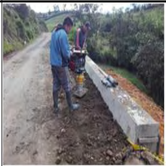
FOTOGRAFIA 20. Mura de contencion en concreto ciclópa K5+640
