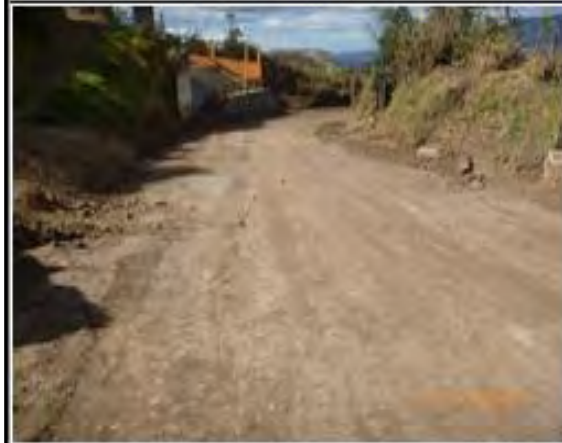
FOTOGRAFIA 9. Sector en proceso de regularización K0+200
