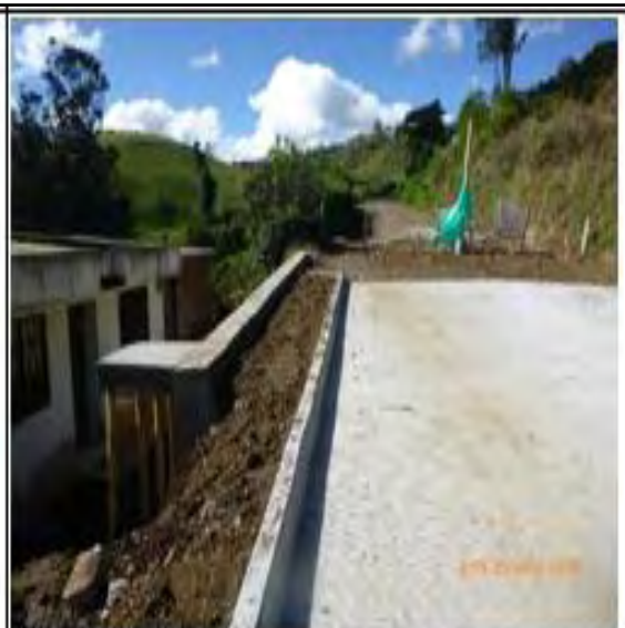
FOTOGRAFIA 18. Mura de contencion en concreto ciclópa K0+200
