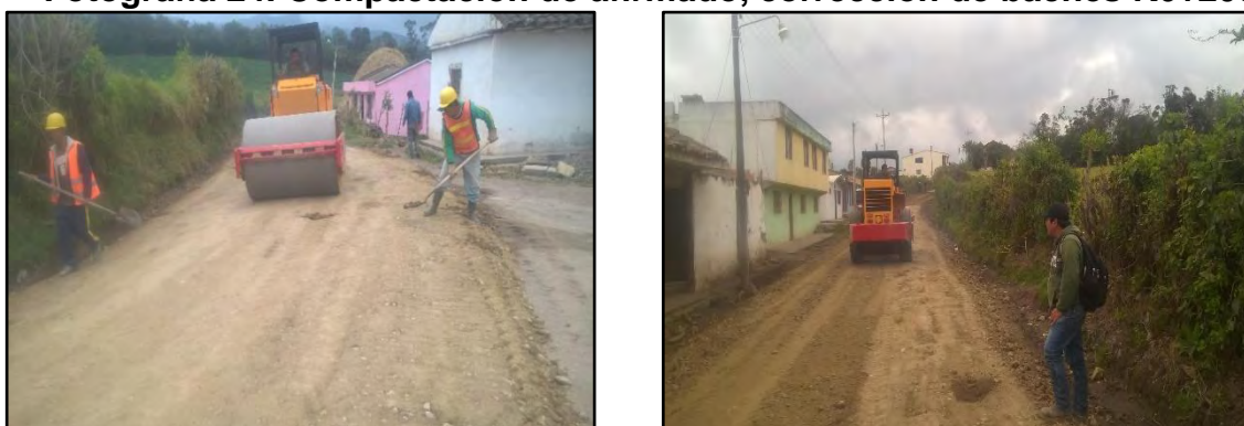
Fotografía 24. Compactación de afirmado, corrección de baches K6+200.
