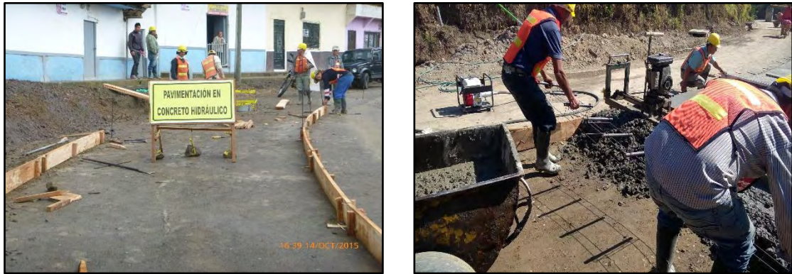
Fotografía 30. Instalación de formaleta y pasadores de transferencia de carga K0+000 – K0+200.
