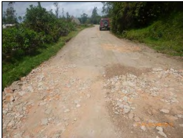
Fotografía 6. Bacheo utilizando escombros de construcción K5+900.
