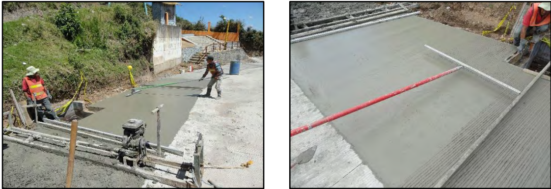
Fotografía 35. Acabado y texturizado de la superficie K0+000 – K0+200.
