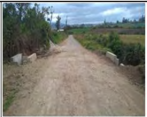
FOTOGRAFIA 6. Alcantarilla terminada, la capacidad de drenaje es de 36" y cumple la normatividad vigente K4+905
