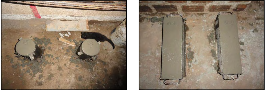
Fotografía 34. Toma de muestras de cilindros y vigas K0+000 – K0+200.
