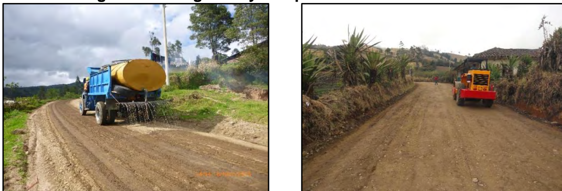
Fotografía 23. Irrigación y compactación de afirmado K1+600.
