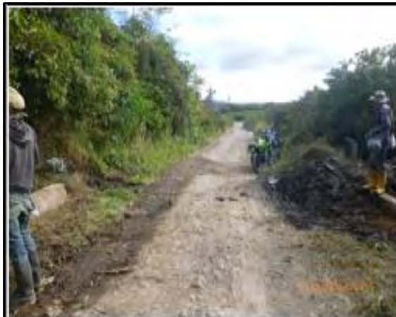
FOTOGRAFIA 5. Alcantarilla en mal estado estructural, presenta muy poca capacidad de drenaje K4+905
