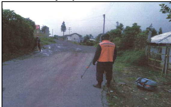
Imagen 3. Localización y replanteo vía Guaitarilla - Arrayanes
