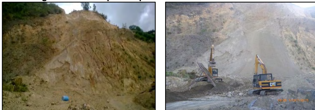
Fotografía 17. Veta para explotar recebo. Tamizado de material.
