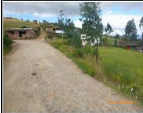
FOTOGRAFIA 7. Banca en riego de calapra, margen izquierda K7+648
