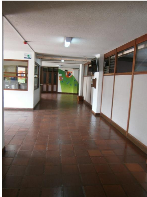
Figura 2. Bloque Alberto Quijano Guerrero, primer piso – parte interna
