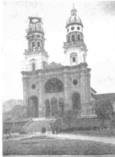
Figura 6. Torre de la Iglesia de Santiago afectada por el sismo del 14 de Julio de 1947.
