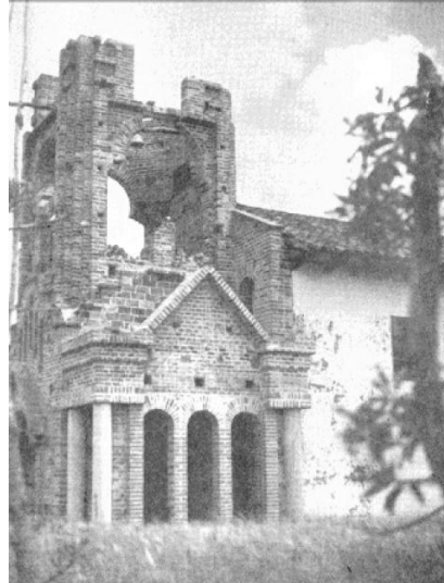
Figura 8. Daños en la torre de la Iglesia de Pandiaco en el sismo del 14 de Julio de 1947.
