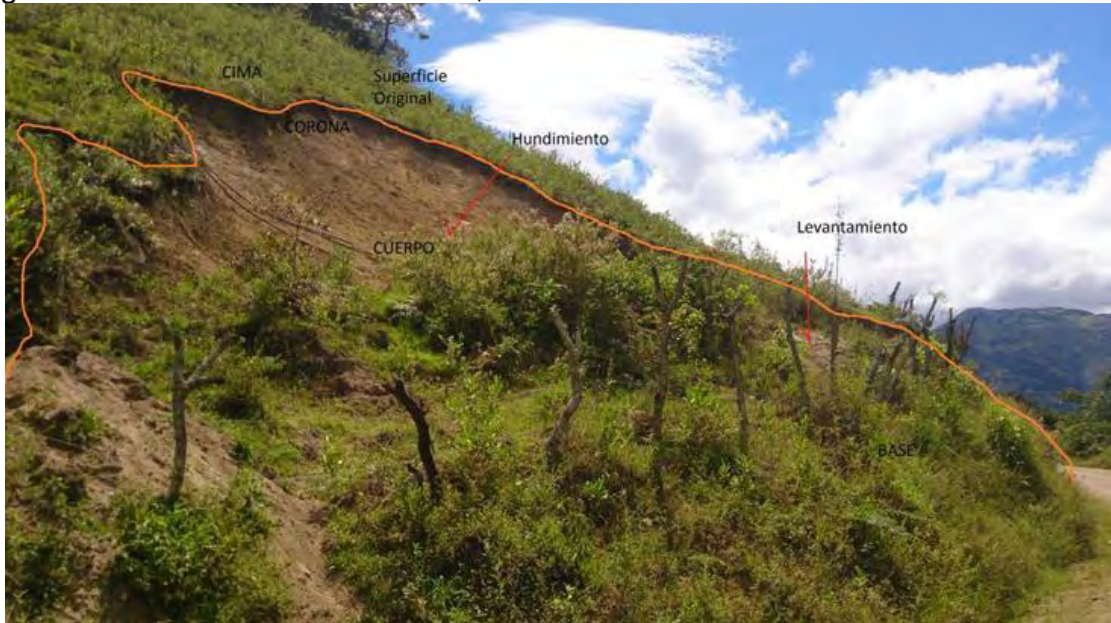
Figura 24. Deslizamiento rotacional, localizado en la vereda Pitalito Alto.
