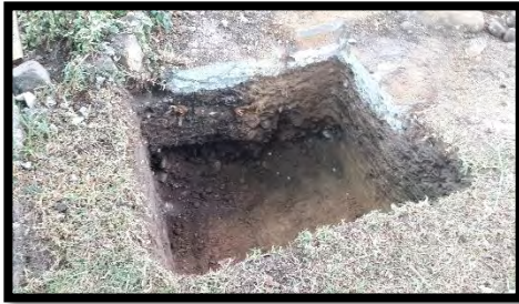
Figura 75. Excavación de material común.
