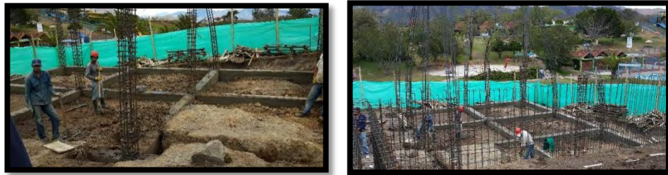
Figura 6. Vigas de cimentación.
