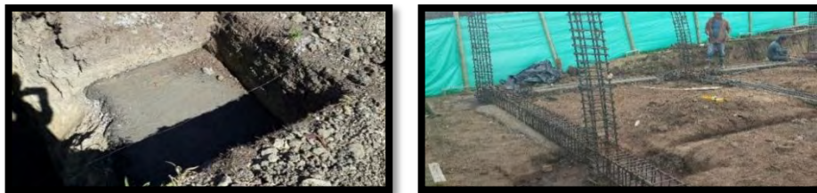
Figura 4. Solado de limpieza.
