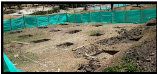
Figura 1. Excavación de material común
