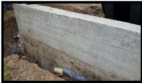
Figura 70. Muro de contención.
