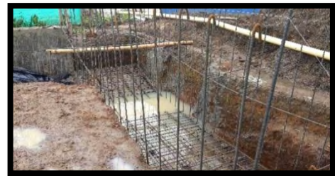
Figura 45. Armado y figurado de acero desarenador.
