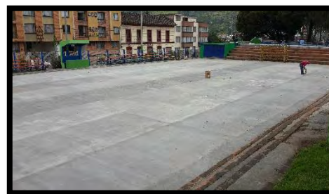
Figura 113. Losa en concreto rígido terminada.
