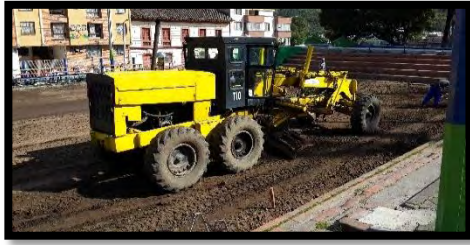
Figura 105. Nivelación del terreno.
