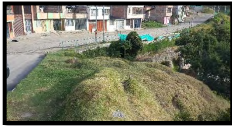
Figura 126. Localización y replanteo.
