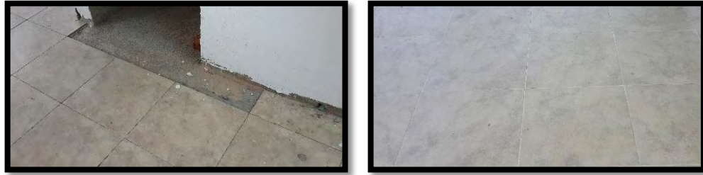
Figura 30. Enchape de piso en cerámica.
