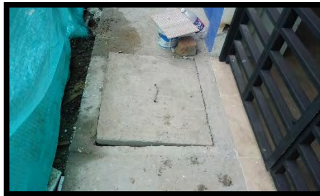
Figura 122. Cajillas de inspección.
