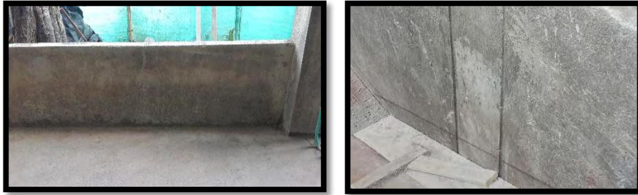
Figura 20. Repello afinado para muros y estructura con juntas de dilatación.
