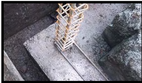
Figura 116. Armado de acero de estructuras.
