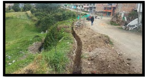
Figura 127. Excavación cerramiento perimetral.
