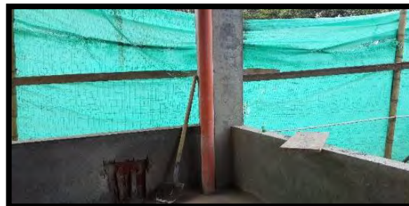
Figura 25. Bajante de aguas lluvias.
