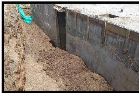
Figura 39. Relleno tanques de almacenamiento.
