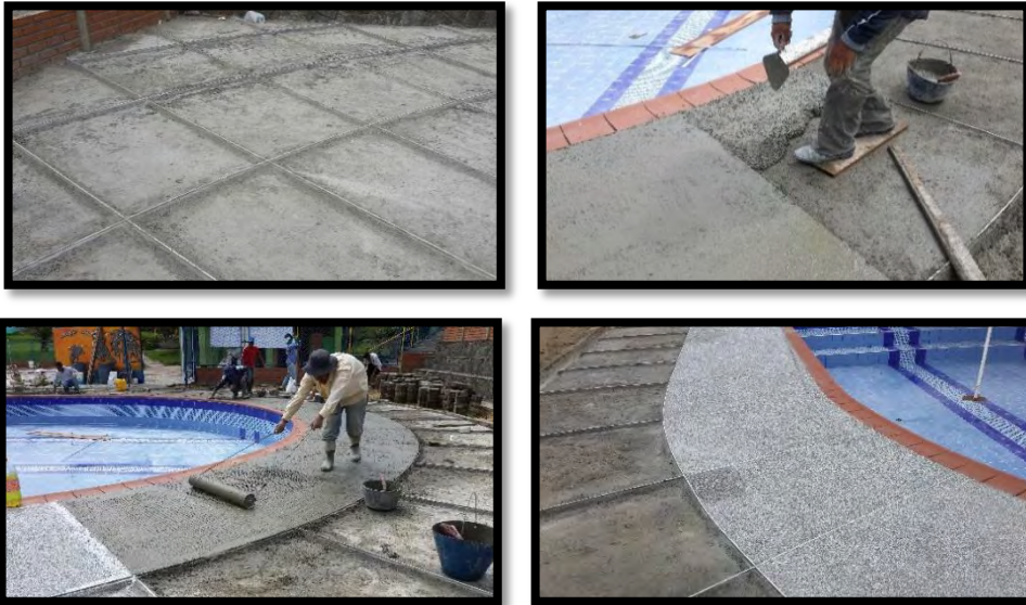
Figura 65. Enchape de piso en granito lavado.
