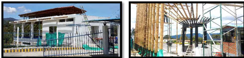
Figura 37. Estado actual sede administrativa Chachagüí.
