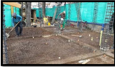
Figura 79. Vigas de cimentación.
