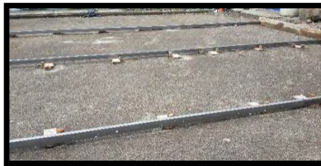
Figura 107. Colocación de rieles para iniciar la reposición de paños.
