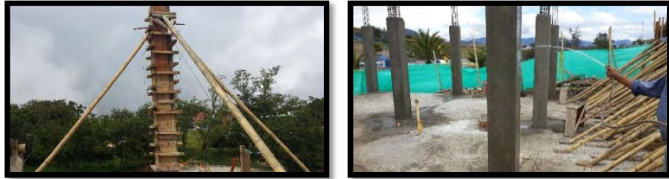
Figura 12. Columnas en concreto.
