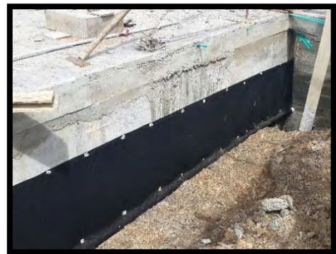
Figura 10. Filtro con Geodren Planar con tubería perforada de 3".
