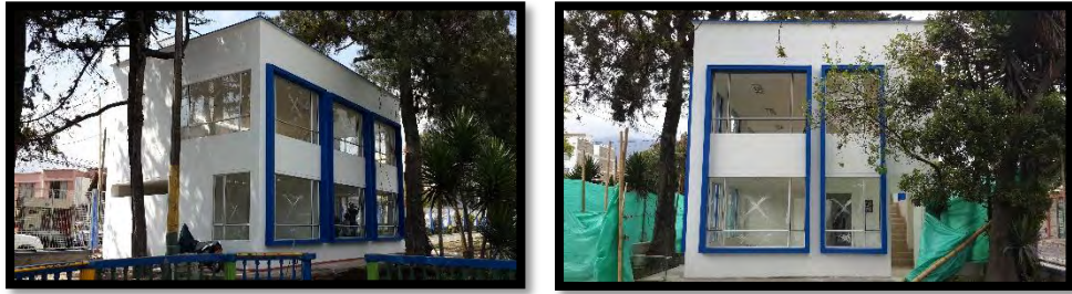
Figura 98. Estuco y pintura.
