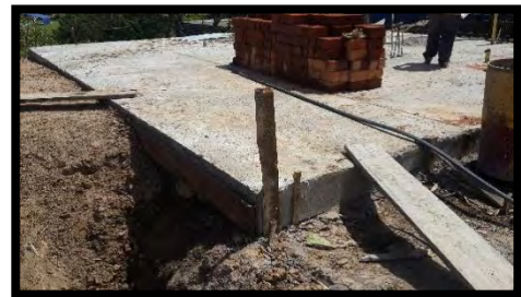
Figura 49. Losa para planta de tratamiento prefabricada.
