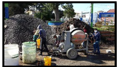
Figura 110. Producción de concreto.
