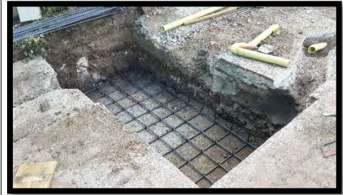
Figura 78. Zapatas en concreto.
