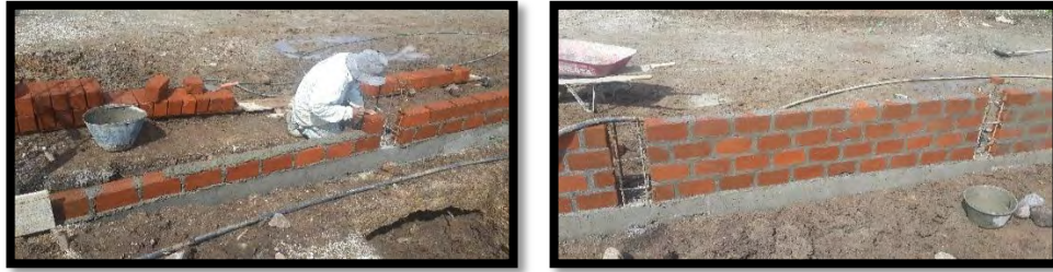
Figura 130. Muro en ladrillo común.
