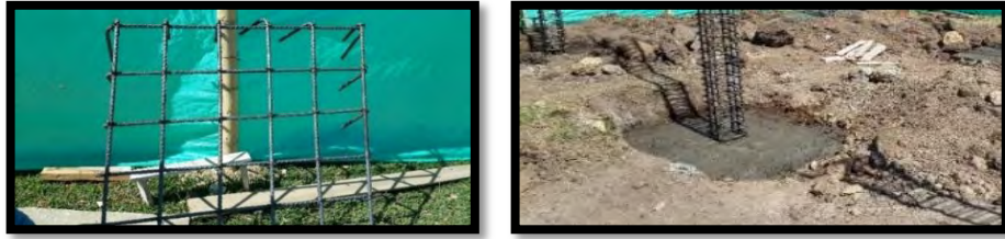
Figura 5. Zapatas en concreto.
