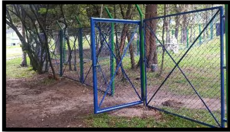
Figura 134. Puerta de acceso.
