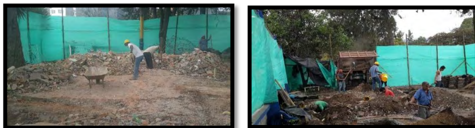
Figura 74. Retiro y disposición de sobrantes.
