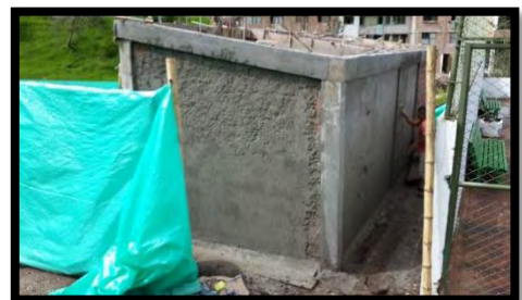
Figura 119. Repello de muros.
