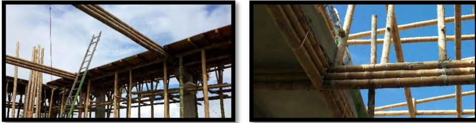
Figura 33 Estructura de cubierta.
