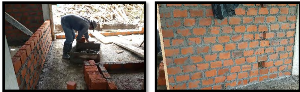
Figura 19. Muro en saga ladrillo común.
