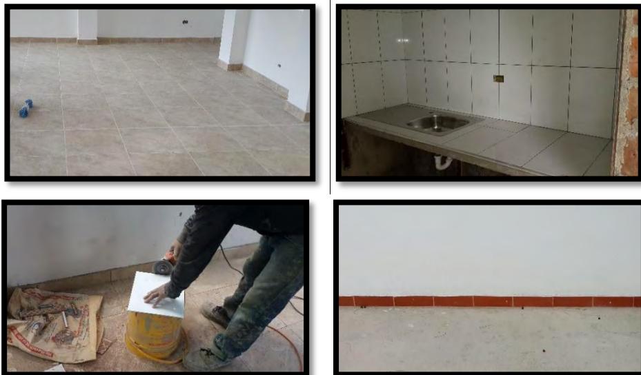
Figura 100. Enchapes pared y piso.
