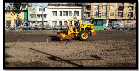
Figura 106. Compactación del terreno.
