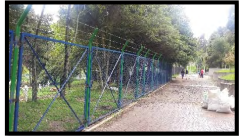
Figura 135. Cerramiento metálico Bioparques.
