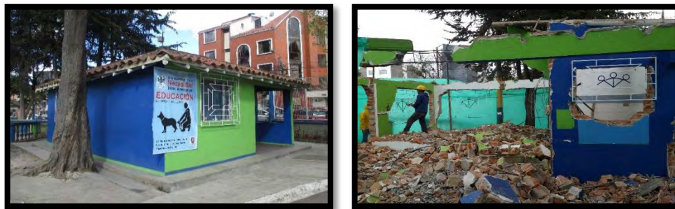
Figura 73. Demolición sede administrativa existente.
