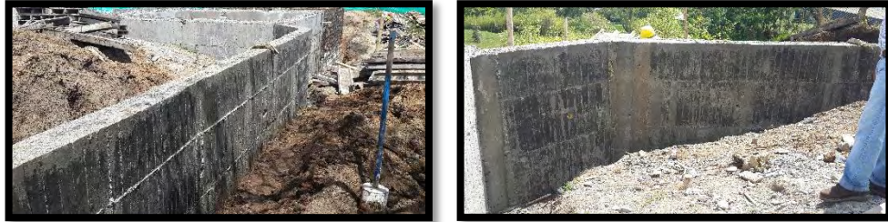
Figura 47. Muro de contención.
