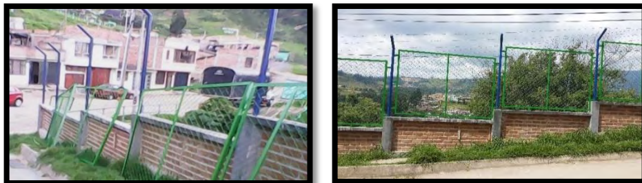
Figura 132. Cerramiento metálico en módulos.
