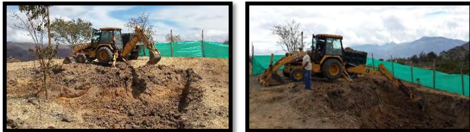
Figura 38. Excavación tanques de almacenamiento.
