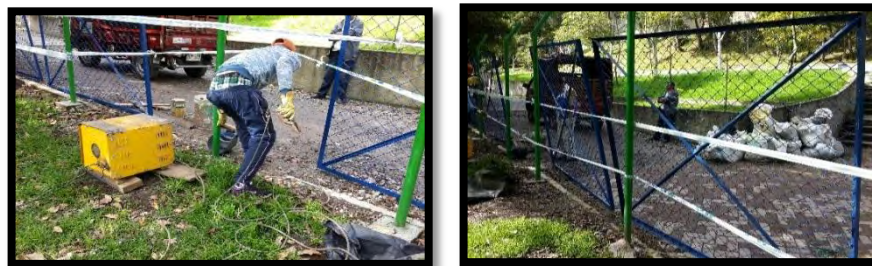
Figura 133. Instalación cerramiento bioparques.
