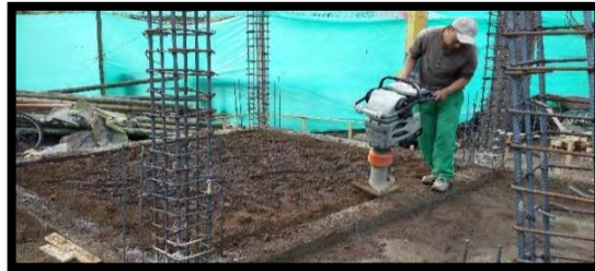
Figura 3. Relleno compactado con material de préstamo (recebo).
