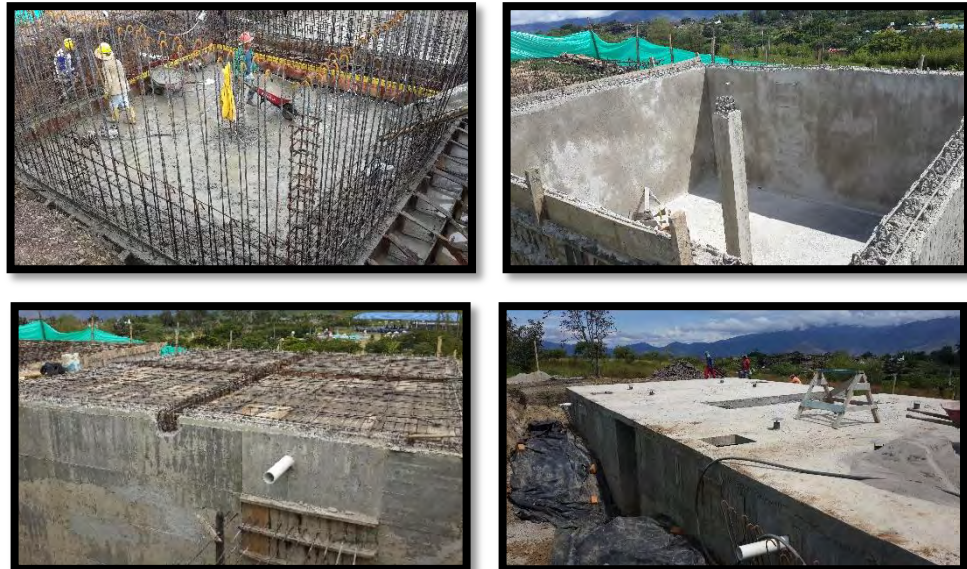
Figura 42. Fundición de tanques de almacenamiento.
