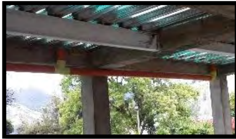
Figura 93. Bajante de aguas lluvias.
