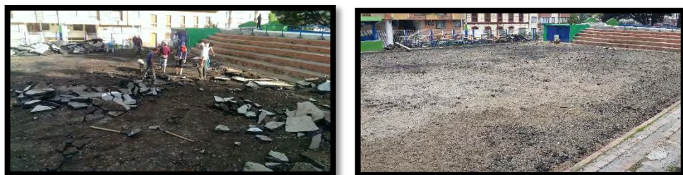
Figura 104. Demolición placa en asfalto.
