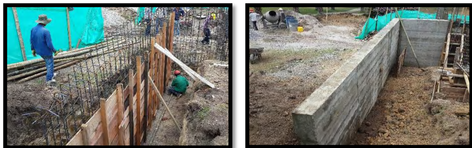
Figura 7. Muro de contención
