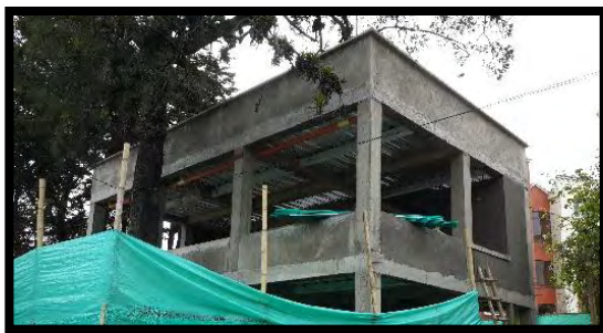
Figura 88. Repello afinado para muros y estructura
