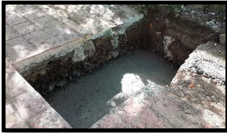
Figura 77. Solado de limpieza.
