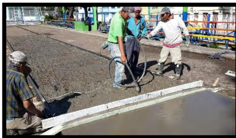
Figura 109. Vibrado del concreto y texturizado del concreto.
