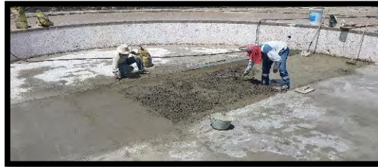
Figura 59. Repello impermeabilizado mortero 1:3.
