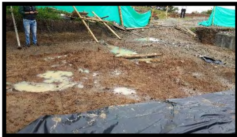
Figura 48. Mejoramiento con recebo.
