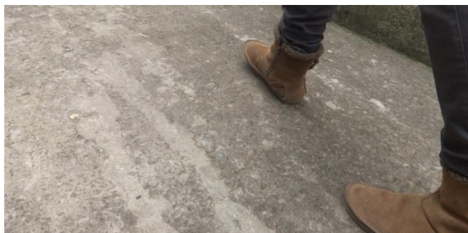
Foto 4. Pasos en los Barrios Alameda II y El Común.
