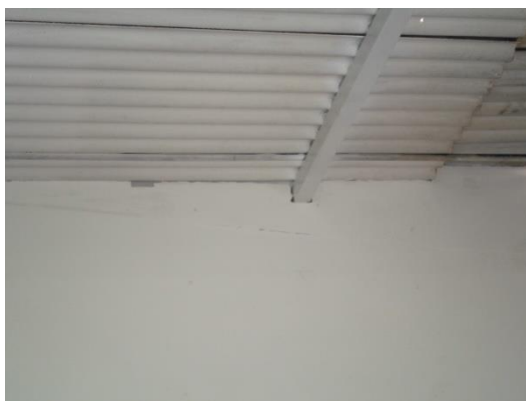
Figura 14. Estado de paredes y techos visita final
