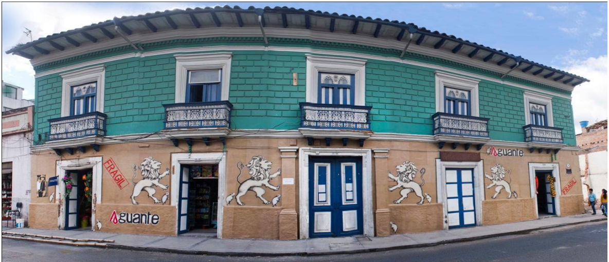
Imagen 14. Casa tienda antes de su demolición para dar paso a la avenida de la carrera 27 en el municipio de Pasto. “En dicha casa tienda, fungieron los Juzgados de Pasto, y posteriormente, diversos negocios”. Fuente: Fotografía tomada por Johana Delgado Araujo.
