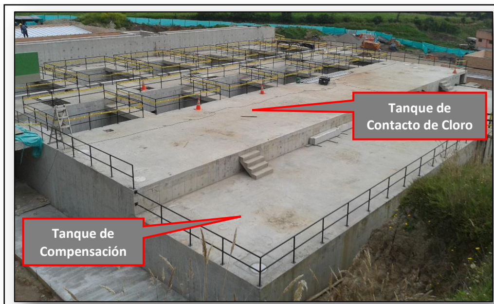
Figura 8. Módulo de procesos – parte estructural terminada
