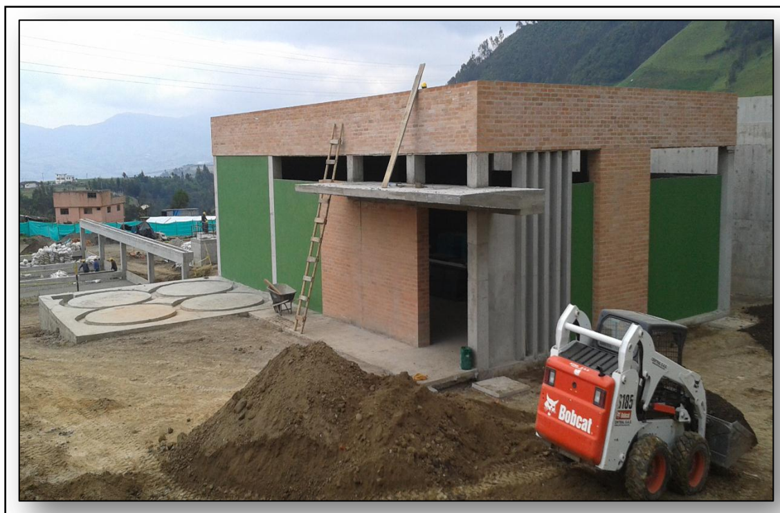
Figura 18. Edificio de químicos y bodega - terminado
