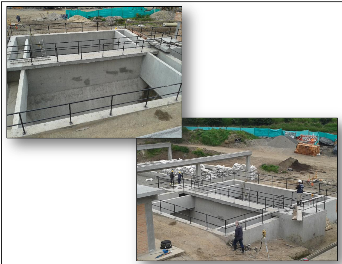
Figura 12. Decantador de lodos – parte estructural terminada
