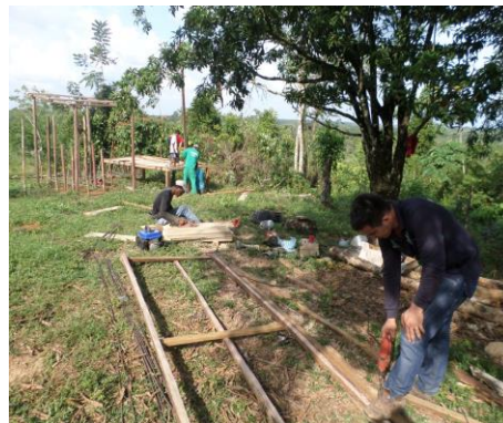
Figura 25. Construyendo la Estructura.
