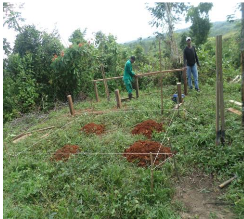
Figura 24. Preparación del Terreno.
