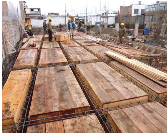
Figura 20. Instalación de casetones
