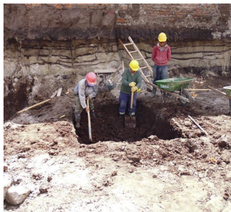
Figura 6. Excavación para el cimiento
