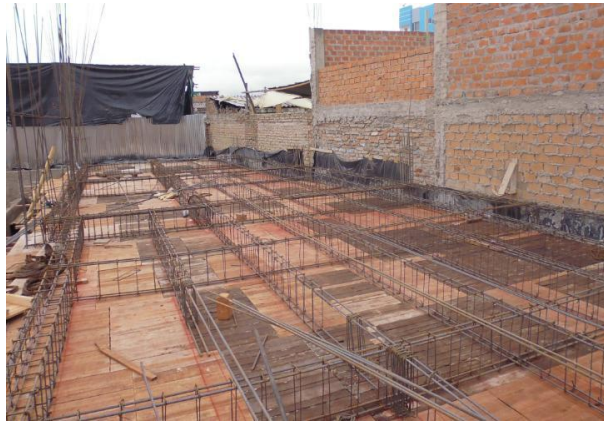
Figura 23. Armado del Refuerzo en losa
