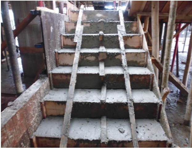
Figura 53. Fundición de escaleras
