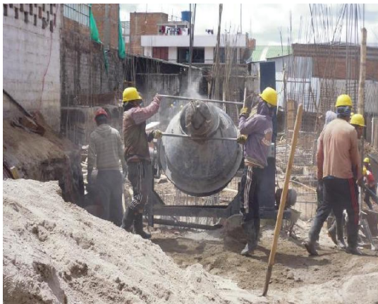
Figura 28. Concreto preparado en obra
