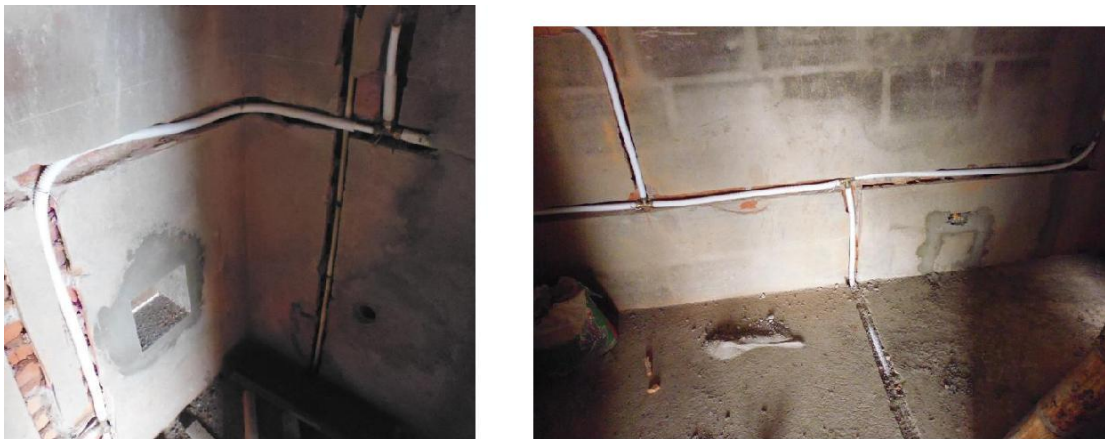
Figura 42. Instalación de tubería interna Pe al Pe de gas domiciliario
