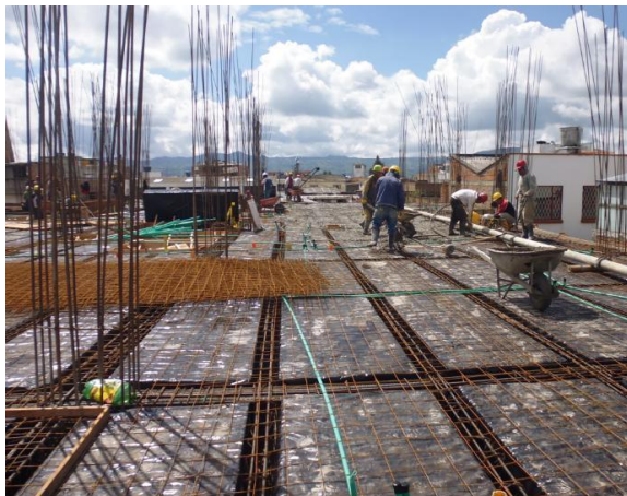
Figura 32. Instalación de la malla electrosoldada
