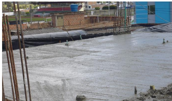
Figura 34. Curado de la losa
