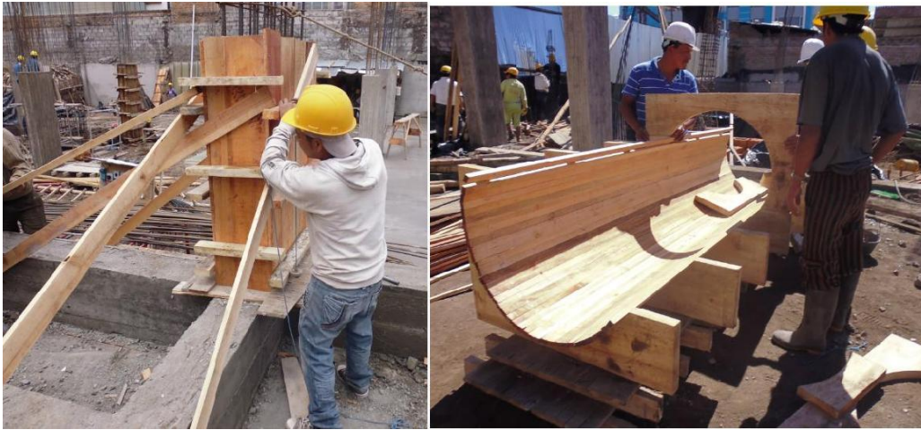
Figura 12. Formaleta de columnas
