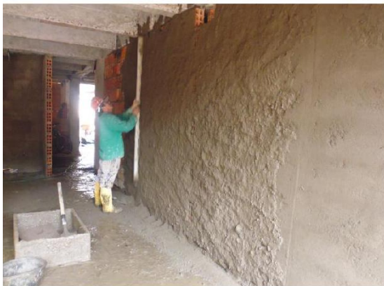
Figura 50. Repello de muros internos
