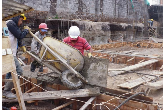
Figura 10. Vigas de Cimentación
