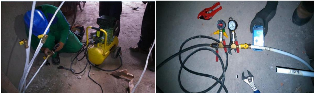
Figura 43. Pruebas de tubería gas (manómetro)
