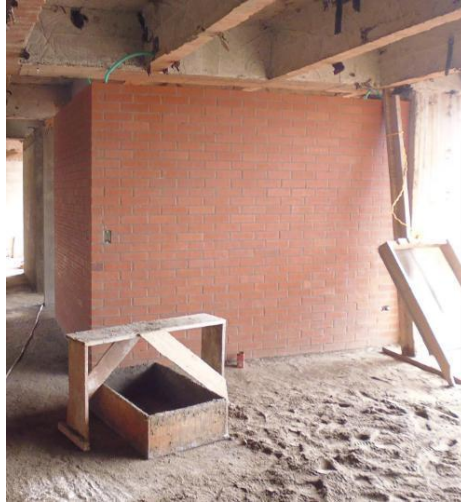
Figura 48. Ladrillo visto interno
