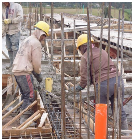
Figura 30. Fundición de las vigas
