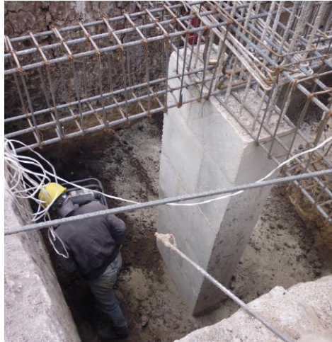
Figura 7. Compactación por medio de saltarín
