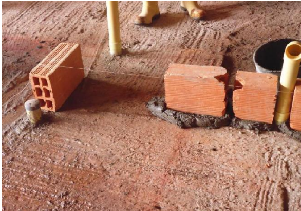
Figura 45. Verificación de hilada
