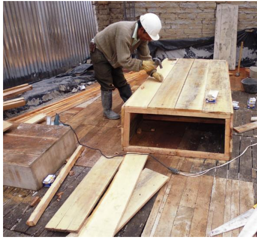
Figura 19. Construcción de casetones
