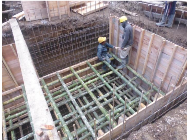
Figura 39. Armado y Formaleta del tanque
