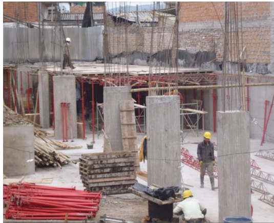
Figura 18. Armado de formaleta para la losa
