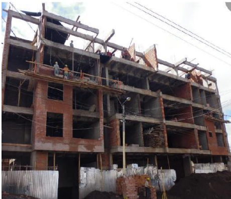
Figura 49. Fachadas del edificio
