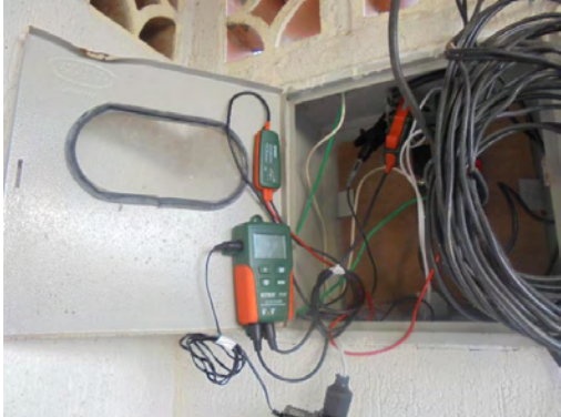
Figura 21 Instalación del registrador de datos
