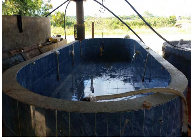
Figura 16. Estanque de cemento de la Estación Piscícola AQUAMAZONIA
