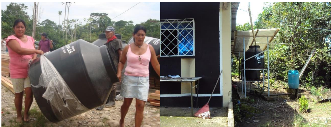
Figura 7. Mecanismo de almacenamiento de agua lluvia.
