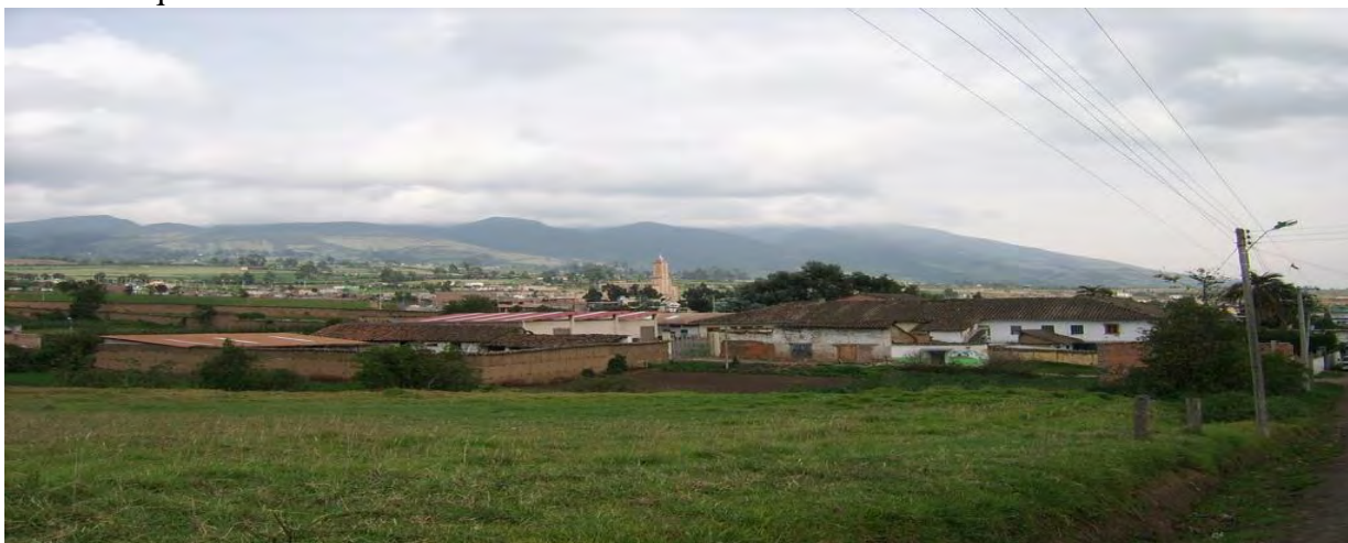
Imagen no. 2 Fotografía del sector
