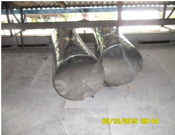
Ilustración 63 Cielo raso reparado sobre el generador 3
