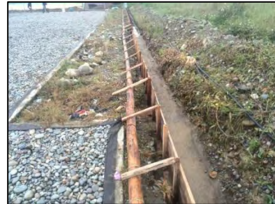
Ilustración 15 Instalación de la primera parte de la formaleta
