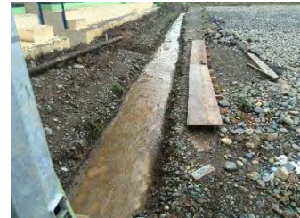
Ilustración 11 Mejoramiento de piso con suelo cemento
