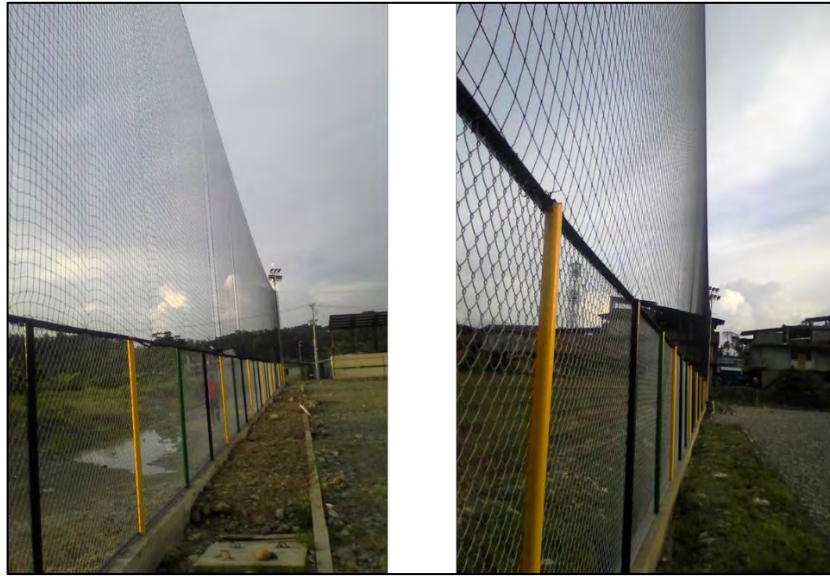
Ilustración 41 Instalación de red de nylon perimetral
