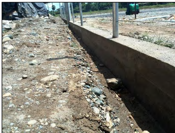
Ilustración 25 Viga de cimentación lista
