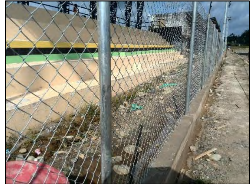
Ilustración 30 Soldadura de malla eslabonada
