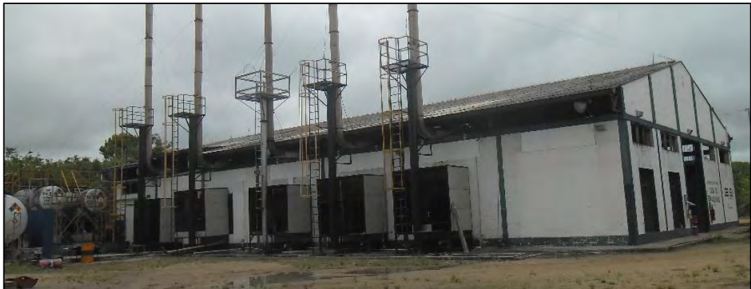
Ilustración 58 Vista general de la casa de maquinas
