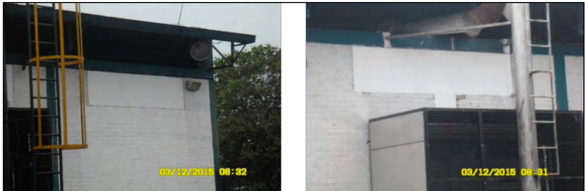
Ilustración 67 Sellado del muro exterior sobre los silenciadores y salida de aire
