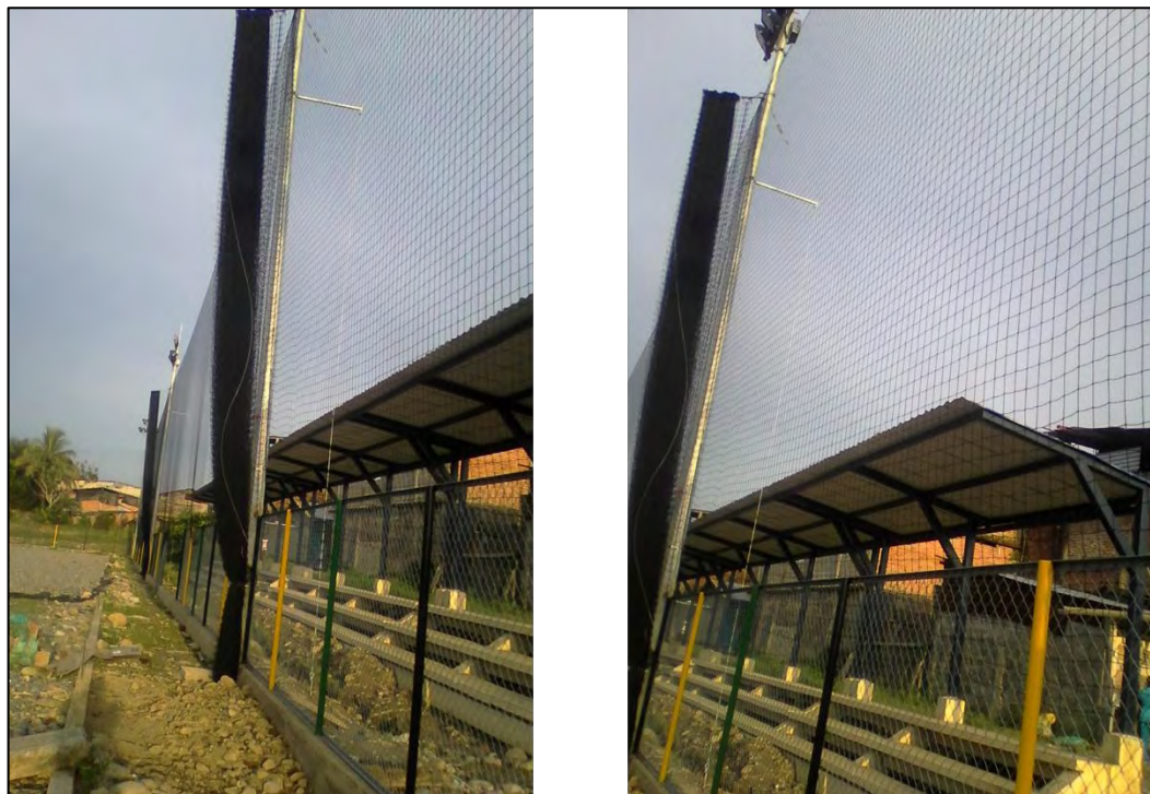
Ilustración 42 Instalación de divisiones en red de nylon
