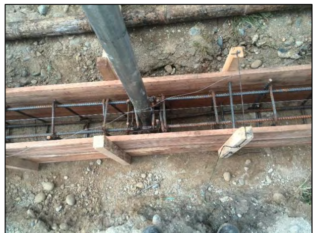
Ilustración 28 Soldadura de los tubos
