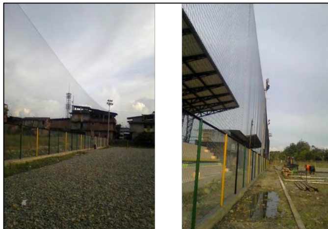
Ilustración 34 Instalación de la guaya
