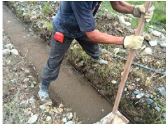
Ilustración 10 Mejoramiento de piso con recebo compactado e=0.1m
