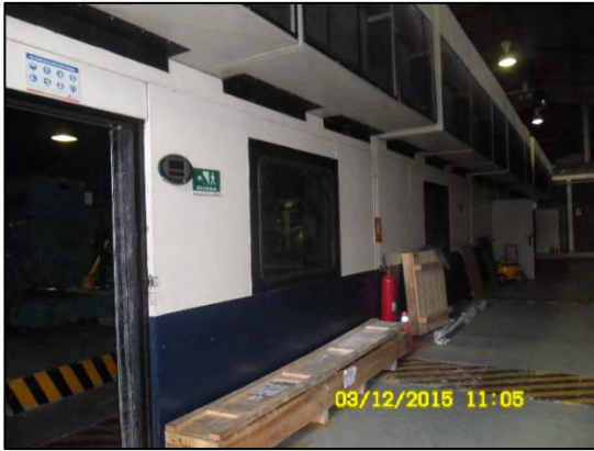
Ilustración 56 Muro MA-2 visto desde fuera de la cabina
