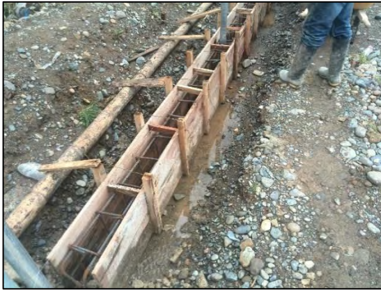
Ilustración 18 Instalación de la segunda parte de la formaleta
