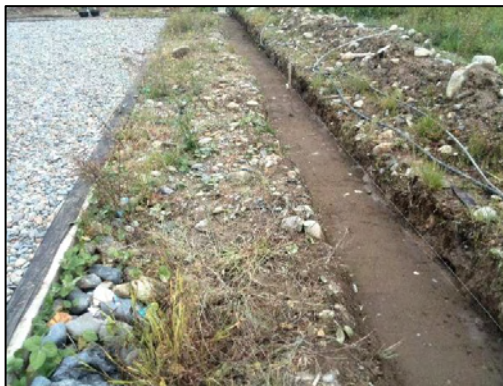
Ilustración 9 Excavación en material común h = 0,45 m
