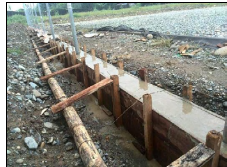
Ilustración 20 Viga de cimentación recién fundida
