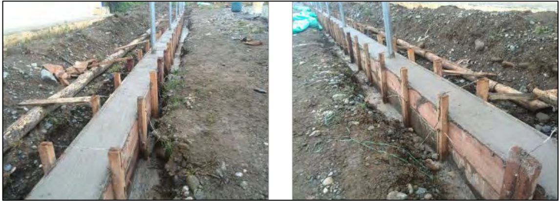
Ilustración 21 Viga de cimentación en etapa de fraguado
