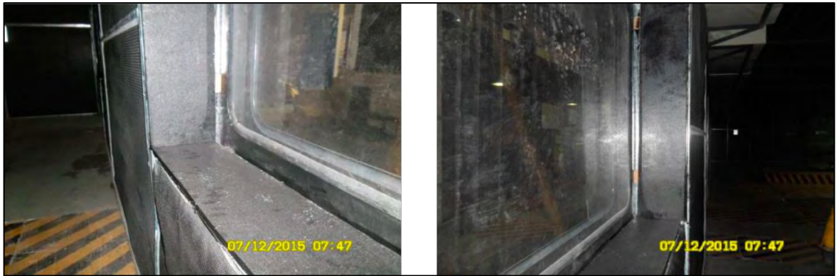
Ilustración 66 Sellado de contorno de las ventanas acústicas
