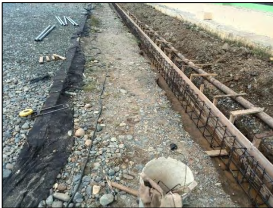
Ilustración 16 Instalación del refuerzo
