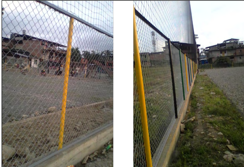
Ilustración 32 Pintura de tubos y ángulos
