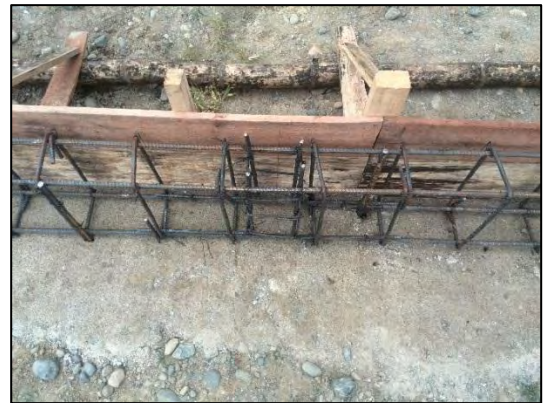
Ilustración 17 Instalación refuerzo para tubos
