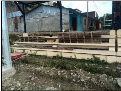
Ilustración 14 Armado de formaletas
