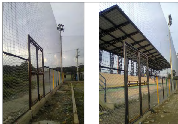
Ilustración 36 Instalación de puertas
