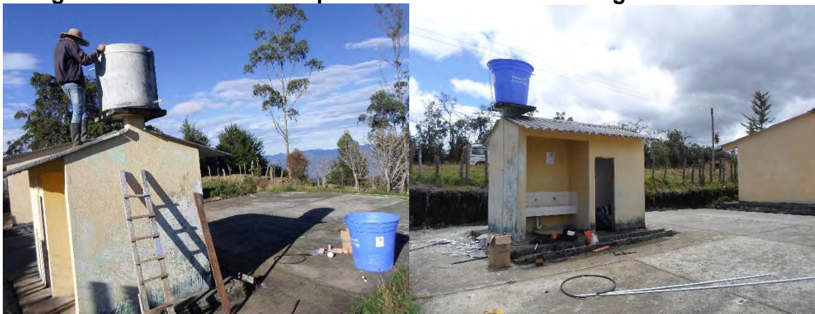
Fotografía 63. Cambio de tanque de almacenamiento de agua de 500 litros.
