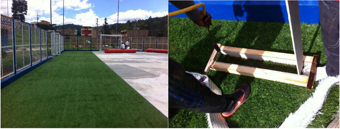
Fotografía 54. Instalación de tapetes de grama sintética y demarcación de la cancha. armado e instalación de malla de cerramiento.
