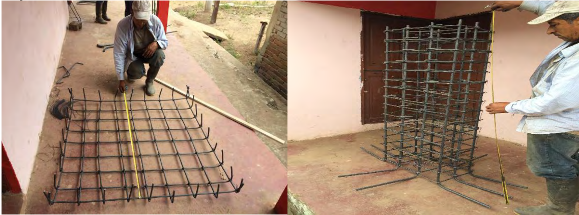
Fotografía 57. Figurado y armado del acero de refuerzo para columnas y zapatas.
