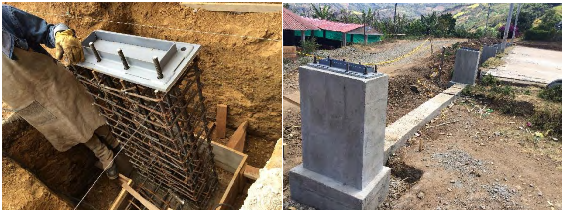
Fotografía 58. Fijación y nivelación de platinas metálicas para anclajes de estructuras.
