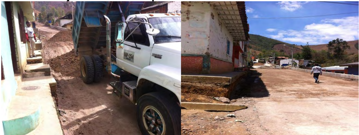
Fotografía 38. Extendido, conformación, nivelación y compactación de material de mejoramiento con espesor de 30cm sobre la Carrera 10ma.
