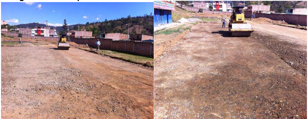
Fotografía 50. Compactación de material seleccionado.
