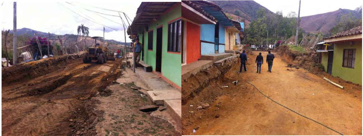
Fotografía 37. Cajeo y nivelación sobre la carrera 10
