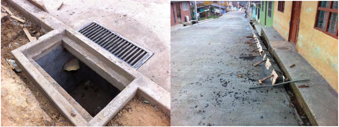
Fotografía 44. Construcción de sumideros sencillo en mampostería tipo i y armado y fundición de bordillos.
