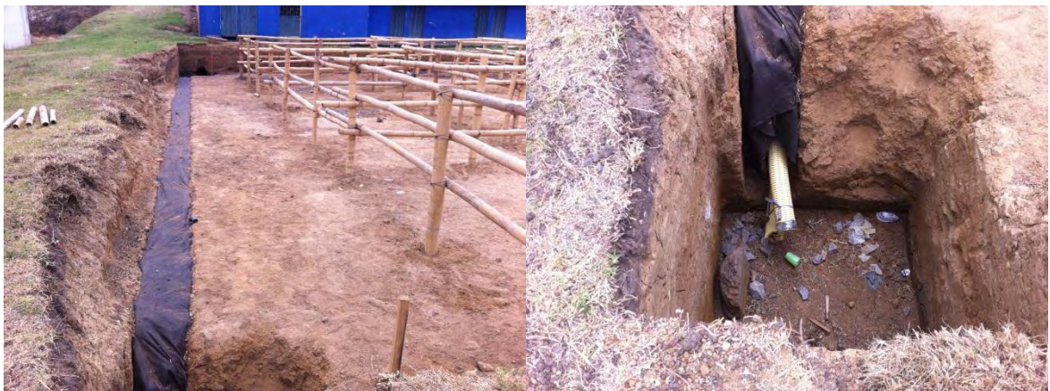
Fotografía 48. Construcción de filtro en geotextil con tubería PVC para filtro de 6" en los alrededores de la cancha sintética.
