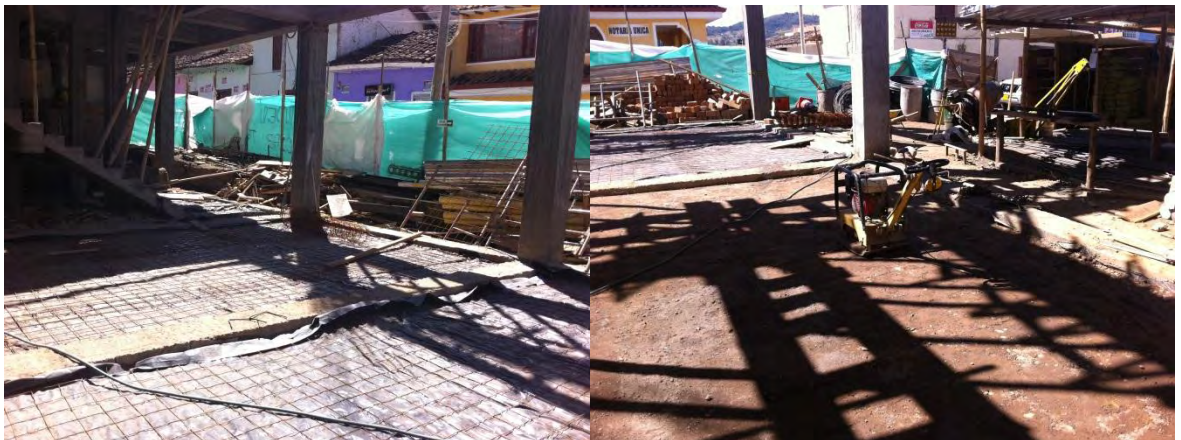
Fotografía 9. Malla electrosoldada de 15x15 en 4mm, para placa de contrapiso y Relleno con material seleccionado al 95% del proctor
