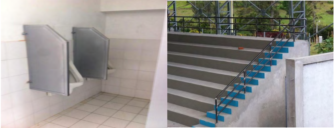
Fotografía 34. Instalación de divisiones metálicas C-20 para baños e instalación de pasamanos metálico en tubo galvanizado 2" tipo pesado.
