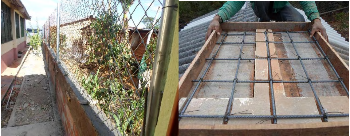
Fotografía 65. Construcción de mesón, instalación lavamanos y orinales en el c.e san pablo bajo y placa para tanque elevado C.E. capulí de minas.
