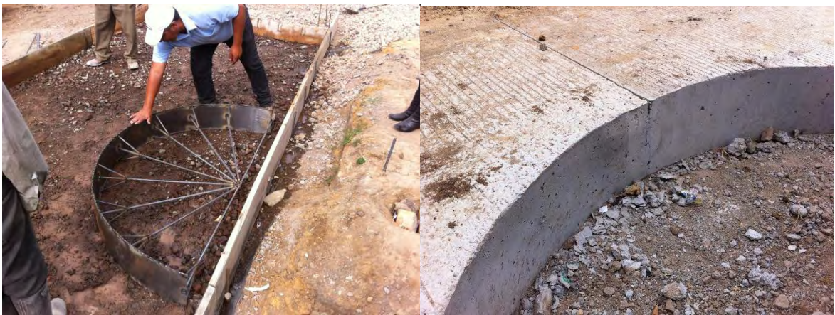
Fotografía 43. Instalación de formaleta metálica para sumidero sencillo en mampostería tipo i y corte y sellado de juntas
