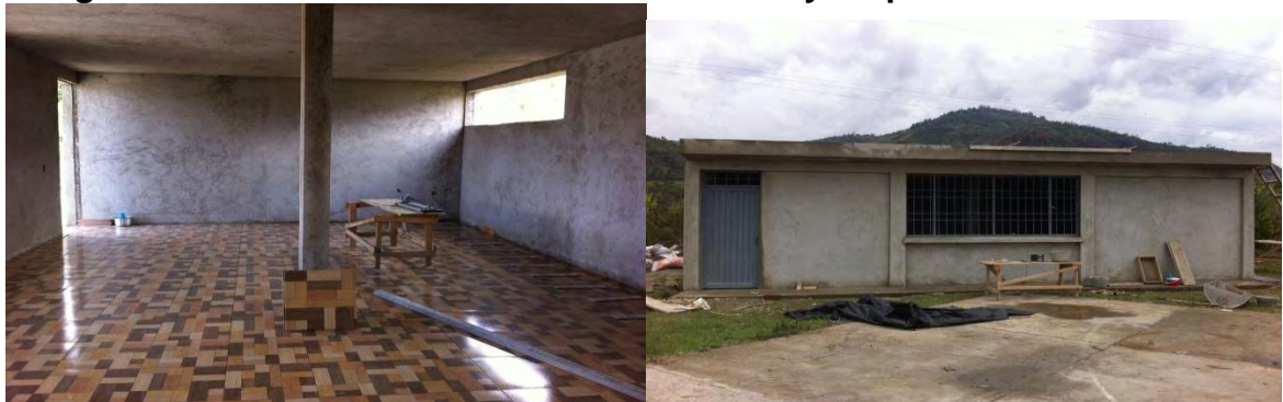
Fotografía 71. Instalación de cerámica tráfico IV y carpintería metálica.
