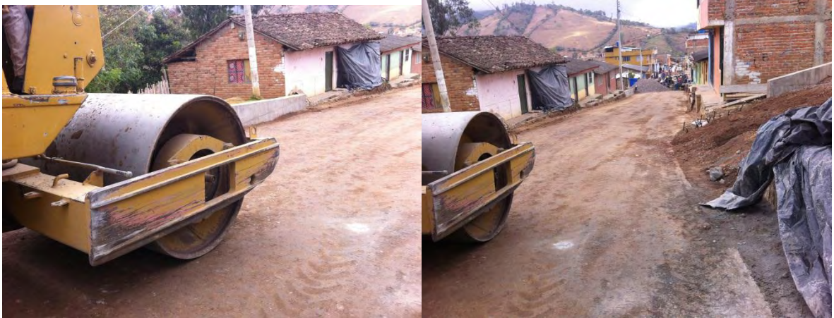
Fotografía 39. Compactación de la base granular con espesor de 15cm sobre la carrera 10ma.
