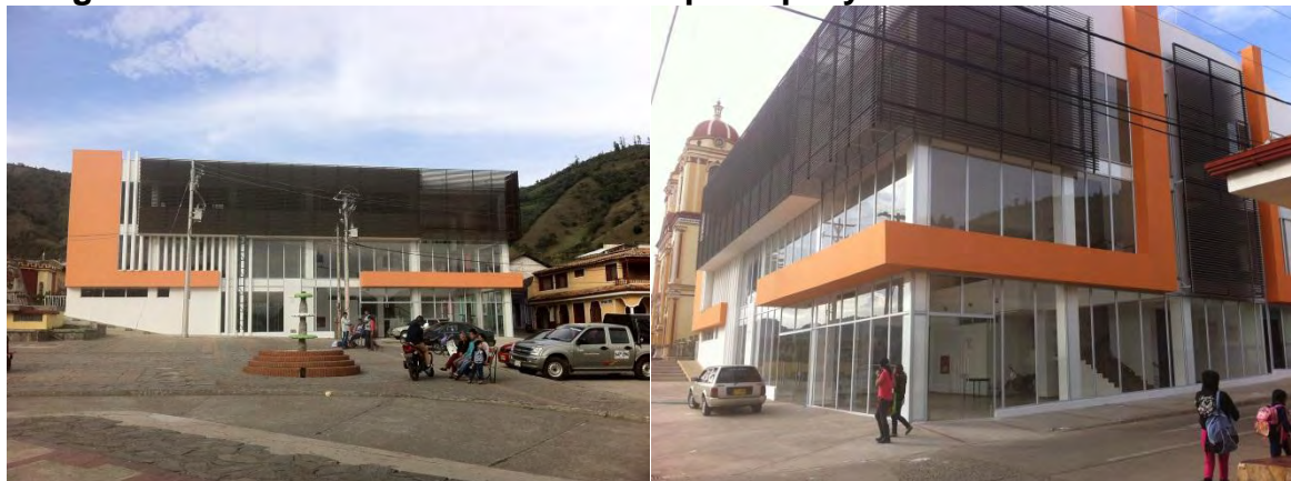
Fotografía 31. Estado final de la fachada principal y lateral.
