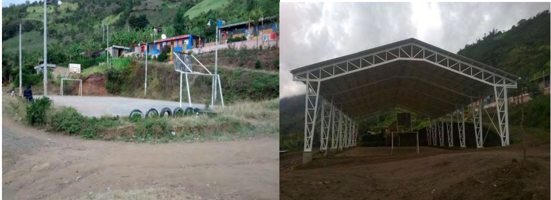
Fotografía 62. Estado anterior y estado actual de la obra.
