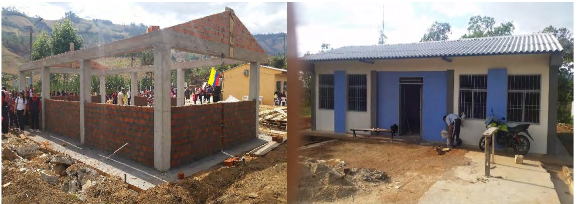
Fotografía 69. Mampostería en salón de actos del C.E. El Tambillo y estado final.
