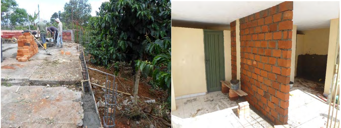
Fotografía 66. Construcción de cerramiento perimetral en el C.E. San José del Cidral y división en mampostería del C.E. La Azogue.
