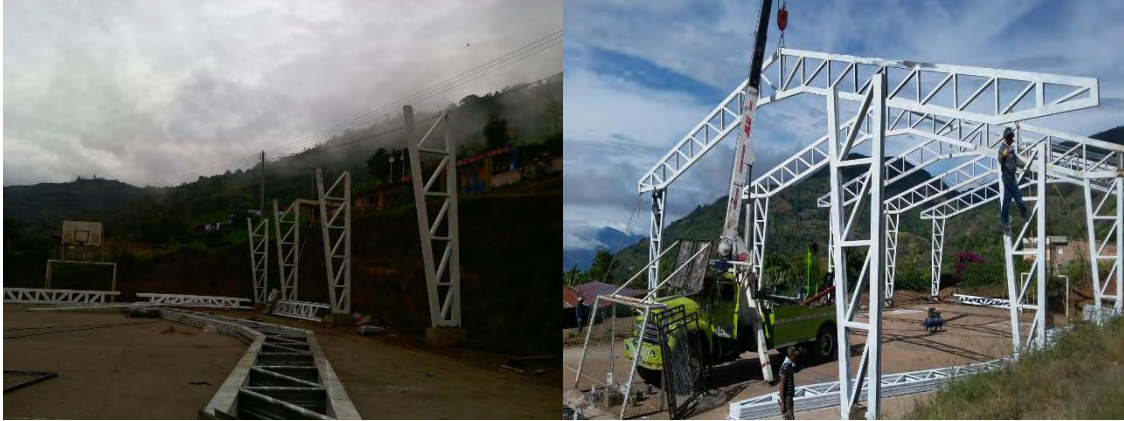
Fotografía 59. Montaje de columnas y cerchas metálicas.
