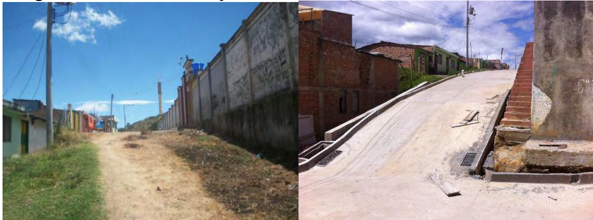
Fotografía 46. Estado inicial y final de la carrera 7.
