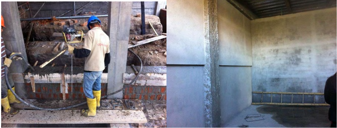
Fotografía 10. Mampostería confinada y repellos sobre muros en primer nivel.
