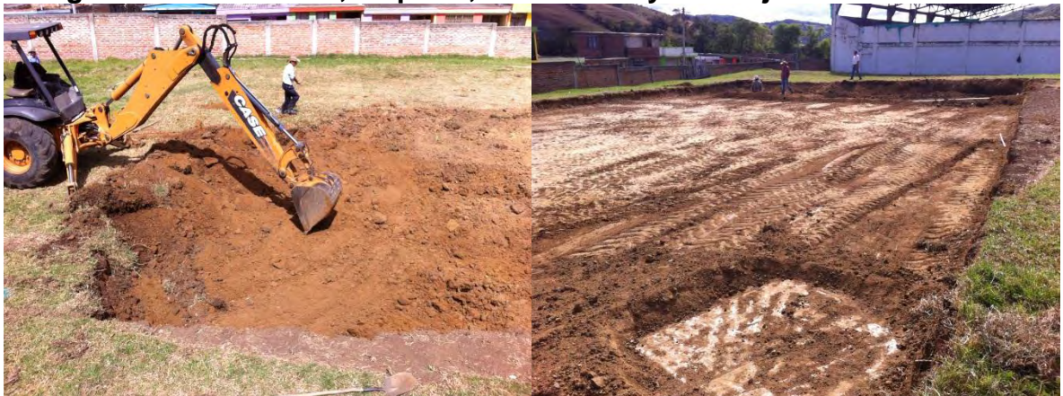
Fotografía 47. Desmonte, limpieza, excavación y desalojo de material.
