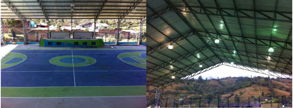
Fotografía 35. Pintura para muros y cancha e instalaciones eléctricas.
