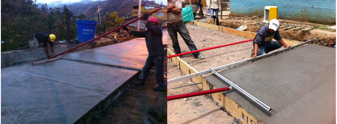
Fotografía 42. Flotado de la placa de concreto y texturizado sobre la carrera 10.
