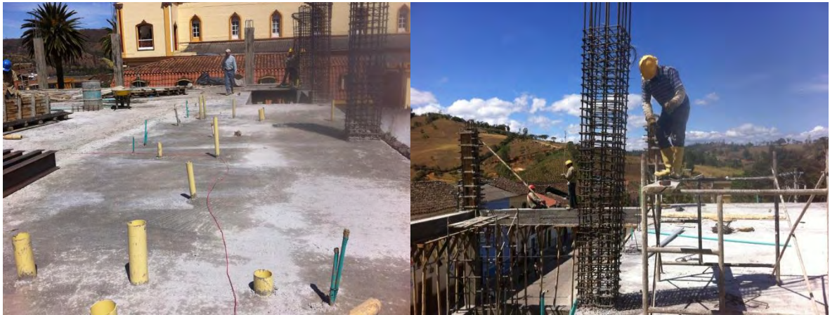
Fotografía 13. Fundición de Losa de entrespiso N+7.40m, instalaciones Hidrosanitarias, y armado de columnas tercer nivel
