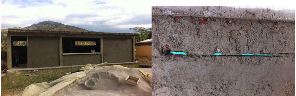
Fotografía 70. Repellos refinados sobre paredes e instalaciones eléctricas.
