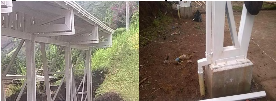
Fotografía 61. Instalación de canal amazonas y bajantes cuadrados de PVC.
