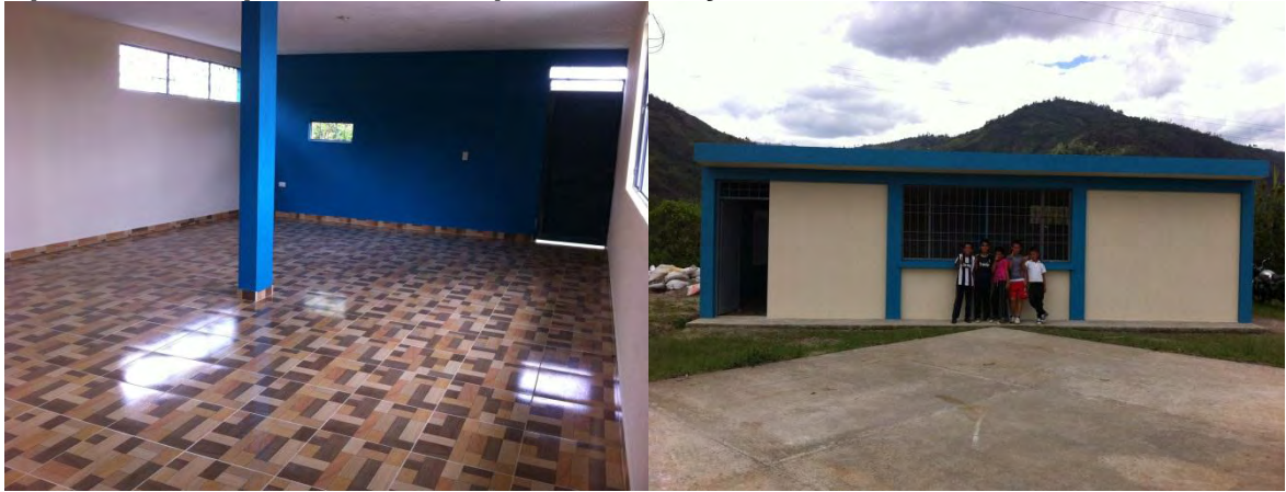
Fotografía 72. Instalación de cerámica tráfico iv y carpintería metálica. Aplicación de pintura vinilo tipo I, interior y exterior.
