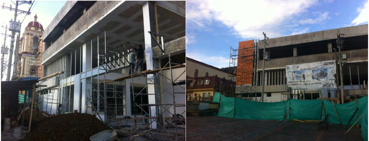
Fotografía 27. Instalación de ventanas en aluminio y fachada en superboard.
