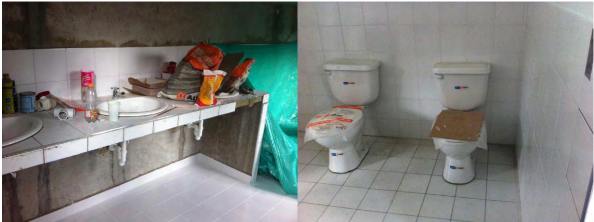
Fotografía 32. Encapes de pisos y paredes e instalación de unidades sanitarias.
