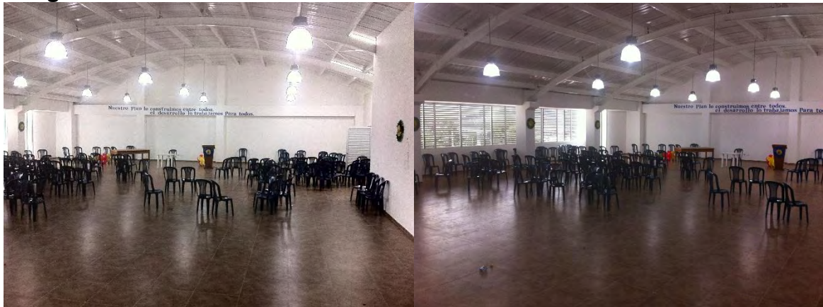
Fotografía 30. Estado final tercer nivel. Auditorio.
