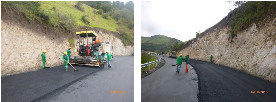
Fotografía 1 y 2. Instalación de carpeta asfáltica. k13+000.
