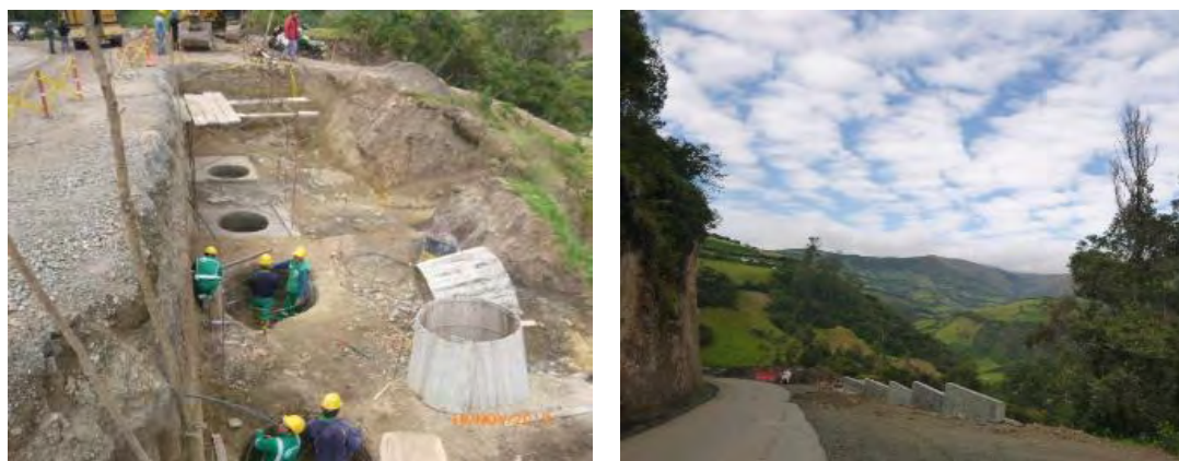
Fotografía 39 y 40. Construcción de muro de contención KM09+050
