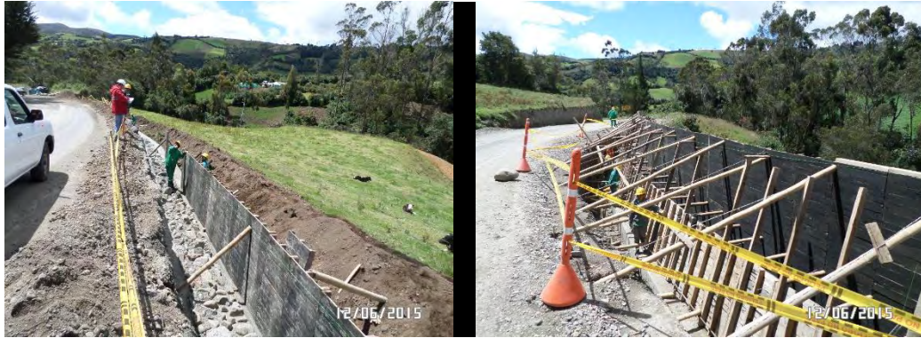
Fotografía 33 y 34. Construcción de muro en concreto ciclopeo, KM28+600.
