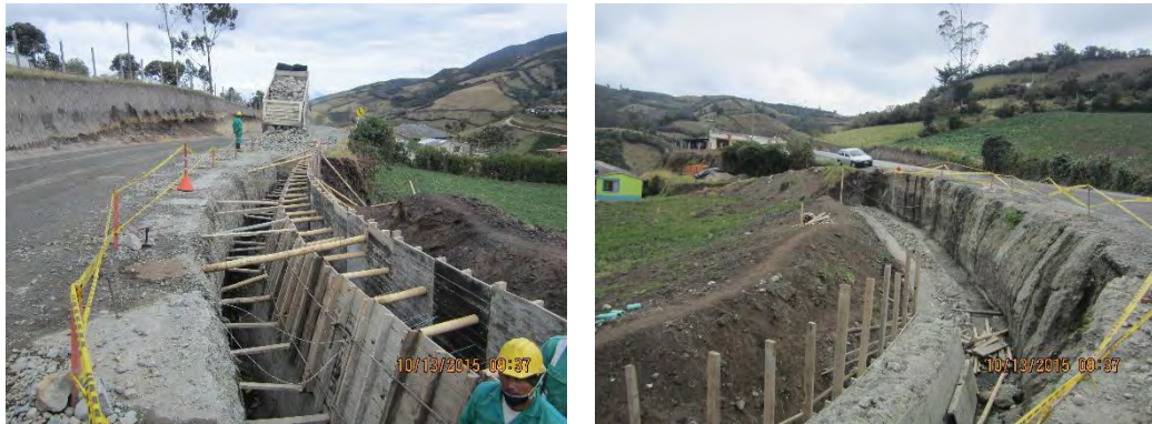
Fotografía 35 y 36. Construcción de muro en concreto ciclopeo, KM28+600.
