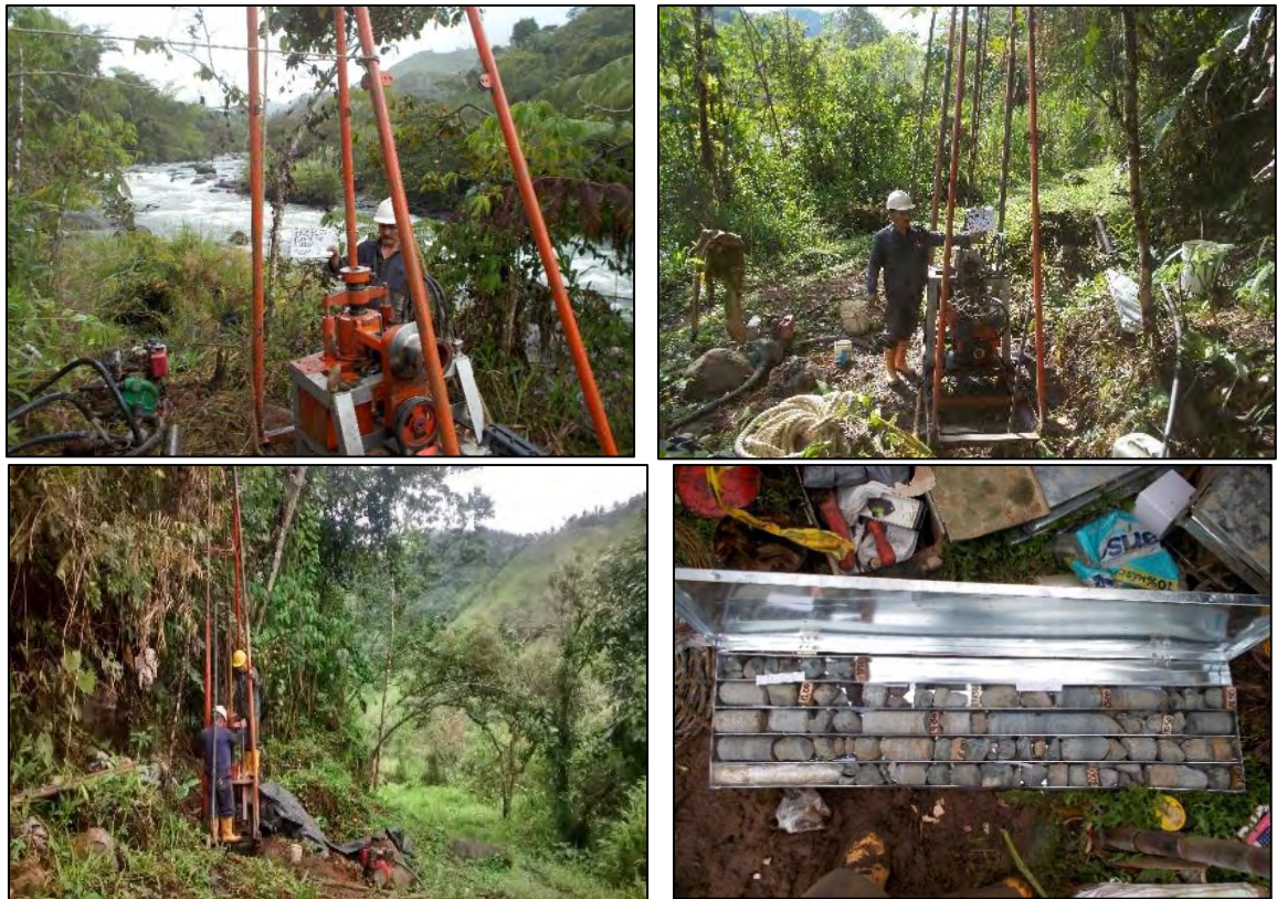
Figura 6. Realización de perforaciones a rotación en sitios de pondeadero.
