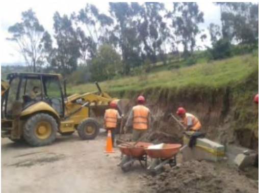
Fotografía 3. Visita de obra N°2
