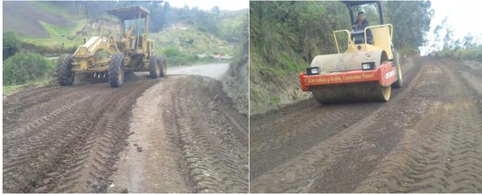
Fotografía 6. Visita de obra N°5
