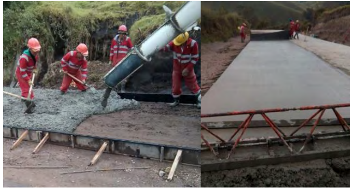
Fotografía 7. Visita de obra N°6
