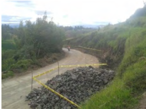
Fotografía 2. Visita de obra N°1
