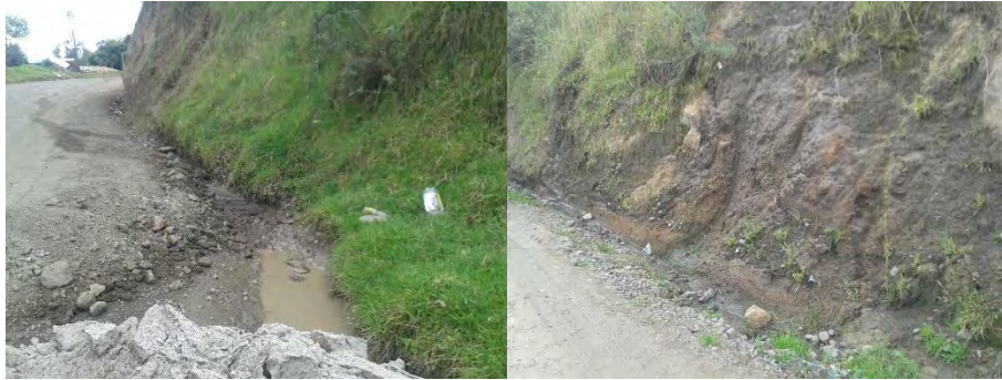
Fotografía 1. Estado Inicial de la obra
