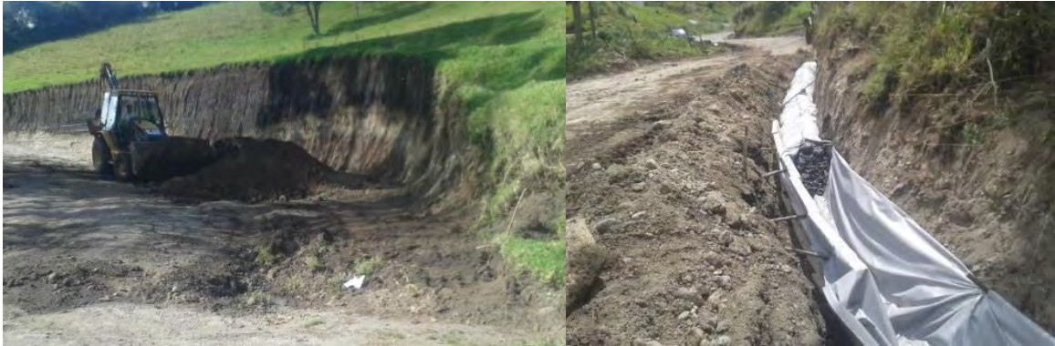
Fotografía 4. Visita de obra N°3
