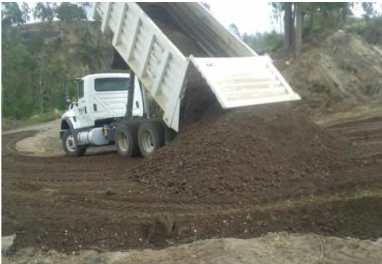
Fotografía 5. Visita de obra N°4
