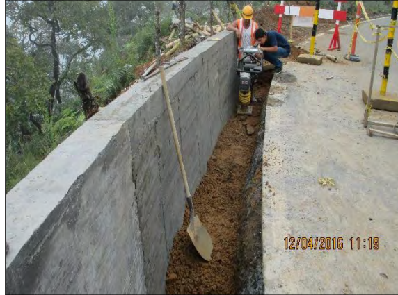
Ilustración 6. Relleno y compactación de muros de contención.
