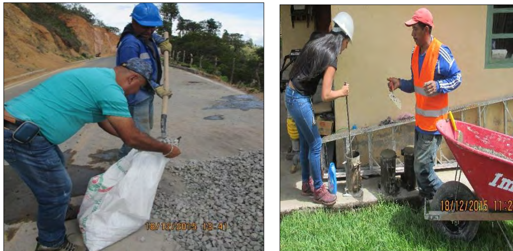
Ilustración 7. Toma de muestras de agregados y mezcla de concreto de muros.
