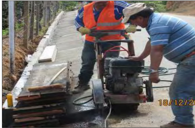
Ilustración 8. Corte de pavimento flexible.
