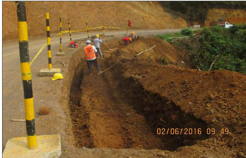
Ilustración 3. Excavación manual para muros.
