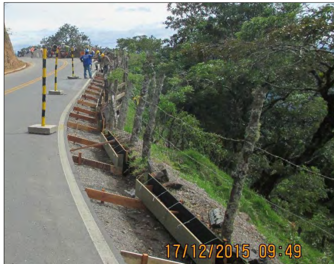
Ilustración 9. Instalación de formaleta para cunetas.
