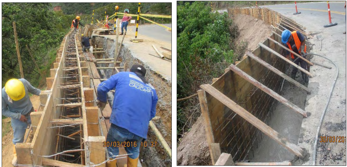
Ilustración 5. Actividades de instalación de formaleta y fundición de zarpa de muros de contención
