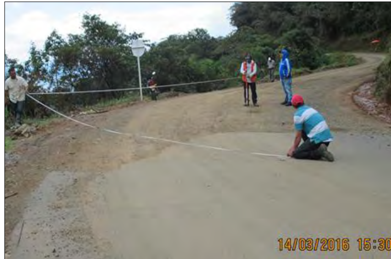
Ilustración 13. Localización de alcantarillas.
