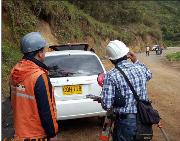
Ilustración 12. Comisión de topografía para actividad de localización y replanteo
