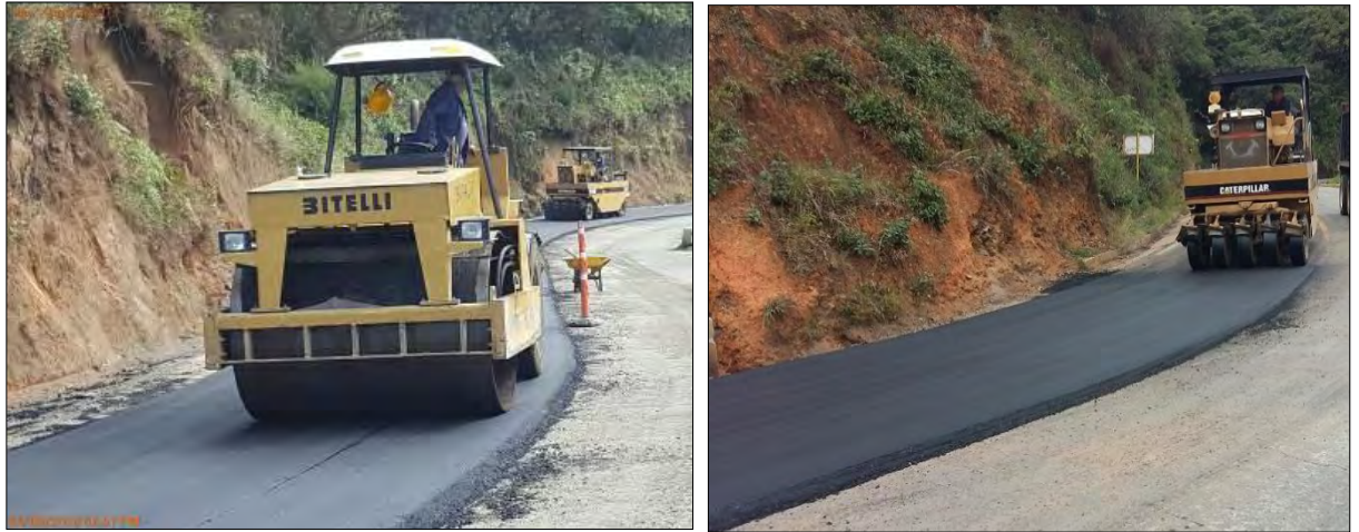
Ilustración 34. Compactación de la carpeta asfáltica con vibro de rodillo liso, y compactador de llantas.
