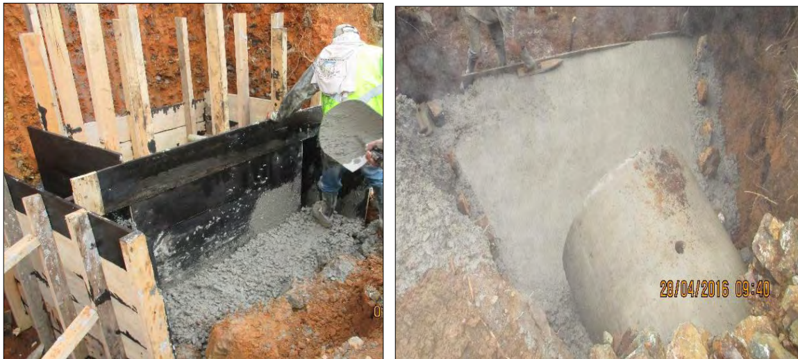
Ilustración 21. Fundición de caja y solera de alcantarillas.
