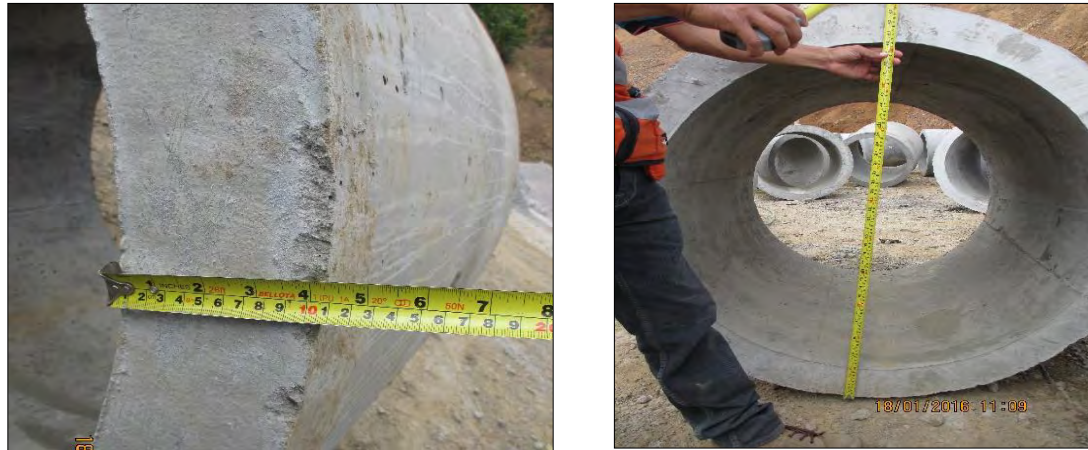
Ilustración 17. Control de espesor y diámetro de tubería en concreto reforzado para alcantarillas.
