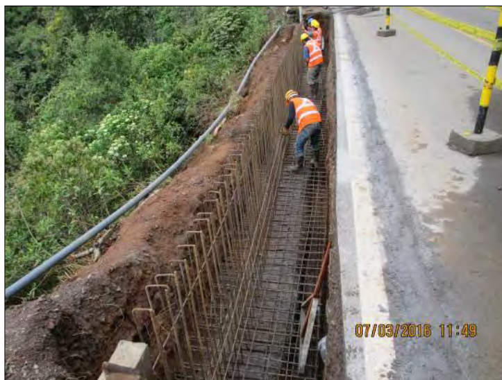
Ilustración 4. Instalación de acero de refuerzo para muros.
