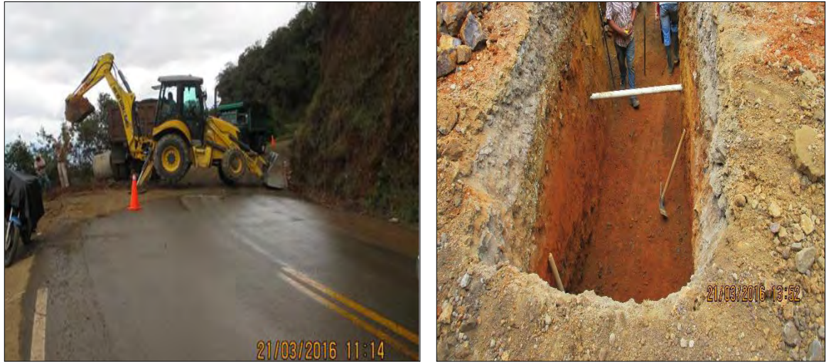
Ilustración 16. Excavación de alcantarillas
