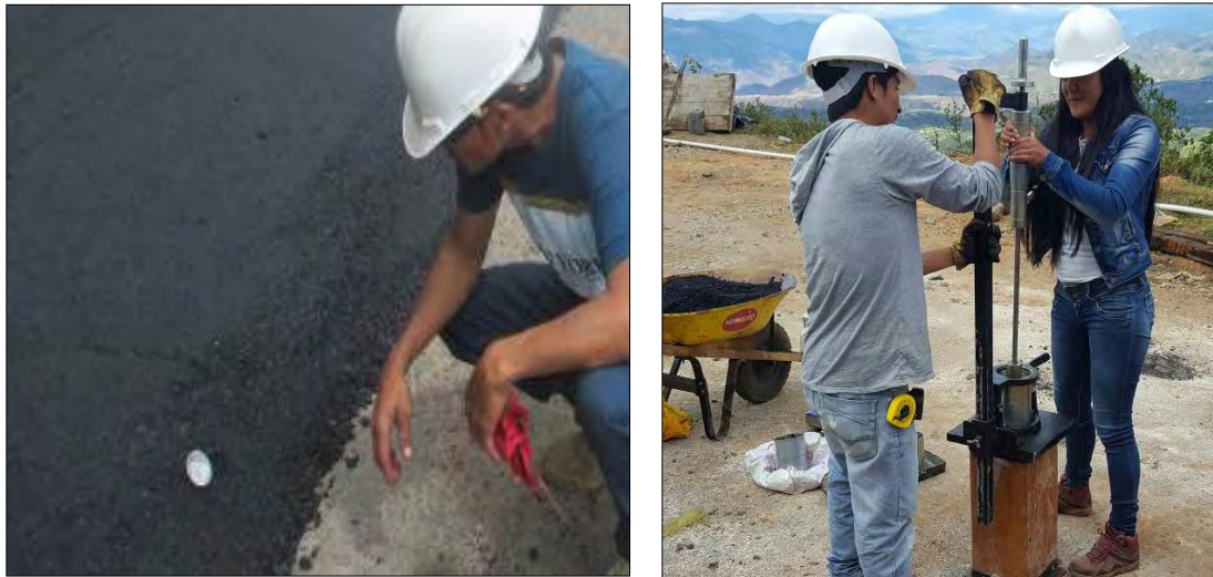
Ilustración 35. Control de temperatura a la mezcla asfáltica y toma de briquetas.
