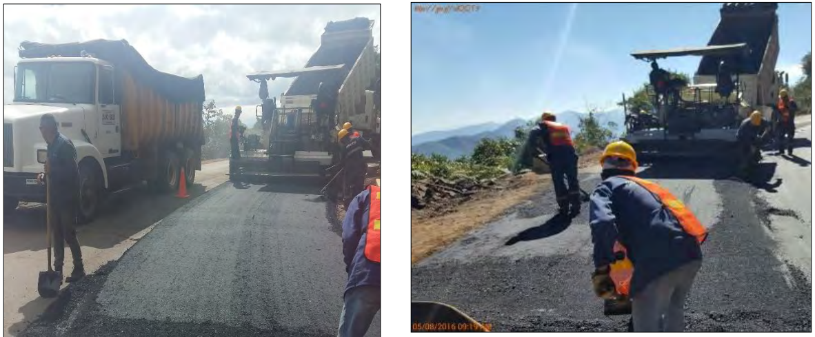
Ilustración 33. Instalación carpeta asfáltica e=10 cm.
