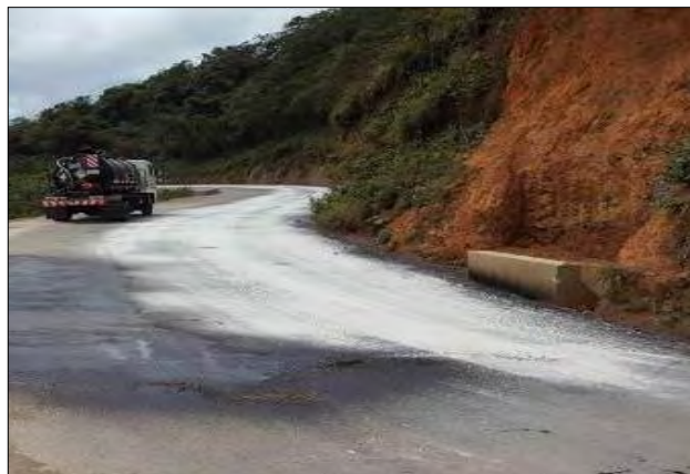
Ilustración 32. Extensión de arena para protección de la imprimación.
