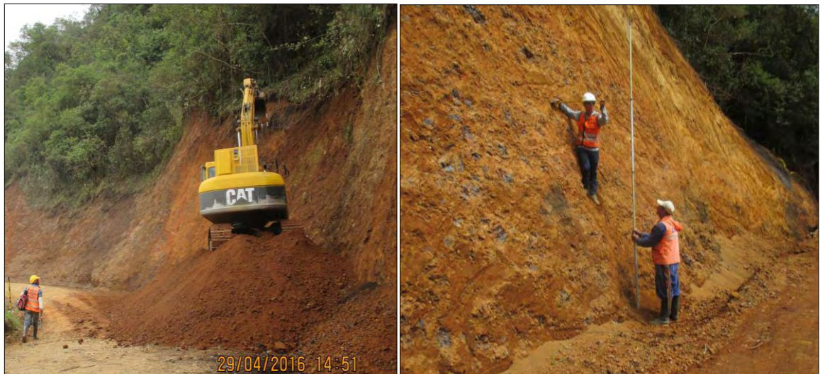
Ilustración 14. Corte y verificación de la inclinación de taludes.
