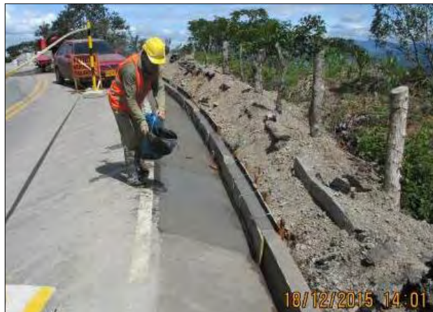
Ilustración 10. Proceso de curado de cunetas.
