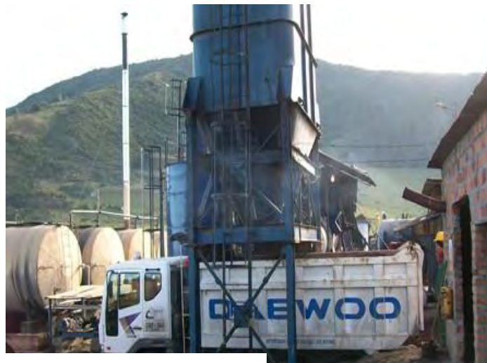
Figura 25. Descargue de Mezcla.
