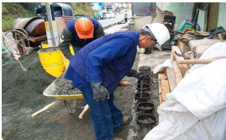
Figura 14. Realización de Ensayos de resistencia al concreto hidráulico utilizado en la fundición de cunetas.
