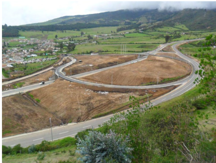
Figura 17. Intersección Aranda K16+600
