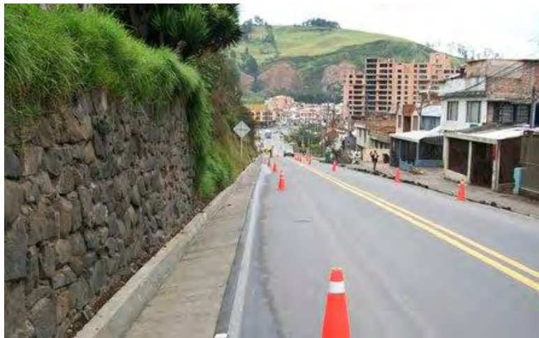
Figura 13. Construcción de cunetas K5+200
