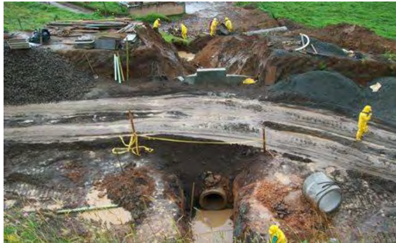
Figura 15. Construcción de alcantarilla K4+760
