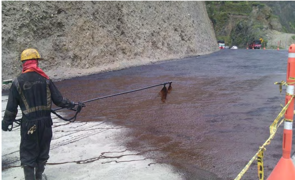
Figura 12. Riego de Imprimación curva K26+600 Trayecto 3 Vía Ipiales – Pasto
