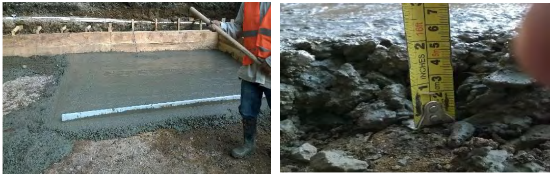
Imagen 1.7 Concreto de limpieza.
