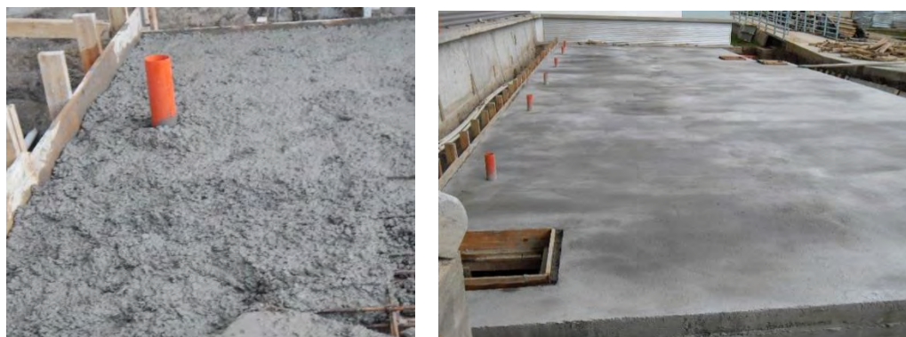
Imagen 1.33 Tubos de aireación.
