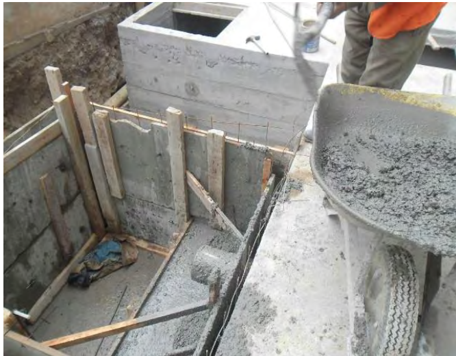
Imagen 1.39 Construcción caja de entrada de agua lluvia.
