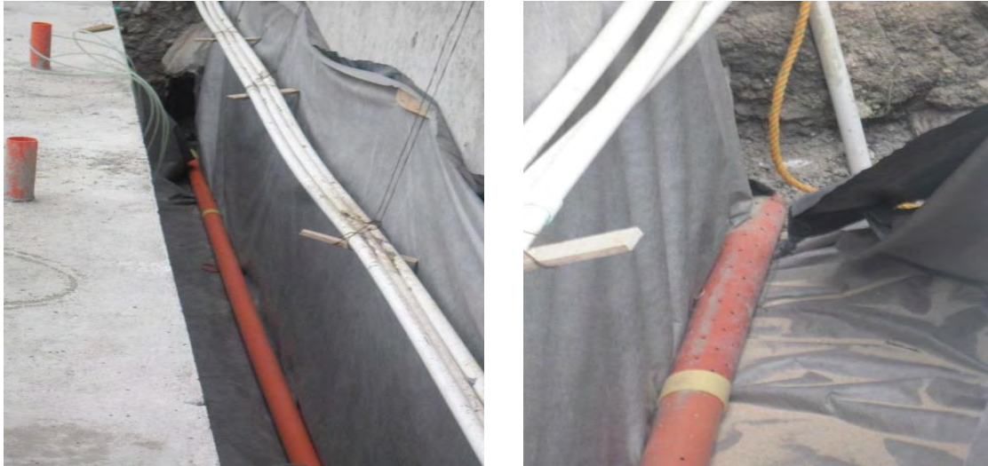
Imagen 1.41 Instalación de filtro.
