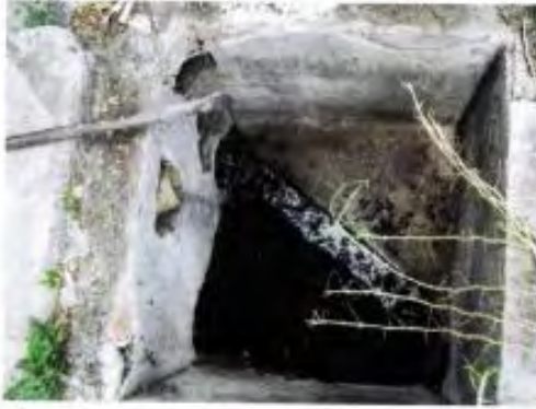
Cámara mixta cubierta con tierra
