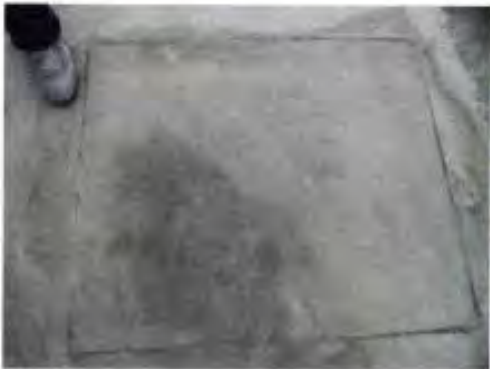
Cámara sellada con mortero
