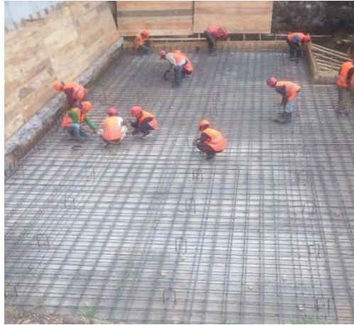
Imagen 1.8 Armado del refuerzo base del tanque.
