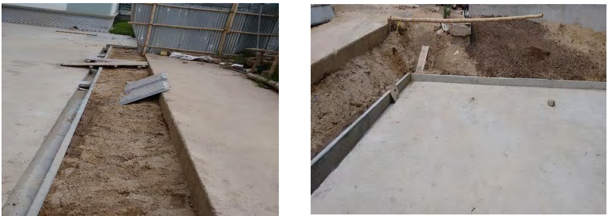
Imagen 1.42 Relleno material de sitio.
