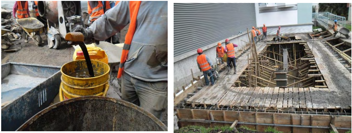
Imagen 1.25 Fundición de muros.
