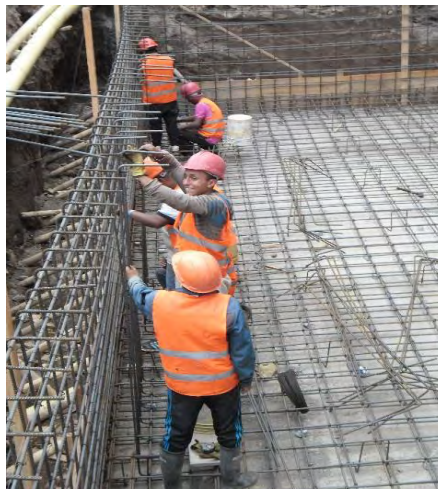
Imagen 1.9 Armado del refuerzo de los muros del tanque.
