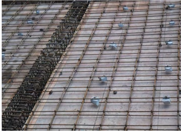
Imagen 1.31 Armado de refuerzo losa superior.
