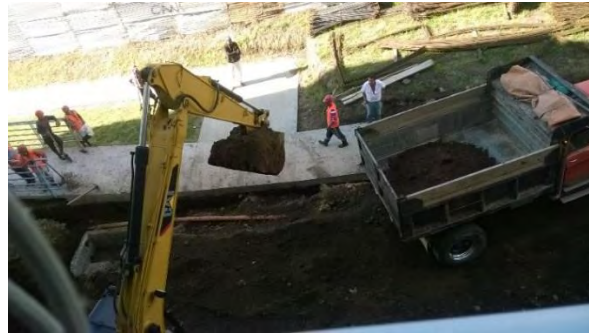
Imagen 1.2 Excavación a máquina.
