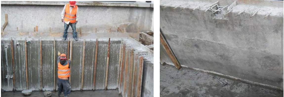
Imagen 1.28 Descimbrado de muros.
