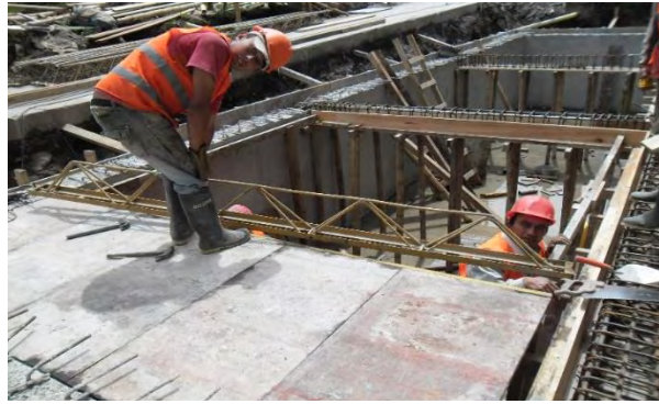
Imagen 1.30 Armado de formaleta losa superior.
