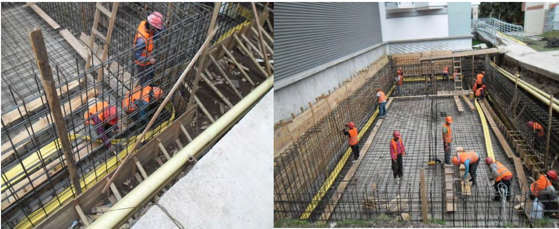
Imagen 1.10 Instalación de la cinta SIKA PVC.
