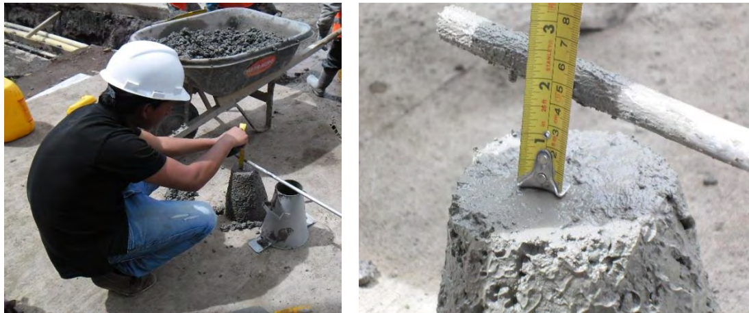
Imagen 1.26 Prueba de asentamiento concreto de muros.
