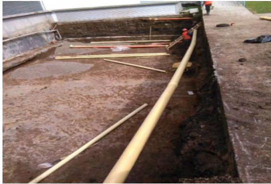
Imagen 1.4 Reubicación de redes hidrosanitarias.
