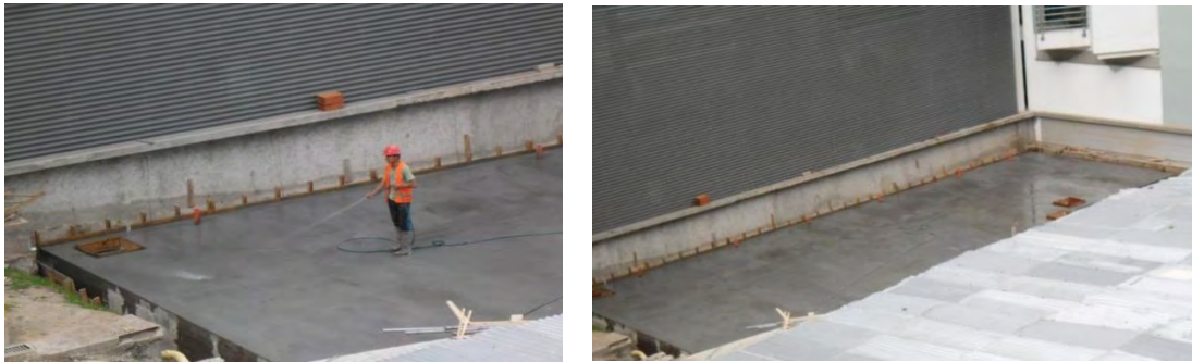
Imagen 1.35 Curado losa superior.
