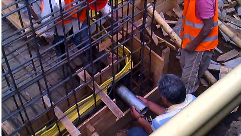
Imagen 1. 11 Instalación de los pases de la tubería de lavado.
