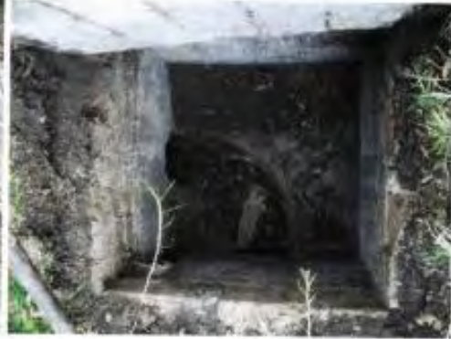
Cámara mixta cubierta con tierra
