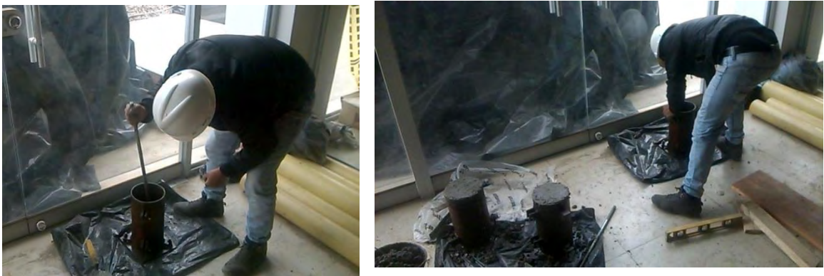
Imagen 1.16 Toma de cilindros concreto base del tanque.
