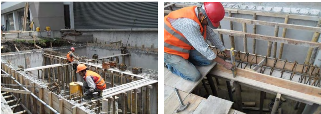
Imagen 1.29 Armado de formaleta y refuerzo de vigas.
