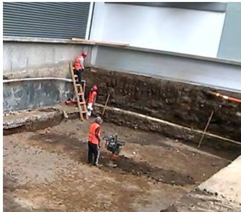
Imagen 1.5 Compactación del terreno de fundación.
