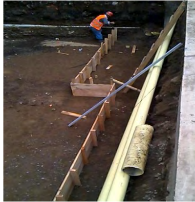
Imagen 1.6 Armado de formaleta de la base del tanque.
