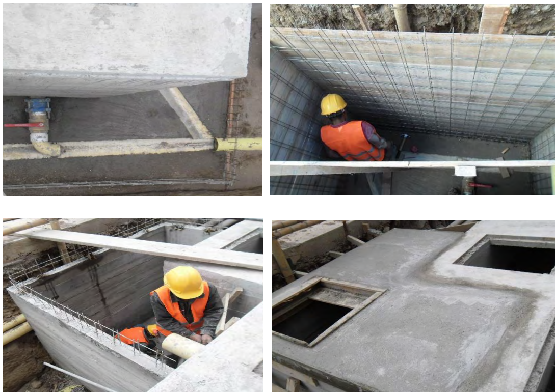
Imagen 1.38 Construcción caja de lavado.
