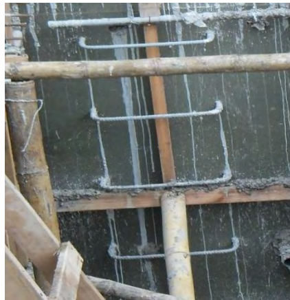
Imagen 1.24 Instalación de escaleras.
