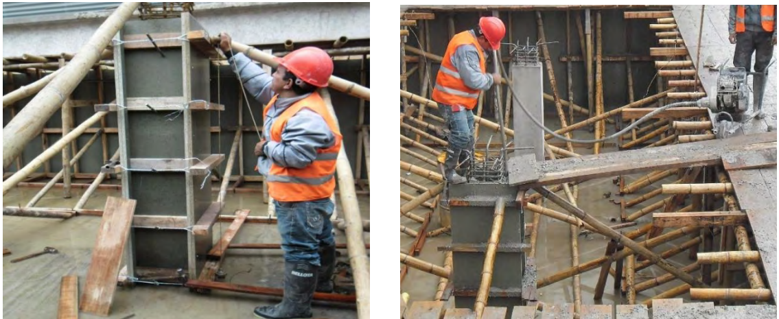
Imagen 1. 19 Armado y fundición de columnas.
