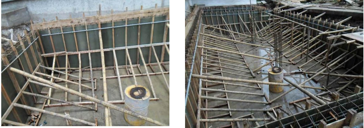
Imagen 1.18 Cimbrado de muros.
