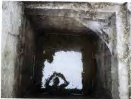
Cámara de aguas negras tapada
