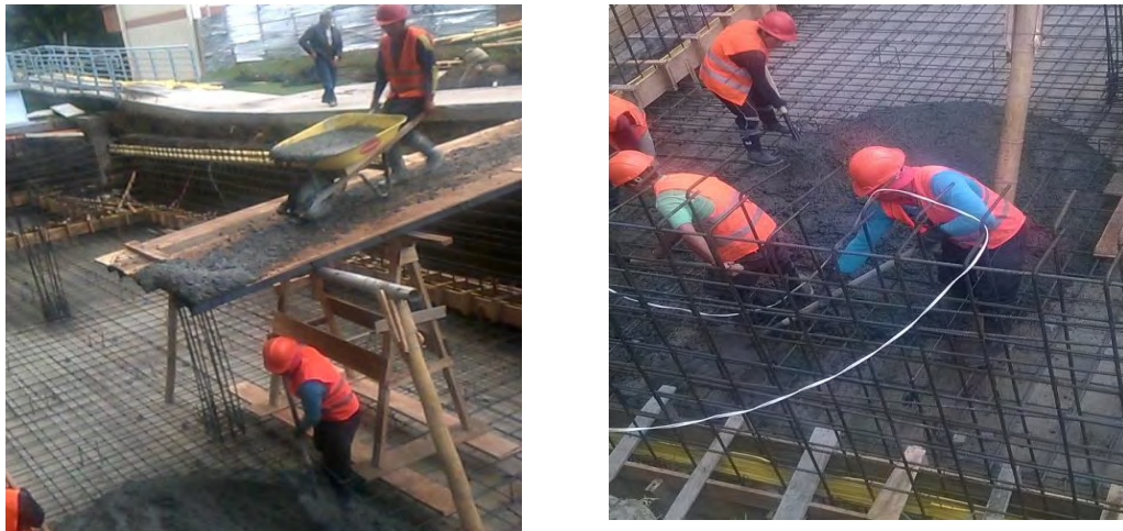
Imagen 1.14 Vaciado y vibrado del concreto.
