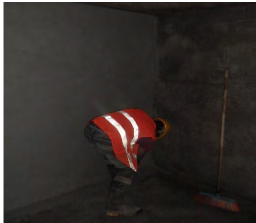
Imagen 1.37 Impermeabilización del tanque.
