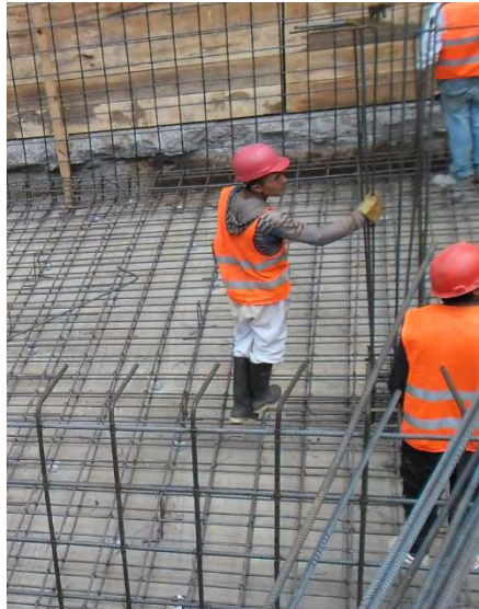
Imagen 1.12 Armado de refuerzo de columnas
