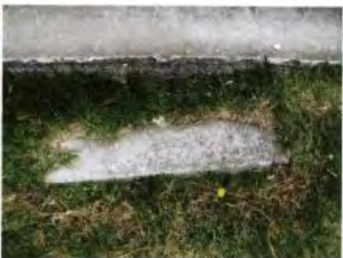
Cámara cubierta por zona verde
