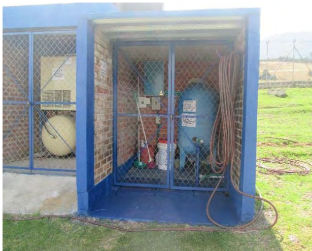
Fotografía 3.6. Caseta de operación
