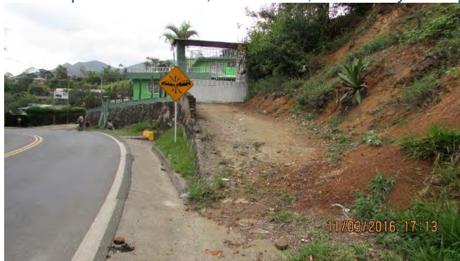
Ilustración 10. Alcantarilla ubicada en K29+310
