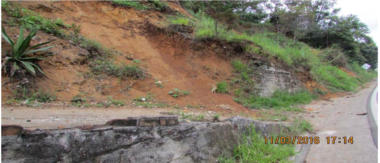
Ilustración 24. Tramo donde se construirá el muro de contención.
