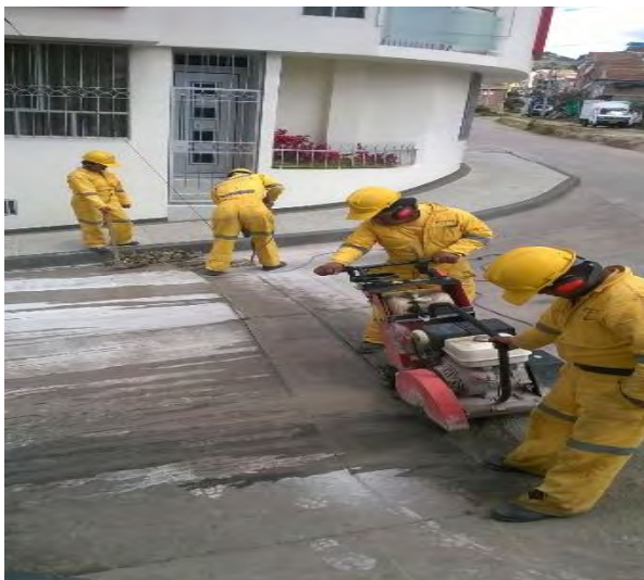
Ilustración 28. Corte de pavimento - cortadora de disco.
