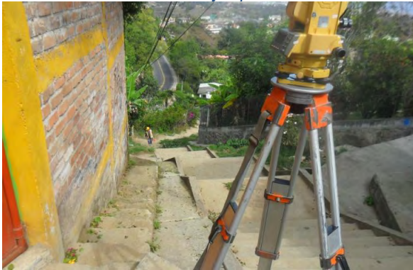
Ilustración 18. Localización y replanteo sector de Gradas
