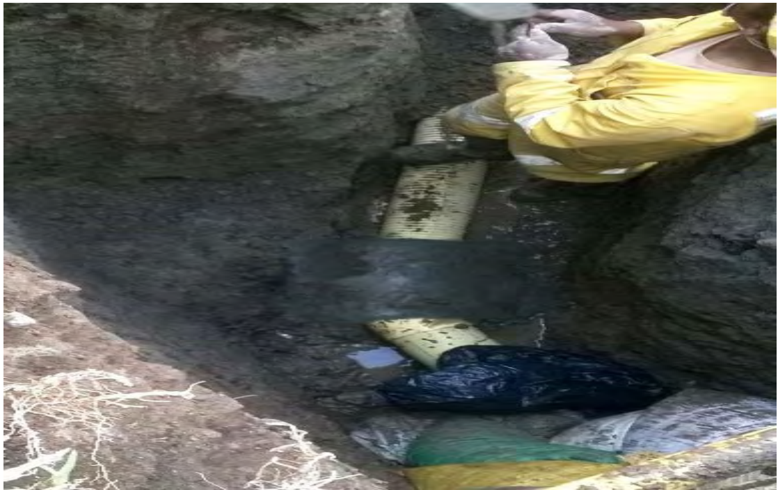
Ilustración 31. Instalación tubería sanitaria estructurada 6"
