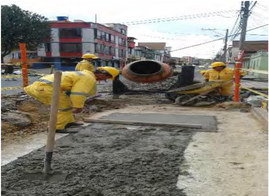
Ilustración 44. Reposición de pavimento rígido.
