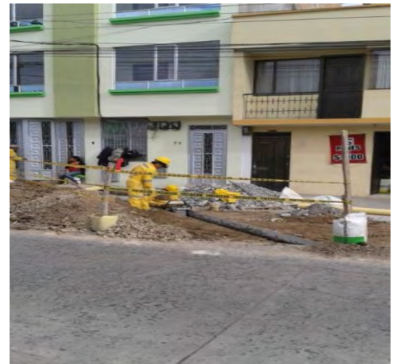
Ilustración 35. Relleno con recebo compactado.
