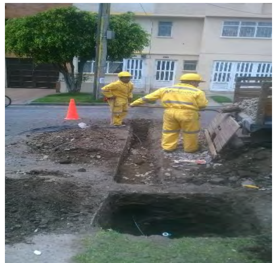
Ilustración 29. Excavación manual acometidas.
