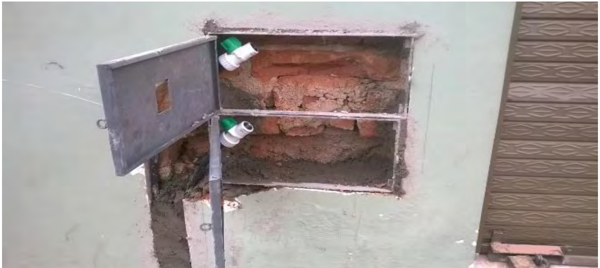
Ilustración 37. Instalación medidores de pared.
