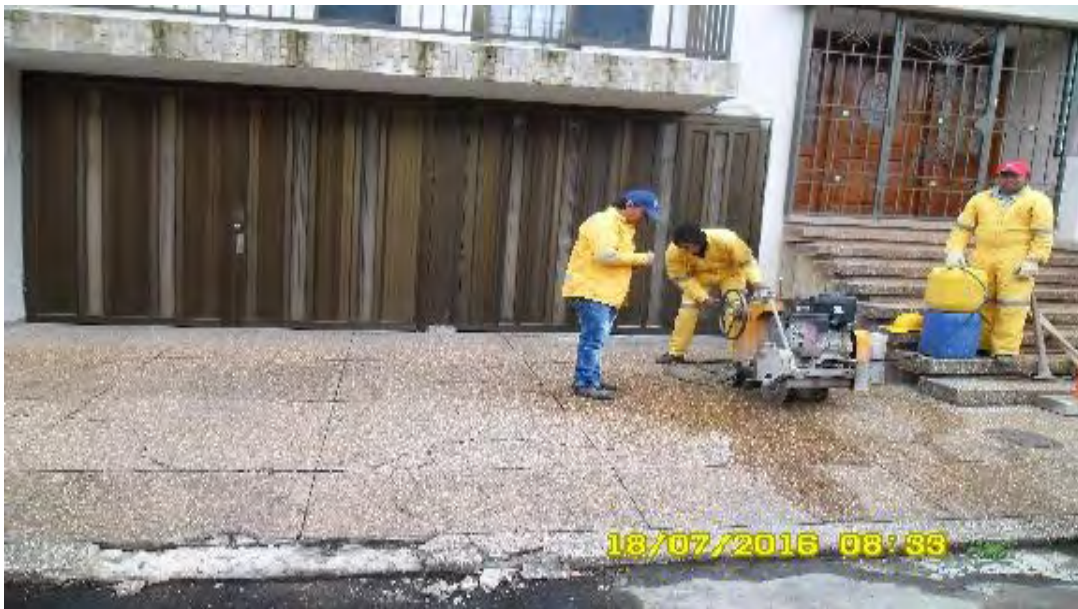
Ilustración 40. Corte tanto en pavimento como en andenes.
