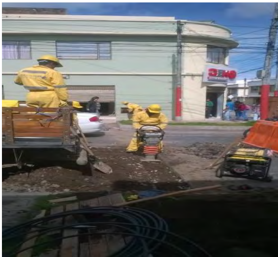
Ilustración 34. Compactación de base.
