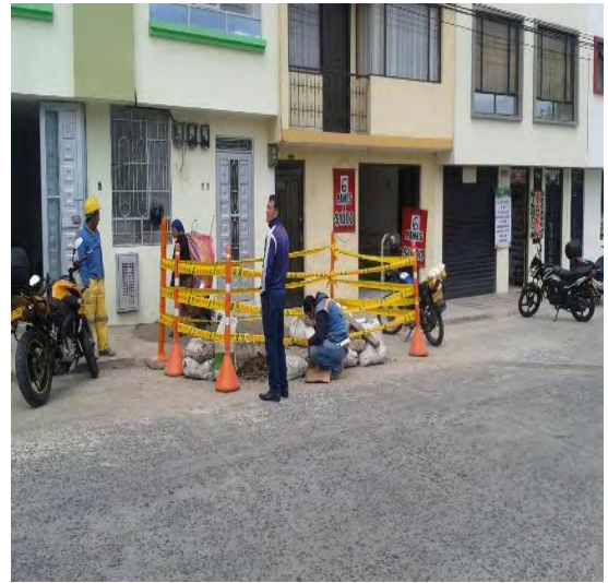
Ilustración 27. Señalización contrato acometidas
