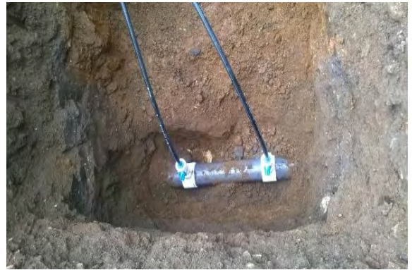
Ilustración 33. Instalación de tubería PF+UAD.
