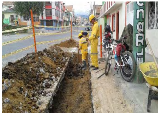
Ilustración 42. Excavación en material común.
