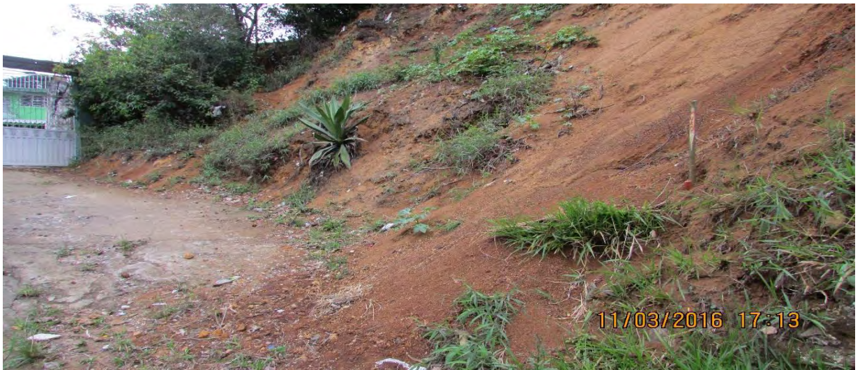
Ilustración 25. Talud para el cual se construirá muro.
