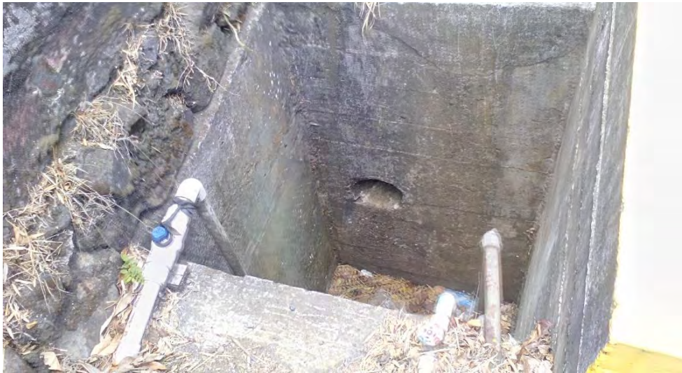
Ilustración 8. Alcantarilla D=24" sobre la vía Panamericana
