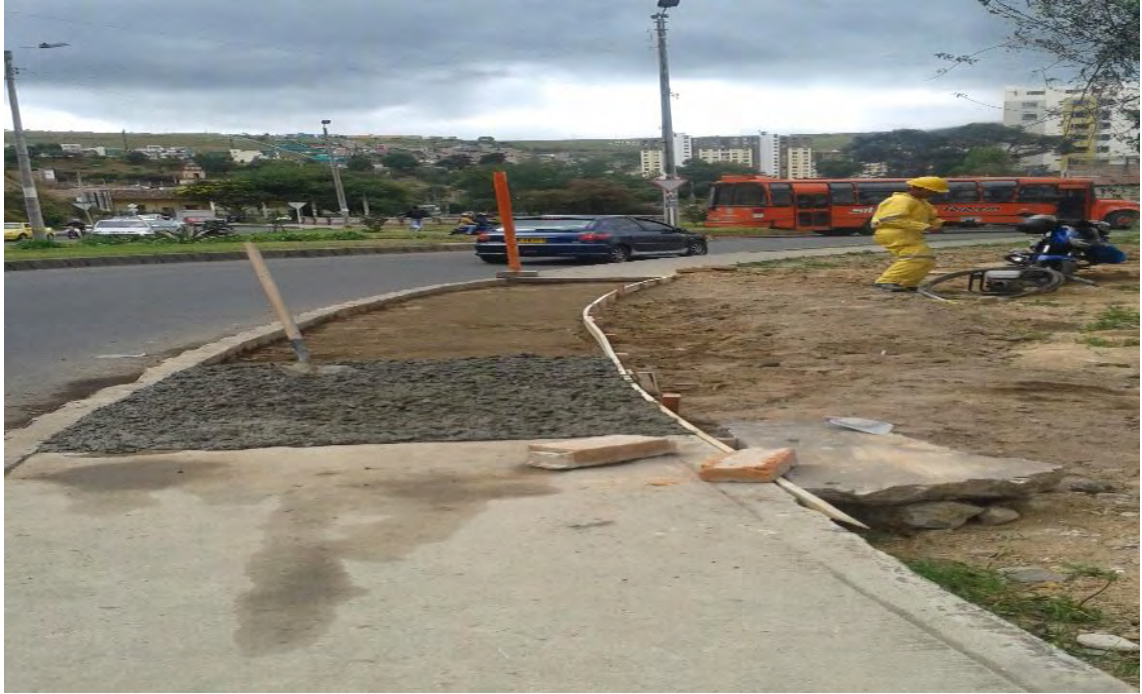
Ilustración 45. Reposición de andenes en concreto.
