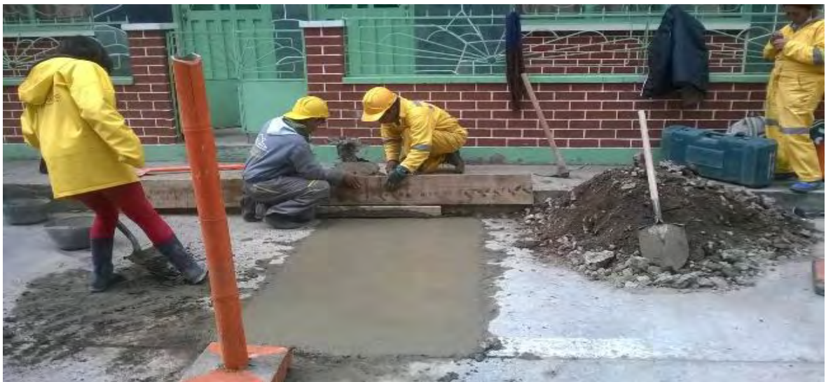
Ilustración 36. Reposición de pavimento rígido.
