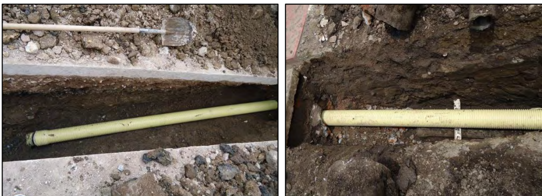
Figura 26. Instalación de tubería estructurada PVC d=6"
