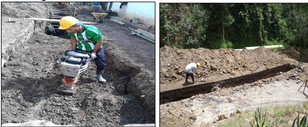
Figura 15. Relleno con material seleccionado de la excavación.
