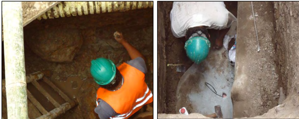
Figura 5. Excavación en roca
