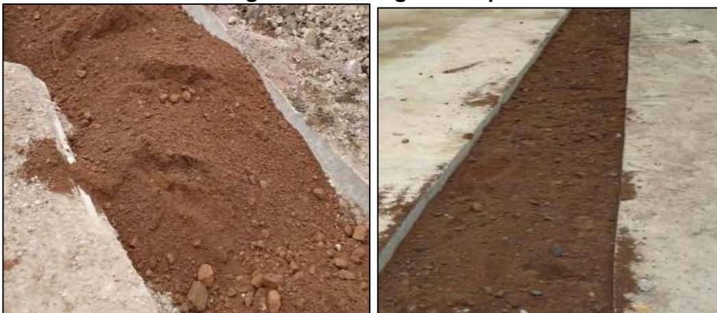
Figura 17. Base granular para vías
