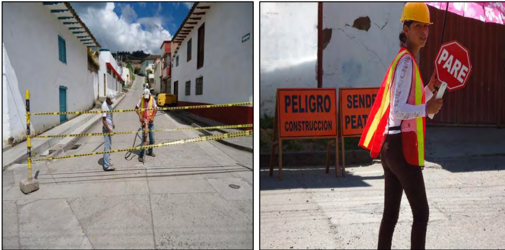
Figura 7. Barrera preventiva de seguridad
