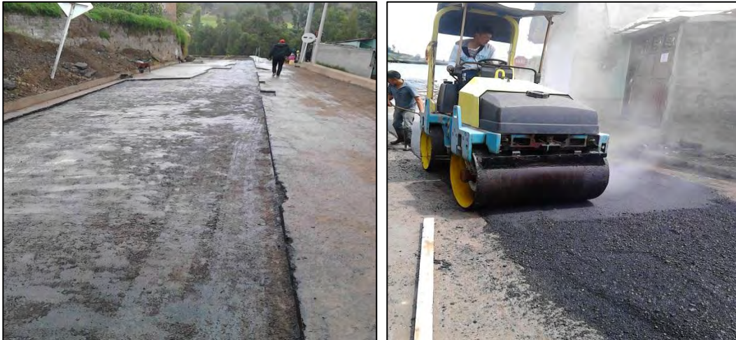
Figura 10. Mezcla asfáltica para parcheo tipo INVIAS
