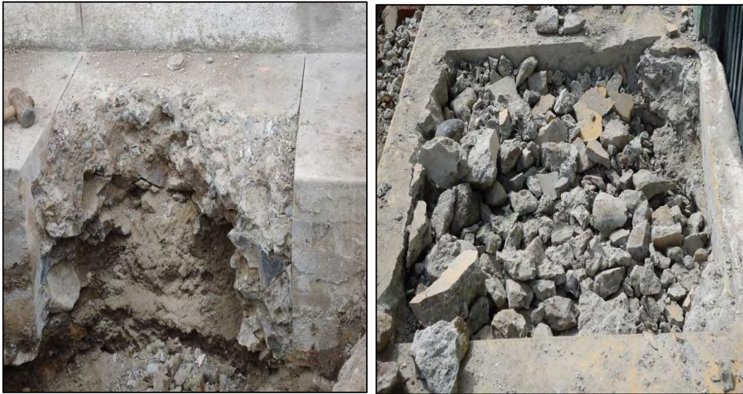
Figura 9. Demolición de estructuras en concreto
