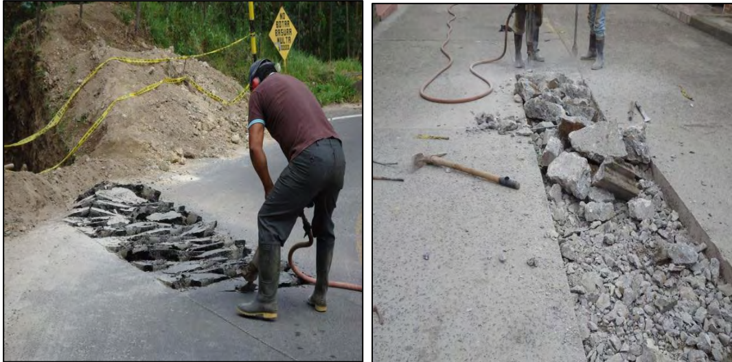
Figura 11. Demolición de pavimento asfáltico y/o concreto
