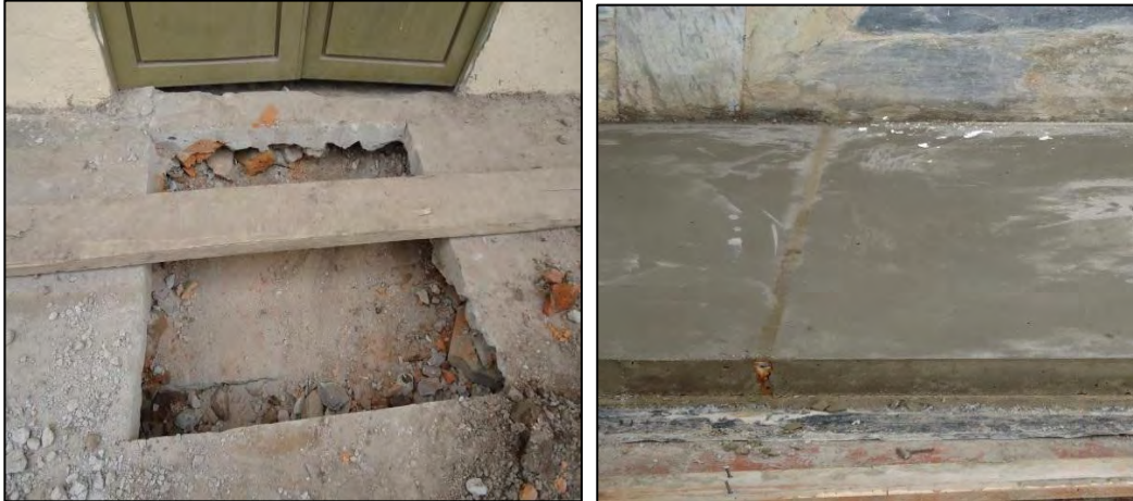
Figura 9. Reposición de andenes en concreto
