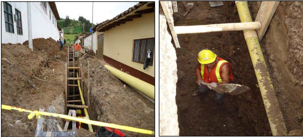
Figura 14. Excavación en material conglomerado h= 2 a 3 m con entibado
