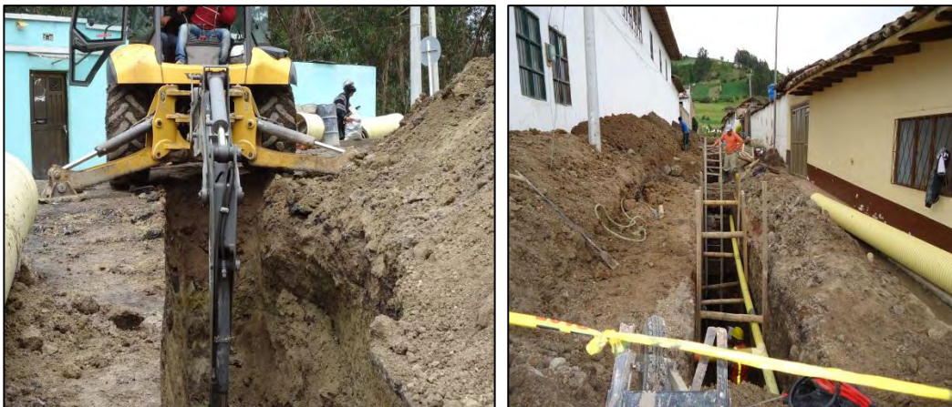
Figura 3. Excavación en material conglomerado h= 3 a 4 m con entibado
