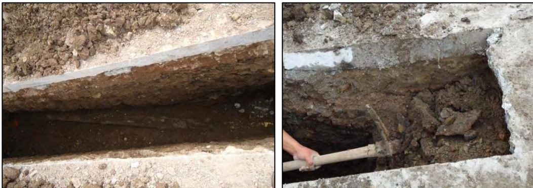
Figura 13. Excavación en material conglomerado h<2 m
