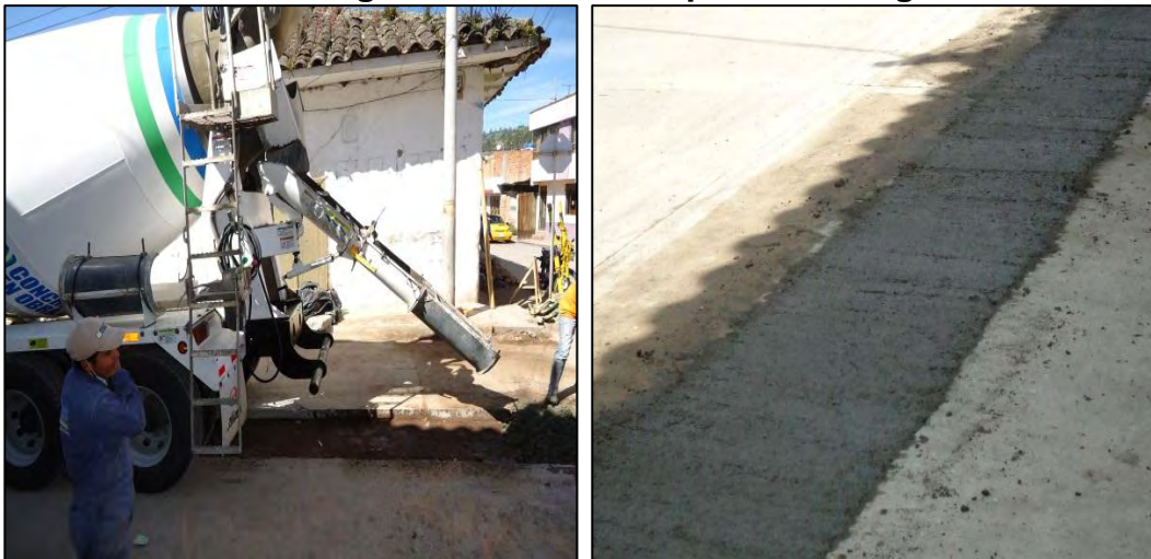
Figura 11. Bacheo de pavimento rígido
