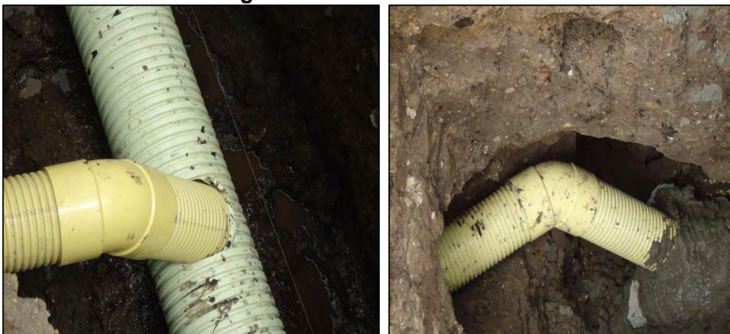
Figura 8. Instalación codo sanitario.
