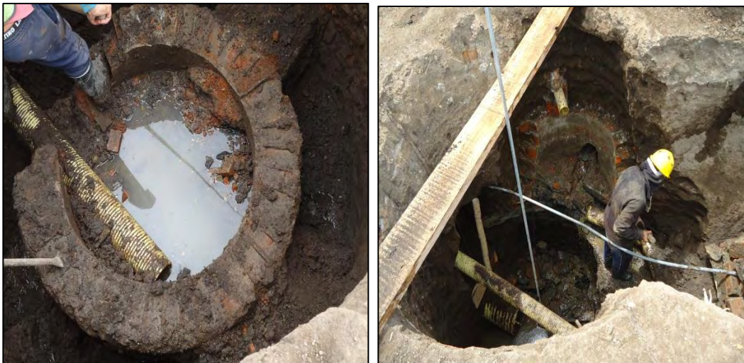
Figura 8. Demolición de estructuras en mampostería
