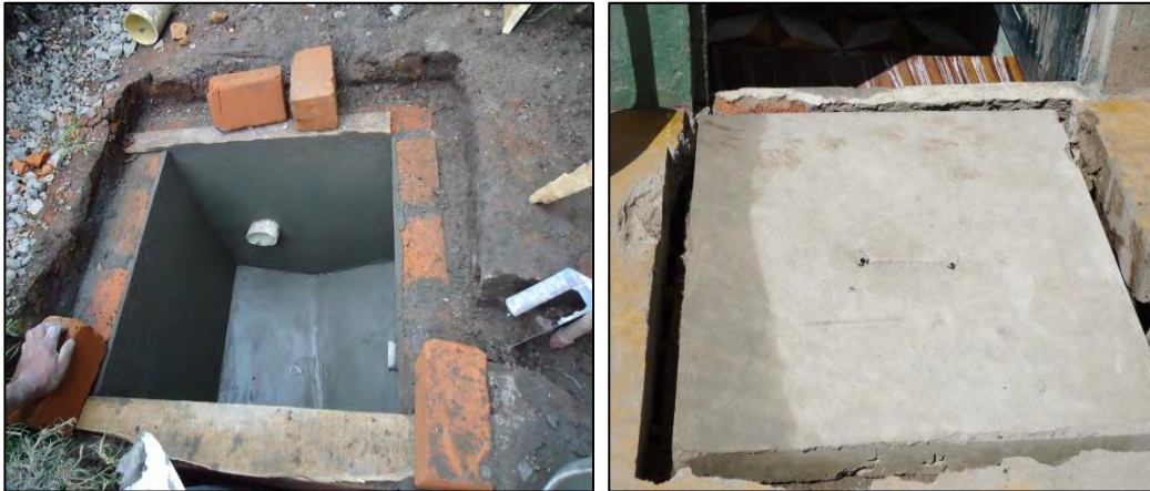
Figura 25. Construcción caja domiciliaria
