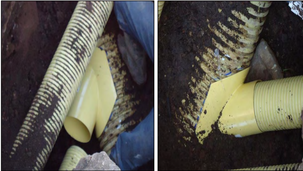
Figura 7. Instalación de sillas yee estructuradas
