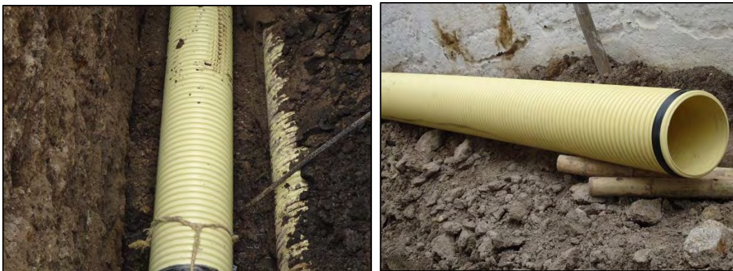
Figura 6. Instalación de tubería.
