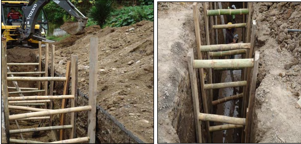
Figura 4. Excavación en material conglomerado h= 4 a 5 m con entibado
