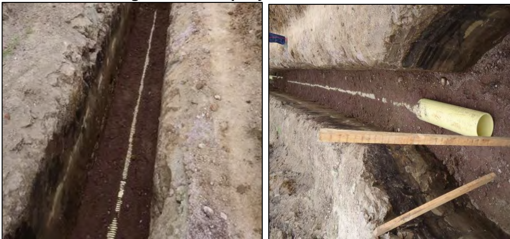
Figura 14. Atraque y recubrimiento de tubería.
