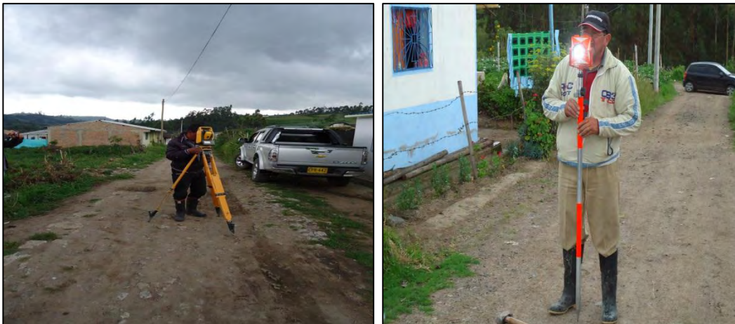
Figura 6. Localización y replanteo
