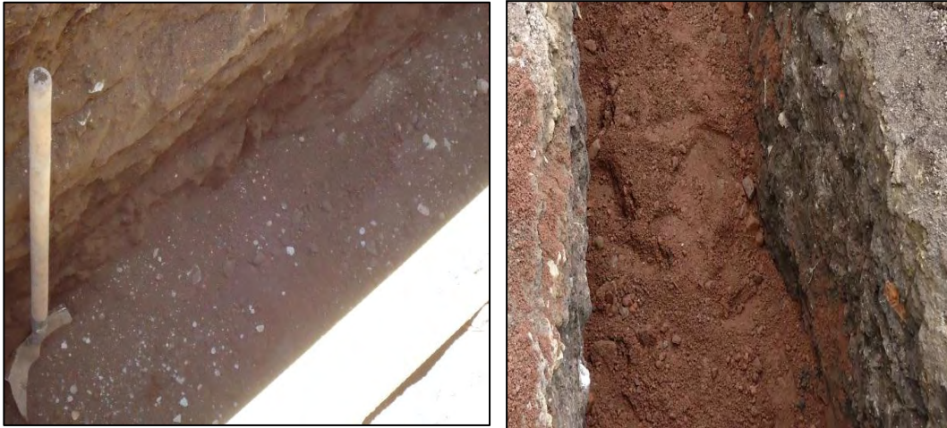
Figura 13. Solado con recebo simple.
