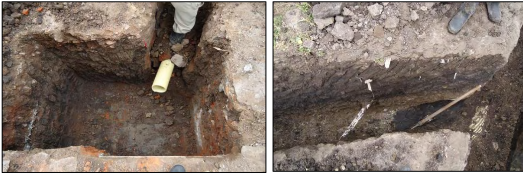
Figura 12. Excavación en material común h<2 m.
