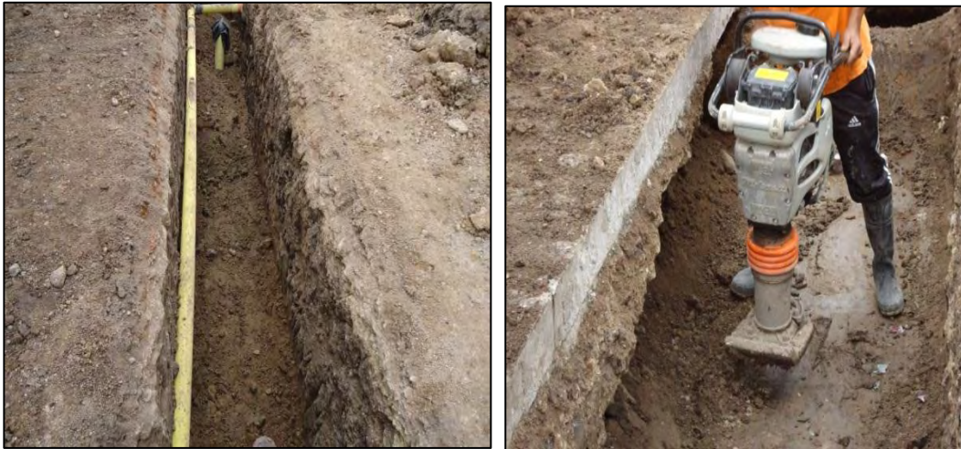
Figura 16. Relleno con material granular seleccionado para reposición.
