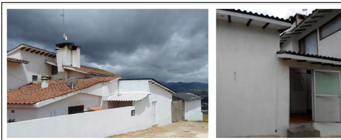
Figura 1. Instalaciones de la empresa “FRIGOR”
