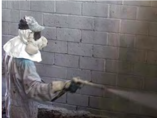
Figura 8. Desinfección de paredes con hidróxido de cal
