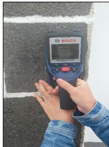
H. Ensayo SCANNER En columna exterior Iglesia San Pedro
