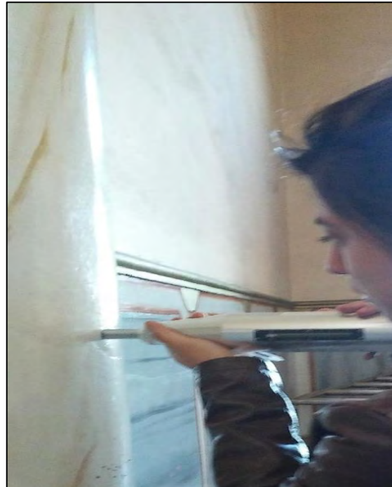
B. Toma de esclerometría columna interior Iglesia San Pedro.
