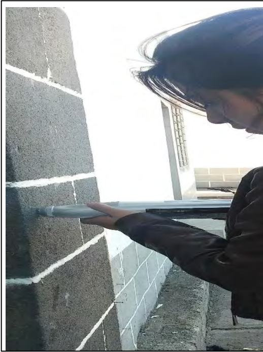
A. Toma de esclerometría columna exterior Iglesia San Pedro.
