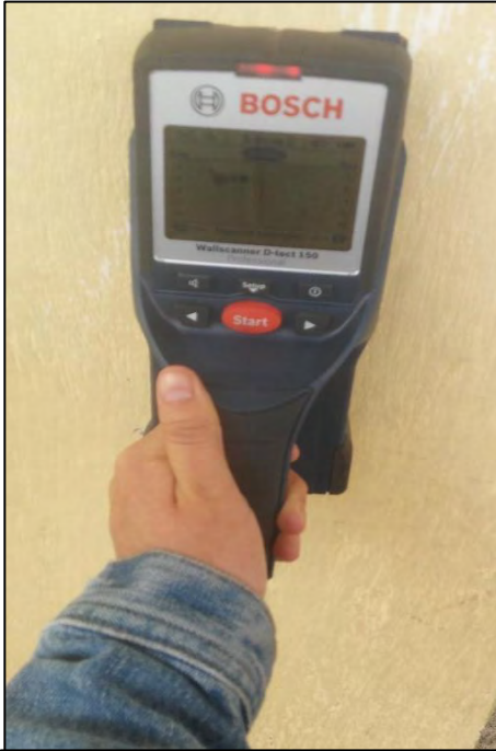
E. Ensayo SCANNER En columna interior I.E. JOSÉ ANTONIO LLORENTE
