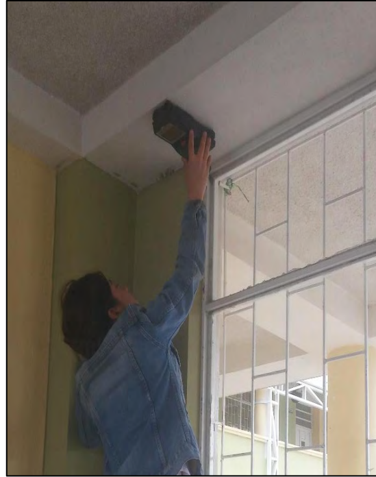
F.. Ensayo SCANNER En viga interior I.E. JOSÉ ANTONIO LLORENTE
