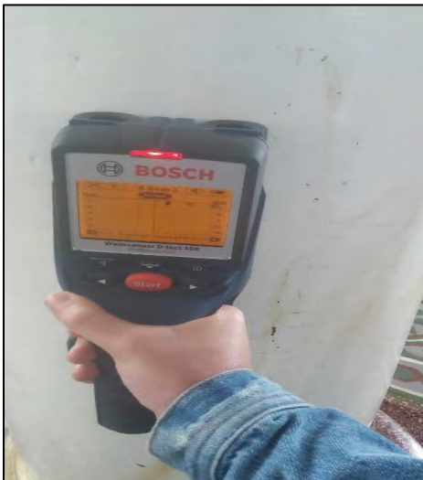
G. Ensayo SCANNER En columna interior Iglesia San Pedro
