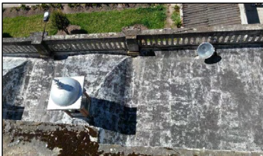
Figura 21. Vista exterior de losa Iglesia.
