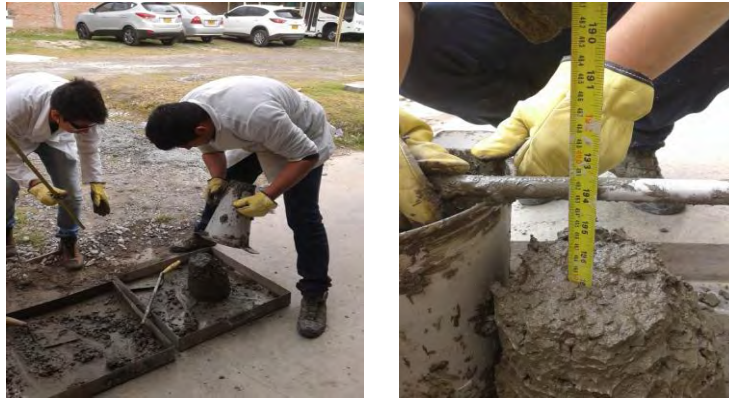
Imagen 34. Levantamiento del cono y medición del asentamiento.
