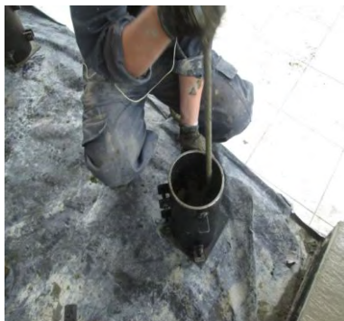
Imagen 38. Compactación de mezcla con varilla.
