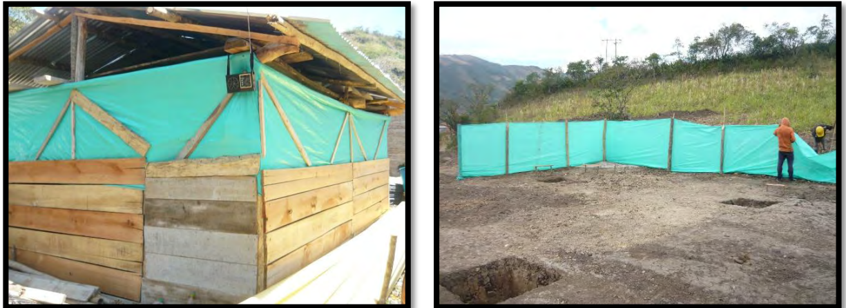
Figura 4. Campamento y cerramiento.
