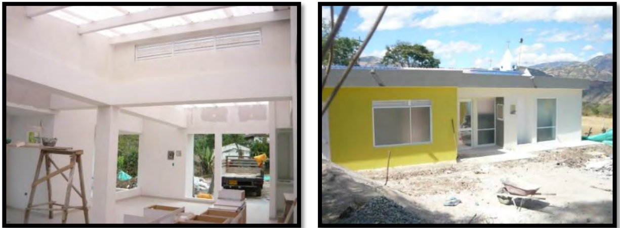
Figura 30. Estuco y pintura.
