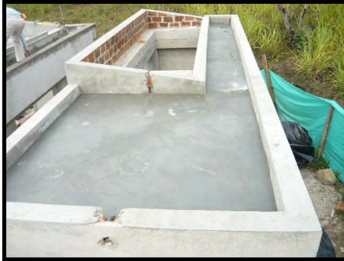
Figura 24. Losa para tanque de abastecimiento.
