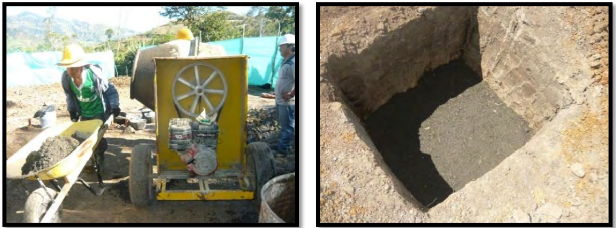
Figura 6. Mejoramiento de suelo.
