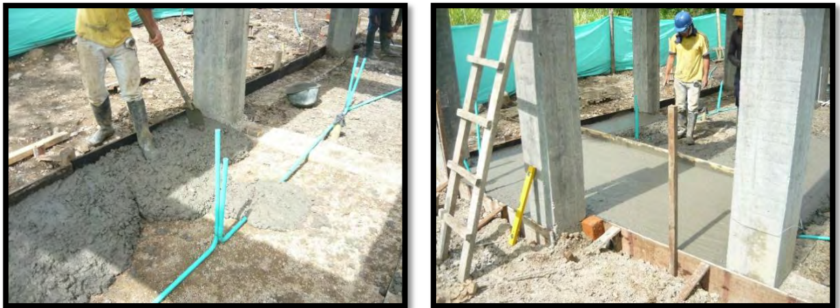
Figura 18. Construcción placa de contrapiso.
