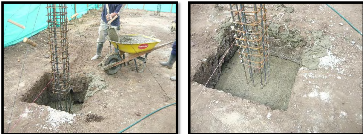
Figura 10. Construcción de zapatas.
