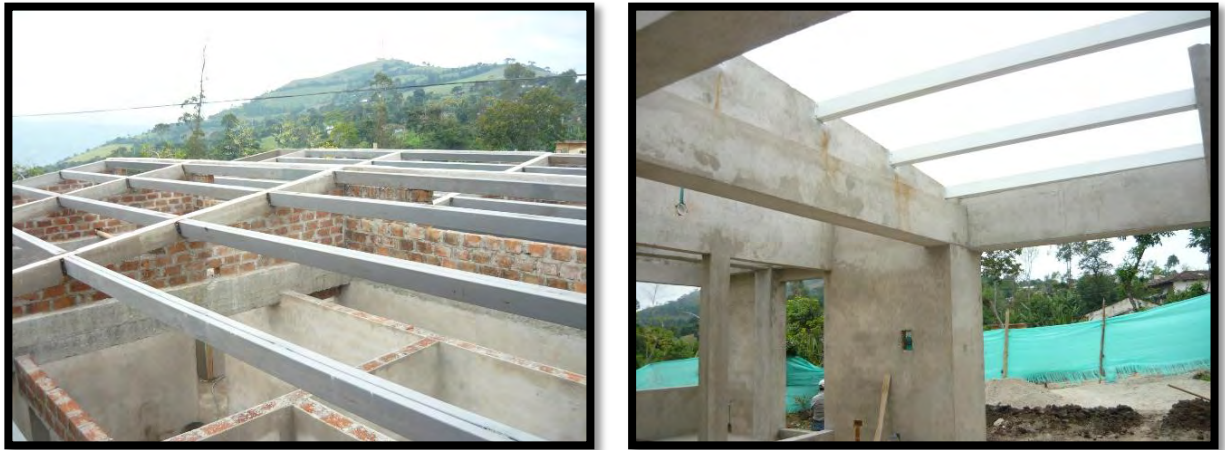
Figura 25. Estructura metálica de cubierta.
