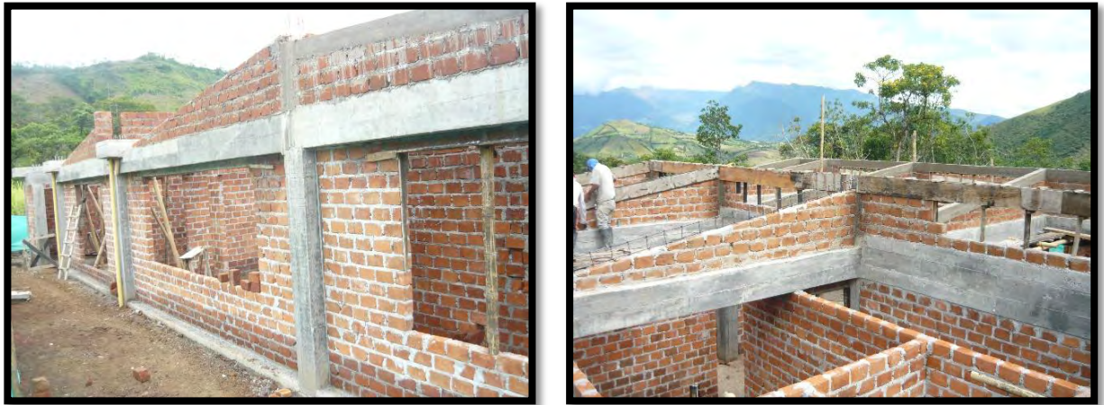
Figura 21. Construcción de tímpanos
