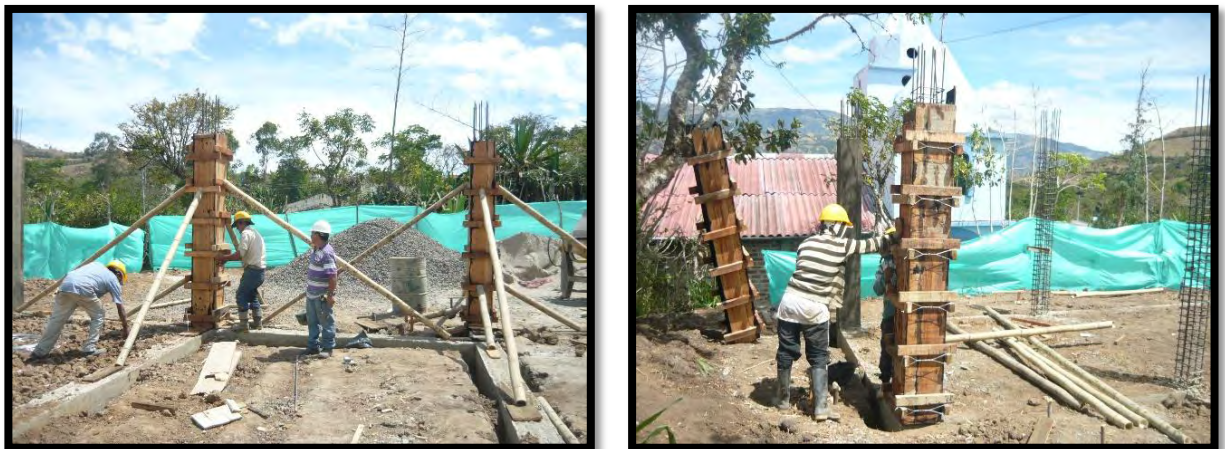
Figura 12. Construcción de columnas.
