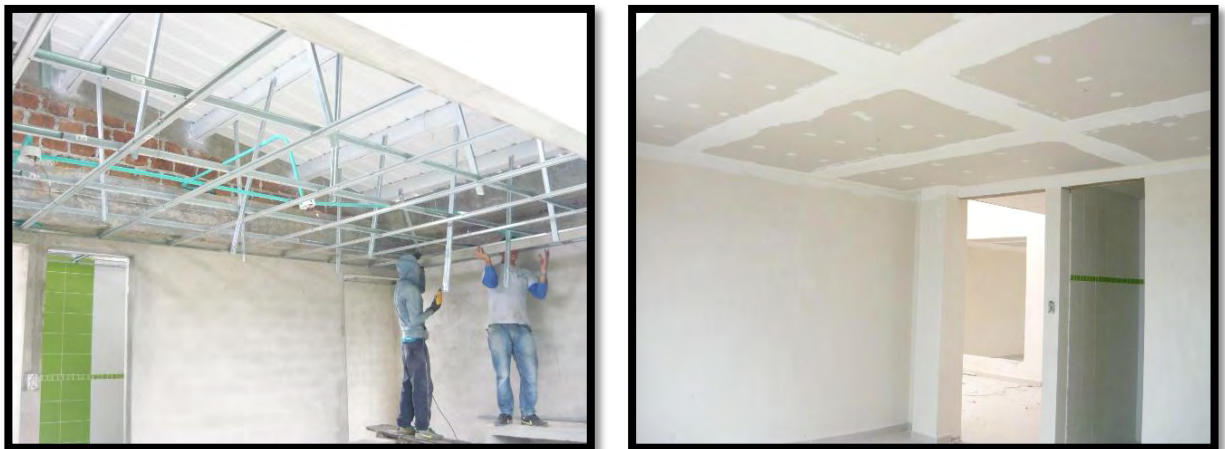
Figura 29. Instalación de cielo raso en drywall.
