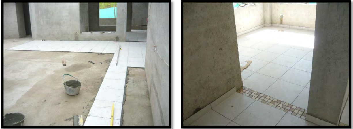
Figura 28. Instalación de enchapes de pisos.
