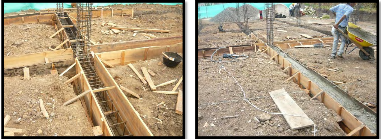
Figura 11. Construcción de vigas de cimentación.
