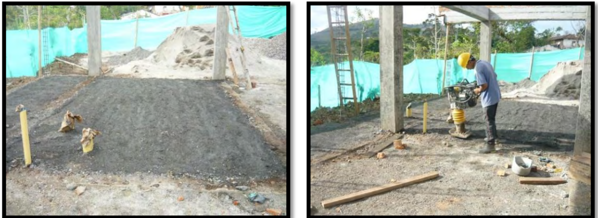
Figura 16. Relleno en recebo compactado.
