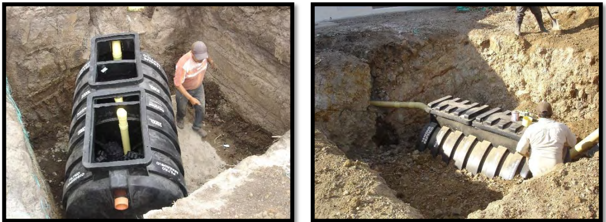
Figura 33. Instalación tanque séptico integrado.
