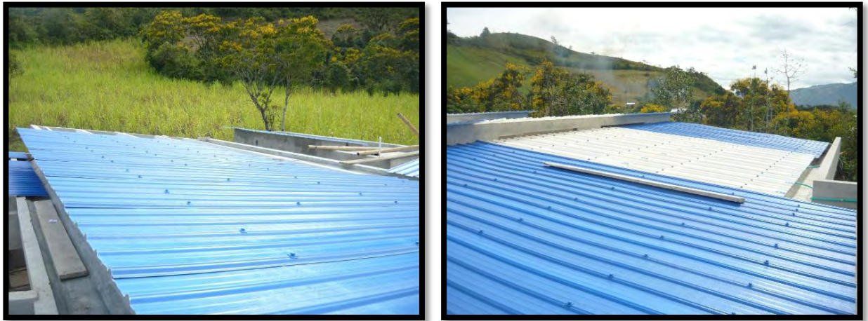
Figura 26. Instalación de cubierta termo-acústica.
