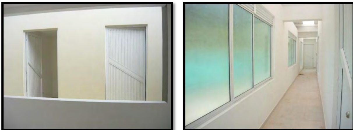
Figura 31. Instalación carpintería de aluminio.
