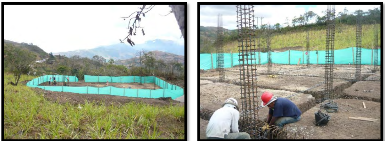
Figura 5. Excavaciones para cimentación.
